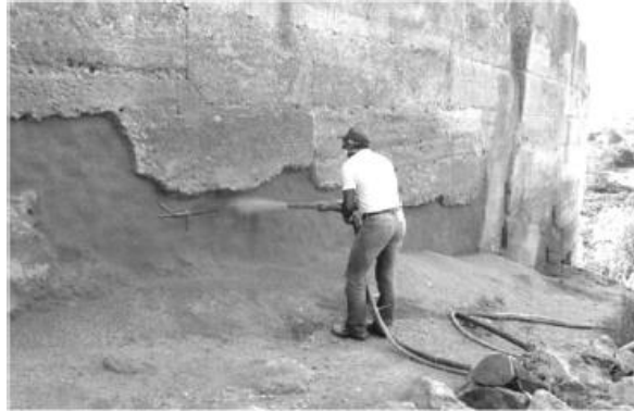
Figura 2.8: Reparação do Castelo de Paderne através da técnica de projeção de terra (Costa, et al., 2008).
