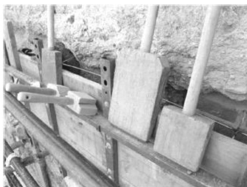
Figura 2.6: Reparação de uma parede do Castelo de Paderne por compactação local de terra (Costa, et al., 2008).
