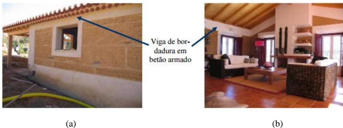
Figura 2.13: Edificações em Odemira reforçadas com vigas de bordadura em betão armado: (a) habitação; (b) habitação para turismo (Gomes, et al., 2008).
