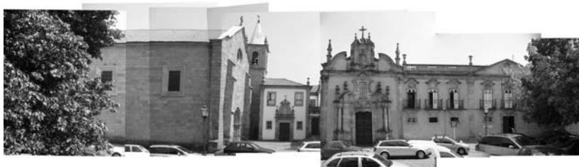
Fig.7 – Frente do Convento de S. Francisco (antes da intervenção).
