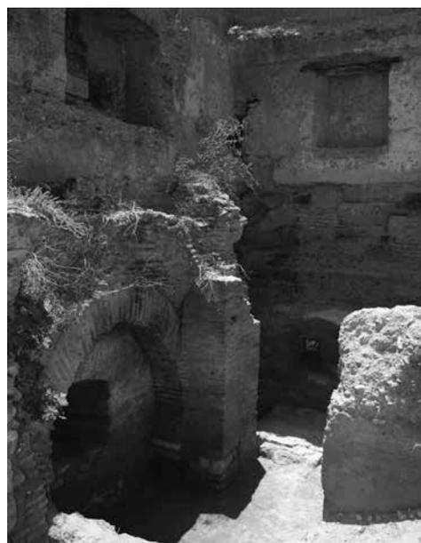
Fig. 03 – Interior do Baluarte do Raio (Azamor), vendo-se o arco em ferradura medieval sobre o qual assenta a estrutura portuguesa
