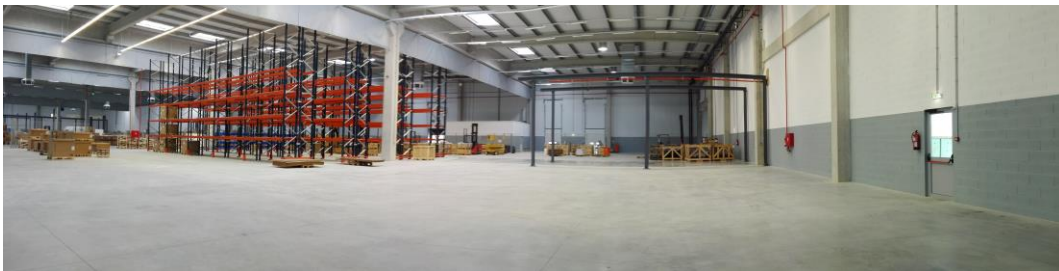
Figura 48- Novo armazém após concluídas as operações de montagem de racks afetas à área de Revenda.
