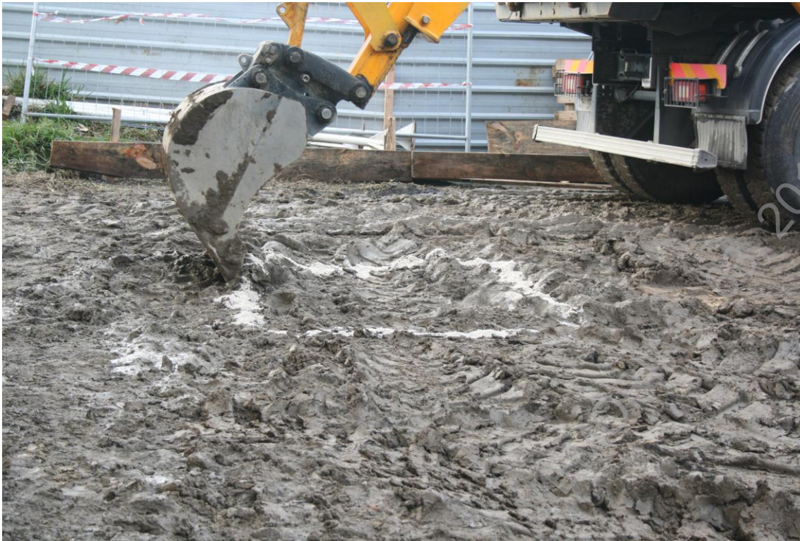
Foto 42 (BRA15ACP_IMG_6781) - Acompanhamento do desaterro para implantação das sapatas na sondagem 5
