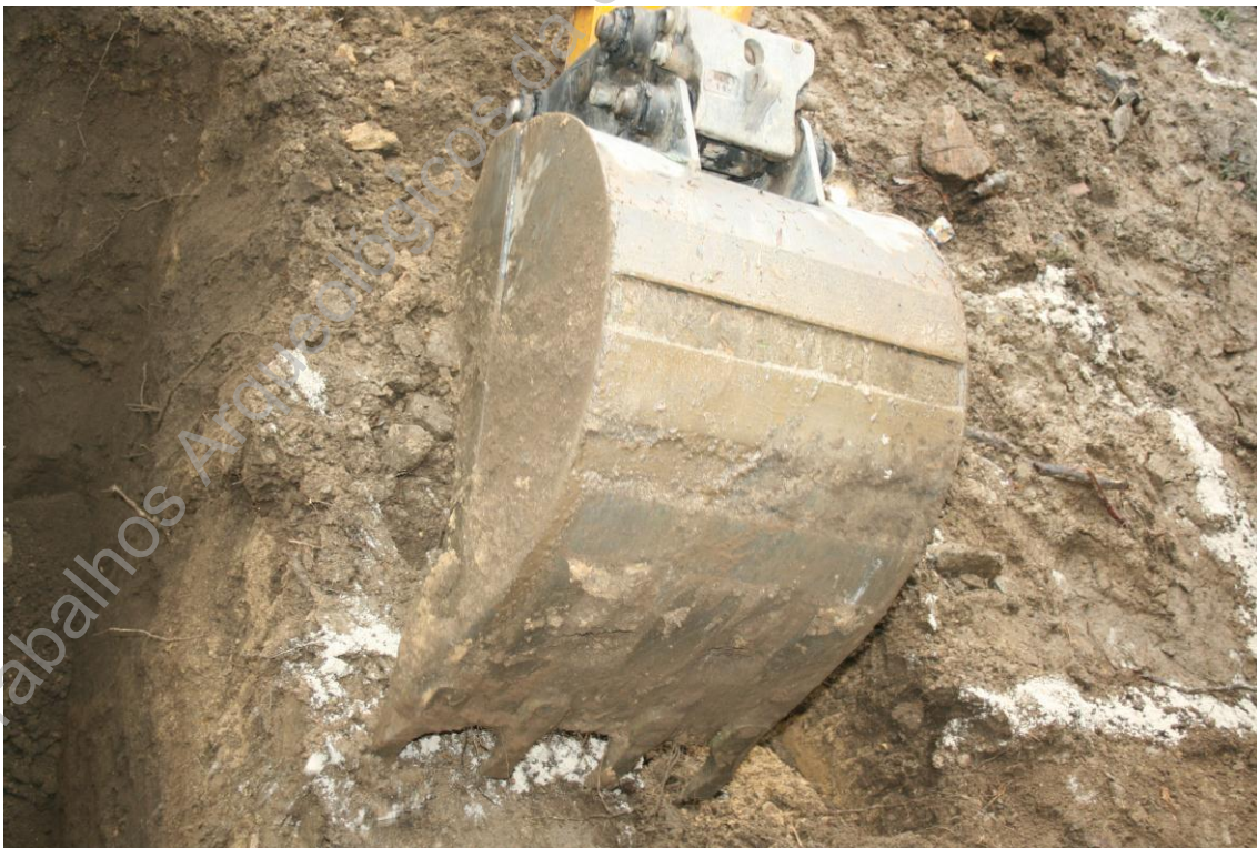
Foto 43 (BRA15ACP_UAUM-IMG_6767) Pormenor do desaterro na sondagem 5
