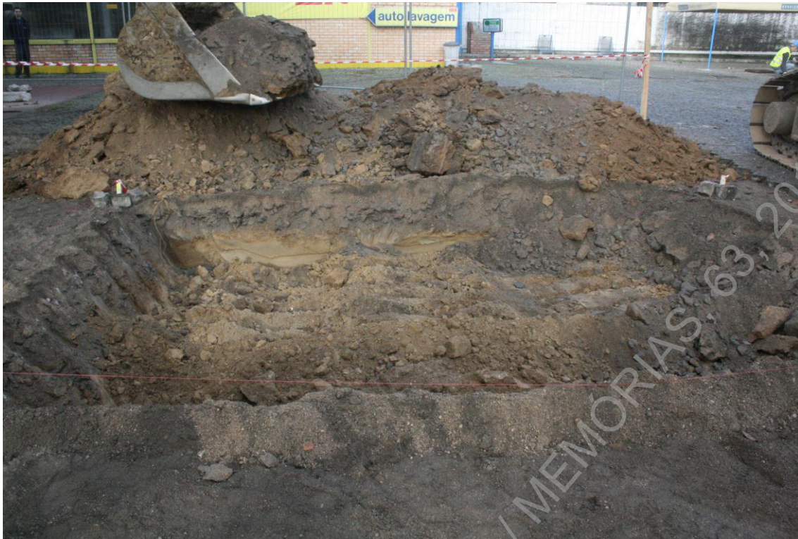
Foto 27 (BRA15ACP_IMG_6414) - Abertura da sondagem 4
