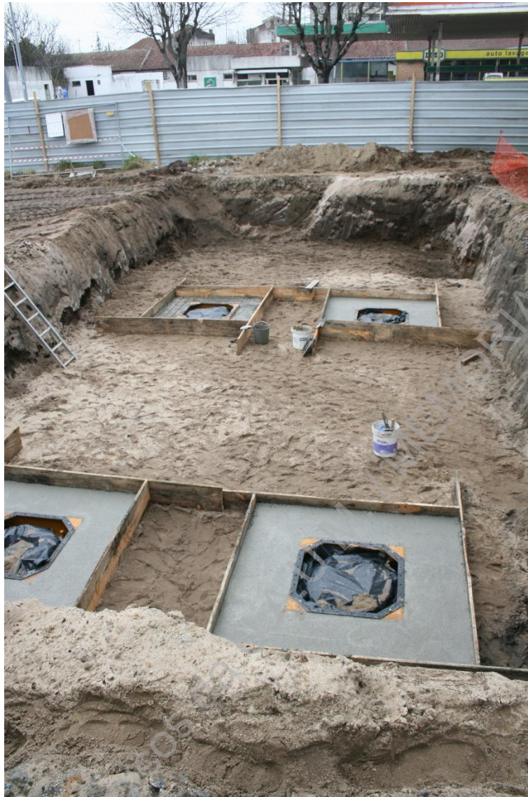
Foto 39 (BRA15ACP_IMG_6711) - Aspeto da vala com a implantação dos tanques de combustível
