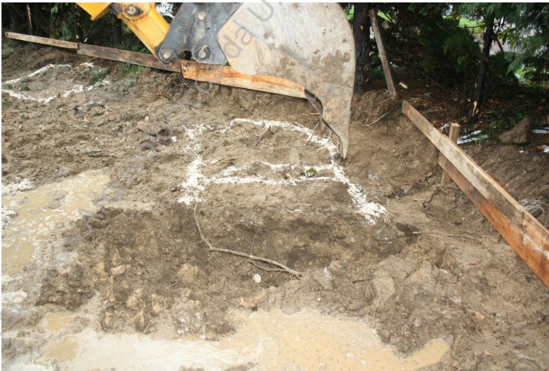
Foto 41 (BRA15ACP_IMG_6764) - Acompanhamento do desaterro mecânico para a implantação das sapatas na sondagem 5
