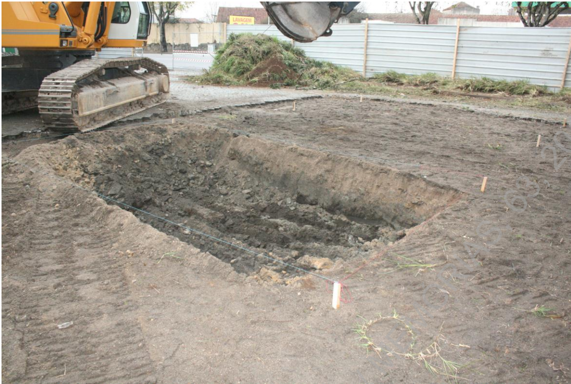
Foto 3 (BRA15ACP_IMG_6190) - Vista geral da sondagem 1
