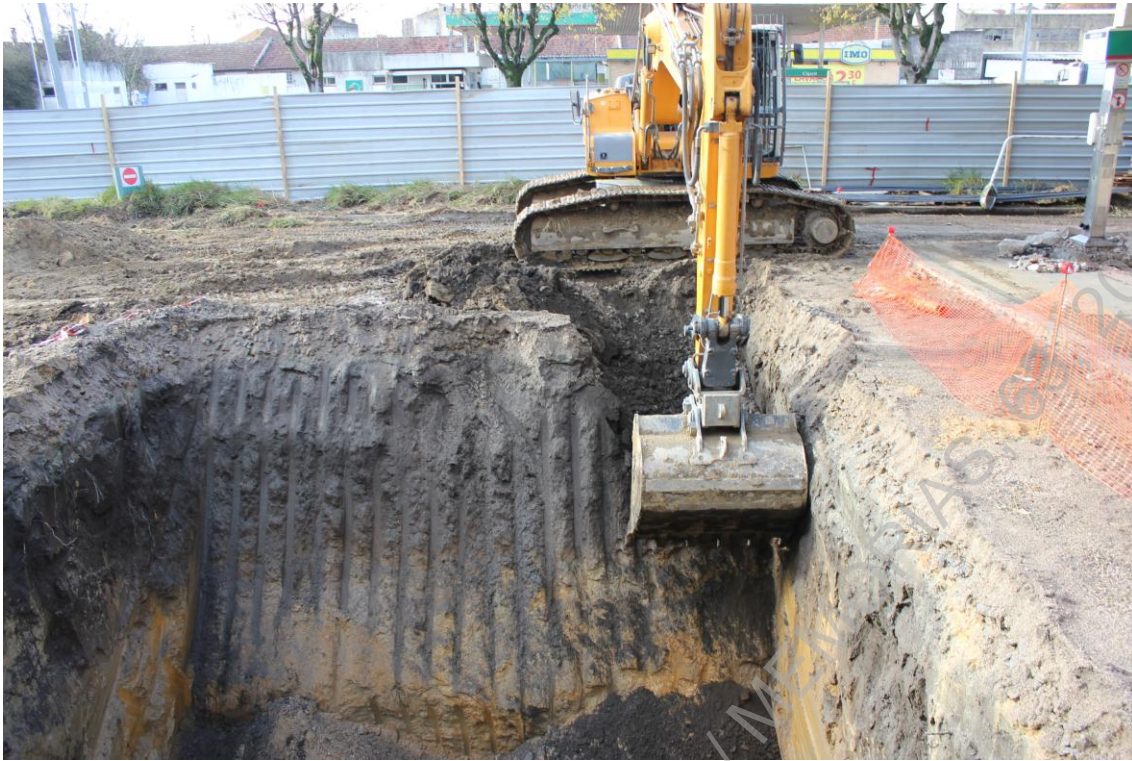
Foto 37 (BRA15ACP_IMG_6647) Acompanhamento do desaterro para colocação dos tanques de combustível (entrada)
