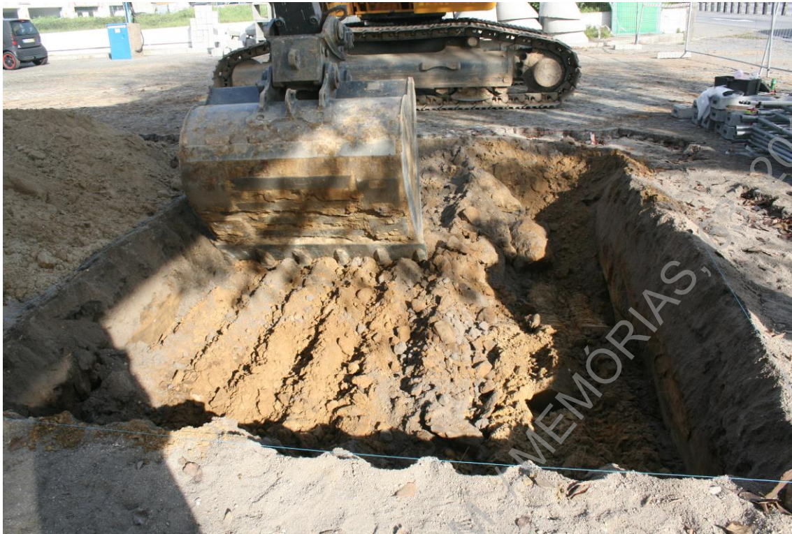
Foto 19 (BRA15ACP_6462) - Abertura da sondagem 3
