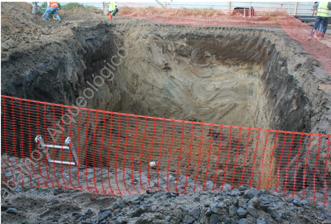
Foto 38 (BRA15ACP_IMG_6647) – Vista geral do desaterro para colocação dos tanques de combustível (entrada)
