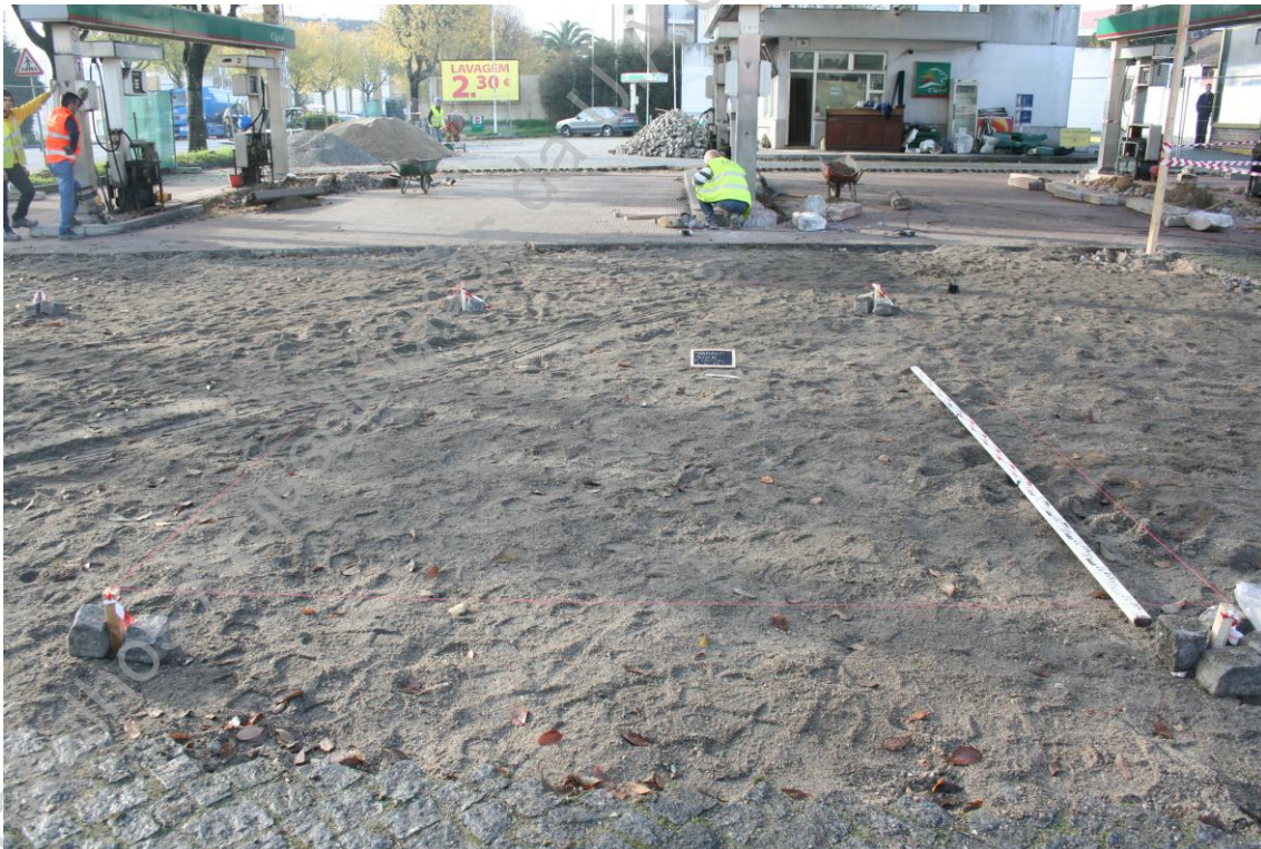
Foto 26 (BRA15ACP_IMG_6406) - Vista geral da sondagem 4
