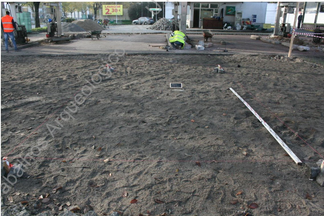
Foto 18 (BRA15ACP_IMG_6408) - Vista geral da sondagem 3
