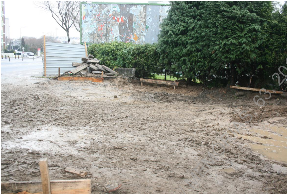
Foto 40 (BRA15ACP_IMG_6763) – Perspetiva geral da sondagem 5
