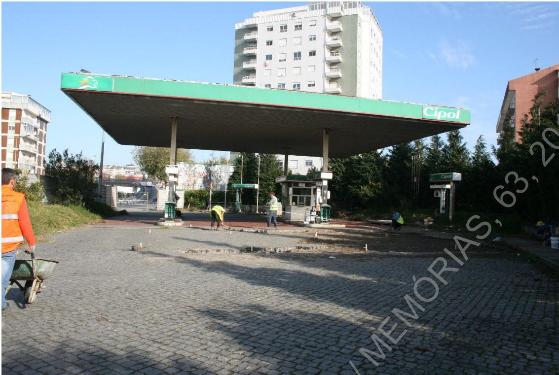
Foto 1 (BRA15ACP_IMG_6152) - Vista geral da área das Sondagens 1 e 2
