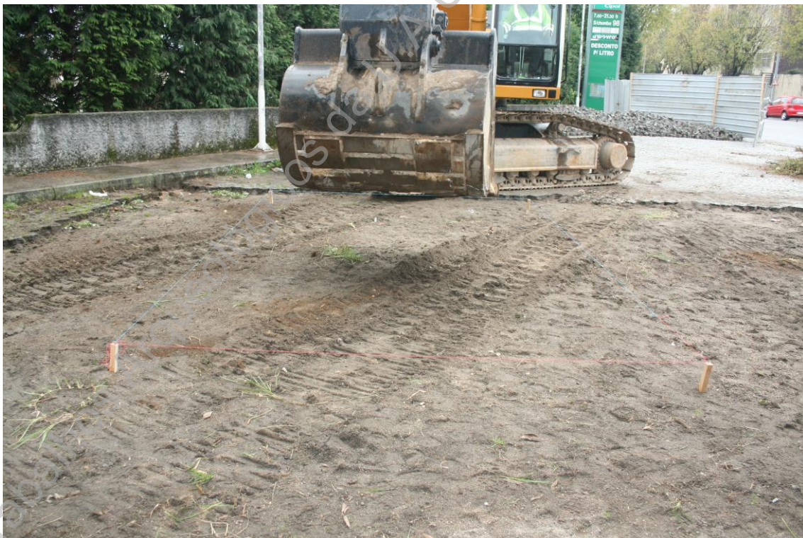
Foto 2 (BRA15ACP_IMG_6174) - Vista geral da sondagem 1
