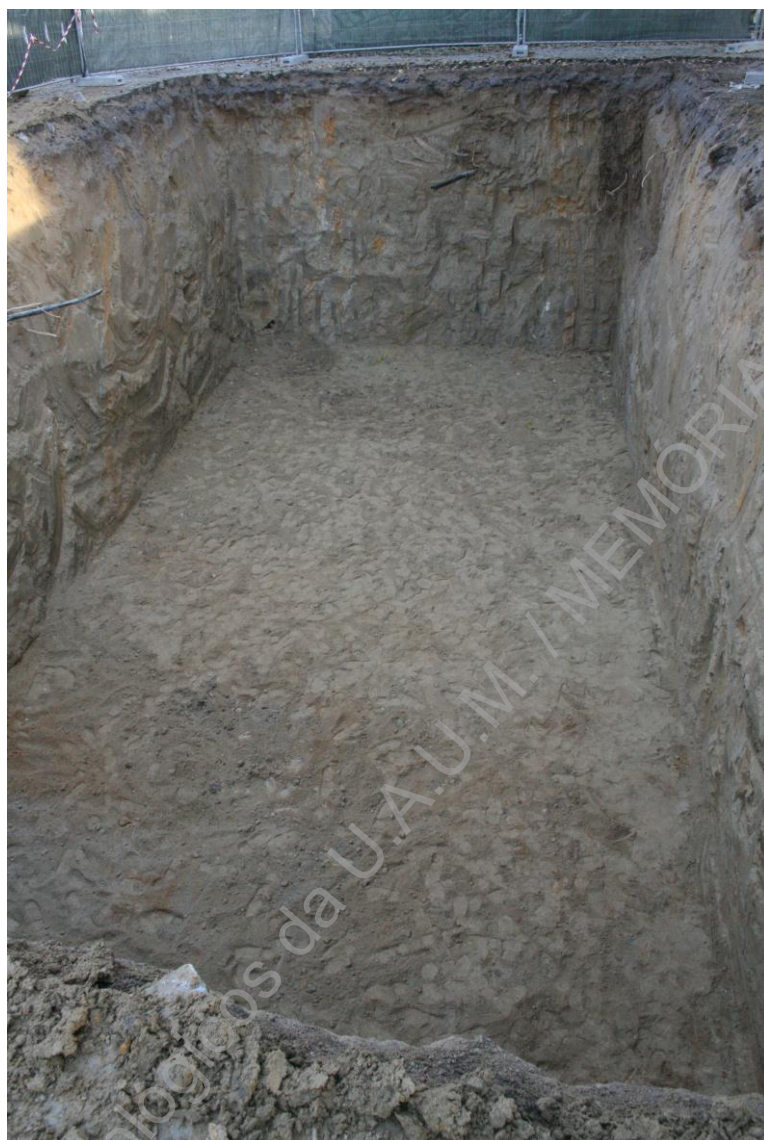
Foto 36 (BRA15ACP_IMG_6649) - Vista geral do desaterro
