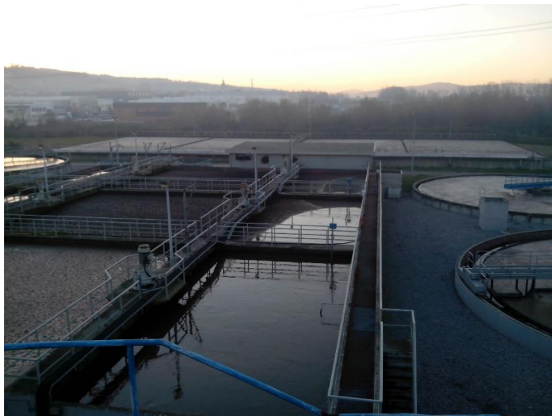
Figura 28 - Tanques anóxicos da ETAR do sistema Cidade.
