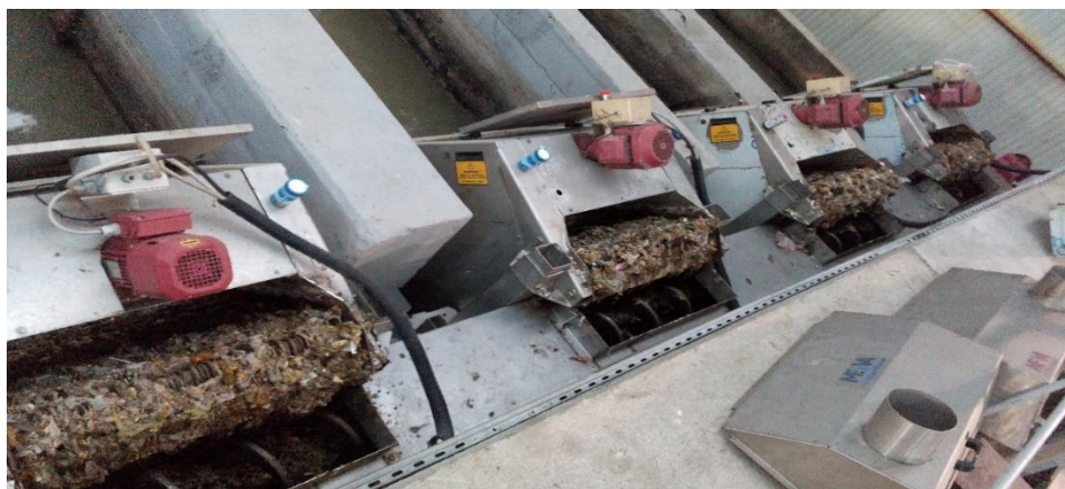
Figura 20 - Sistema de gradagem da ETAR do sistema Cidade.
