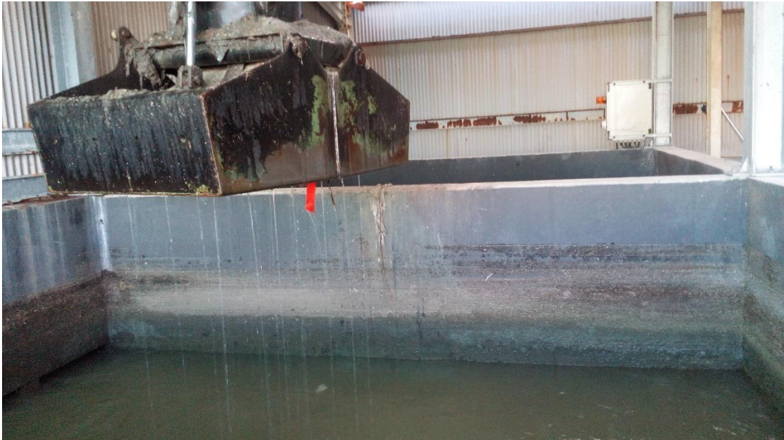
Figura 18 - Caixa de recepção de águas residuais da ETAR do sistema Cidade.
