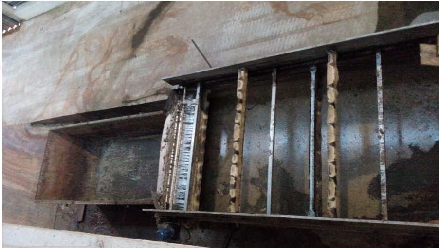
Figura 24 - Escumador presente da ETAR do sistema Cidade.
