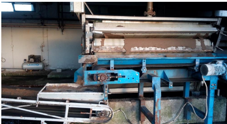
Figura 36 - Desidratação de lamas, da ETAR do sistema Cidade.
