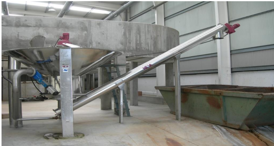
Figura 23 - Lavagem de areias presente da ETAR do sistema Cidade.
