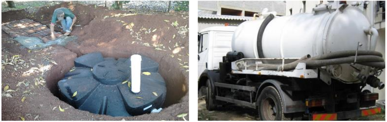
Figura 3 - Exemplo de uma fossa séptica estanque e veículos cisterna utilizados na sua limpeza.
