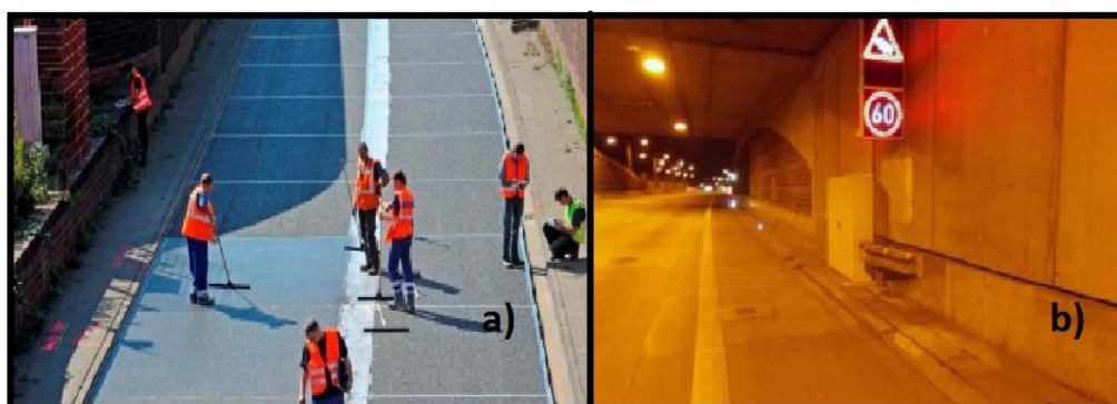
Figura 15 - Campos de aplicação de nanopartículas: a) aplicação num troço de estrada, através do espalhamento de uma solução; b) túnel onde foram aplicadas as nanopartículas (Baum et al. 2010)
