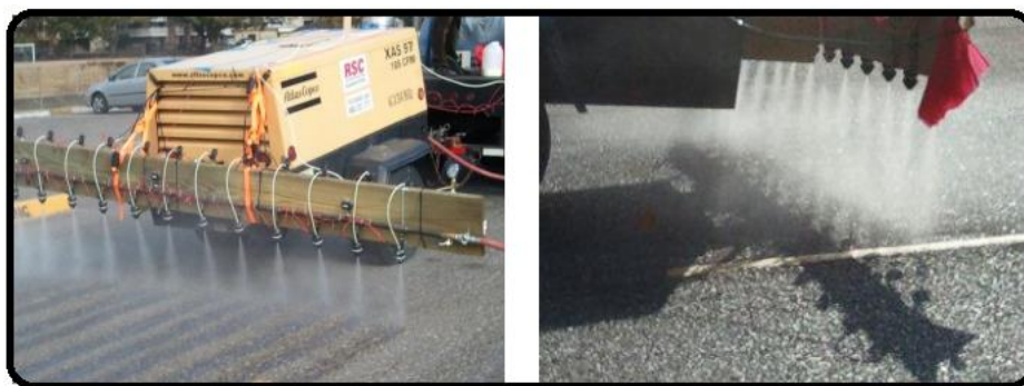
Figura 17 - Método de aplicação das nanopartículas de TiO_2 (Hassan & Okeil 2011)
