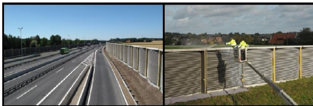
Figura 16 - Aplicação da solução de nanopartículas em barreiras acústicas através de aspersão (Baum et al. 2010)
