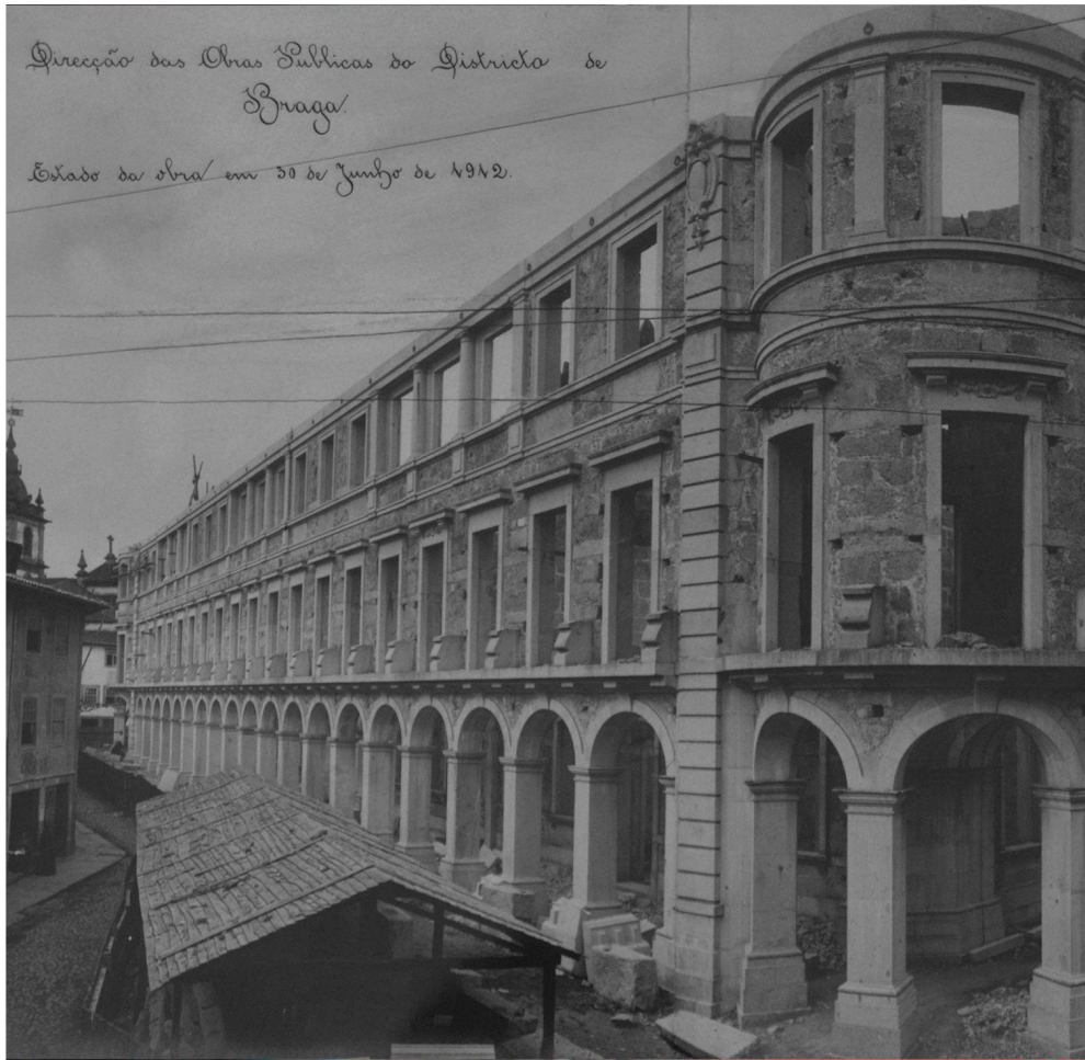
Fotografia de época da construção do Edifício do Castelo.
