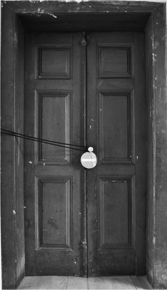
Fotografia do autor. Uma de muitas portas do Edifício do Castelo.
