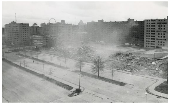
Fotografias de Lee Balterman. Demolição de um dos blocos habitacionais Pruitt-Igoe.
