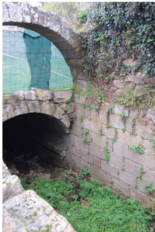
Foto 25: Pormenor do arco sobre o aqueduto subterrâneo.
