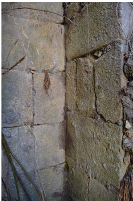
Foto 8: Alçado A08, pormenor do encosto do tramo de parede UE6066 a arcaria UE6051, vista Sudoeste.
