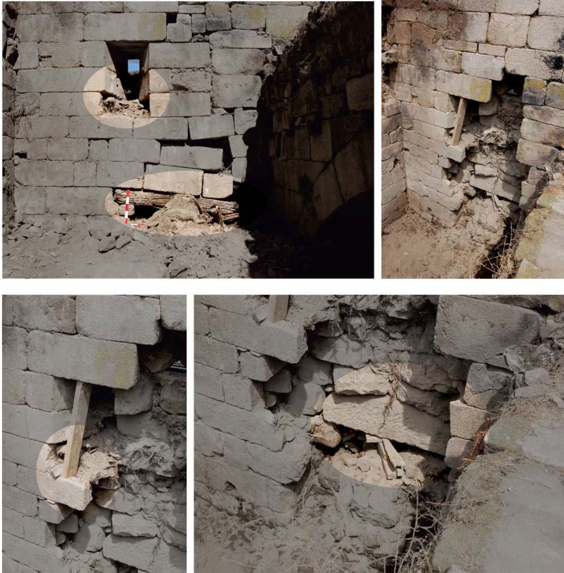
Foto 12: Alçado 08 pormenor dos vãos de fresta UE6159 e porta UE6160 (AC78) (1387_05062006). Foto 13: Idem após o desaterro à direita superior (1416_12062006). Foto 14: Pormenor da fresta UE6159 após o desaterro (1419_12062006). Foto 15: Pormenor do lintel face interior do vão UE6160 após desaterro e a remoção do lintel em madeira (1417_12062006). Fotos retiradas da base de dados Arqueo.
