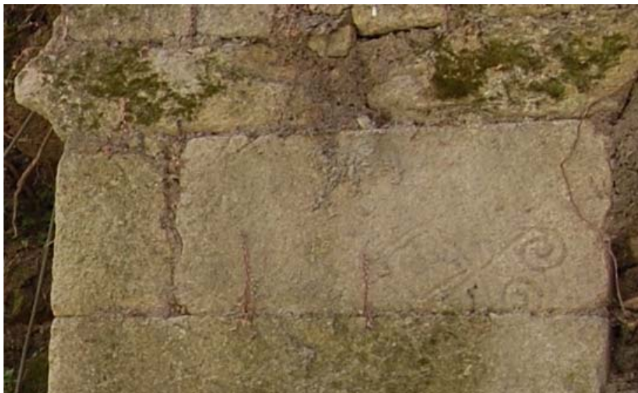
Foto 7: Alçada A09, pormenor do silhar com marca de canteiro cortada, inédita (541_DSC_1940).
