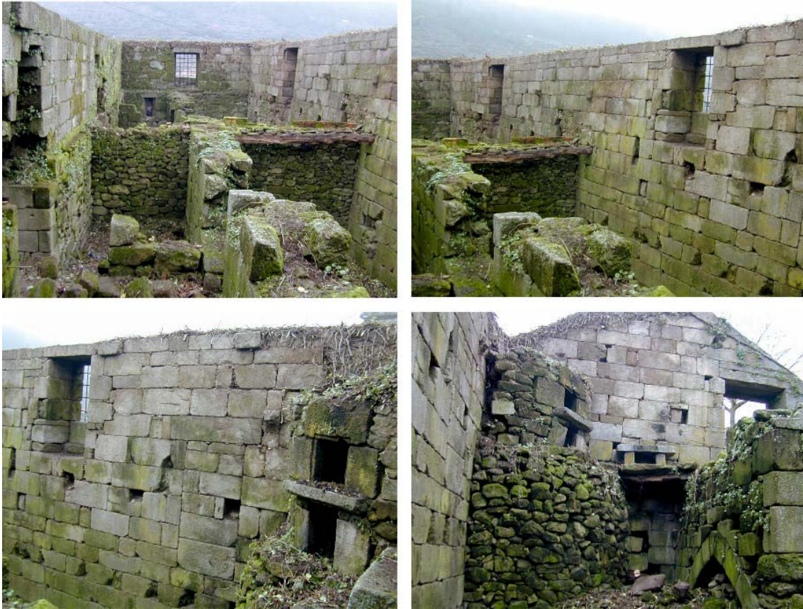
Foto 19: Aljube interior, parede divisória (UE6143) antes das obras de 2006 (foto 160 da base de dados Arqueo) à esquerda superior. Foto 20: Alçado A05 antes das obras de 2006, (foto 157 da base de dados Arqueo) à direita superior. Foto 21: Alçado A05, pormenor do forno (UE6144) (foto 158 da base de dados Arqueo) à esquerda inferior. Foto 22: Alçado A08, pormenor do forno com embasamento (UE6144, 6145), do piso (UE6136) (foto 161 da base de dados Arqueo) à direita inferior.
