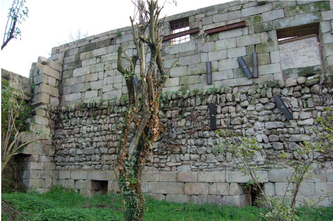
Foto 24: Pormenor da parede Norte exterior do Aljube com os vestígios do miolo de uma abóbada.
