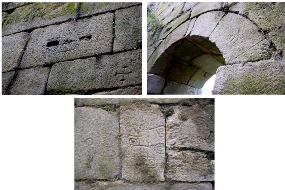
Foto 9: Alçado 05, AC36 pormenor de silhar com negativos de um instrumento para elevação à esquerda superior (347_DSC_0940). Foto 10: Alçado 05, AC36, pormenor do saímel da ombreira Este, com duas marcas de canteiro à direita superior (338_DSC_0923). Foto 11: Alçado 05, AC36, pormenor de um silhar com marca de canteiro cortado ao centro inferior (228_DSC_0465).
