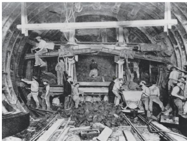
Fig.17- Eretor de segmentos [40]
