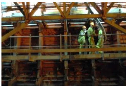
Fig.318-Posturas para montagem de cofragem [31]
