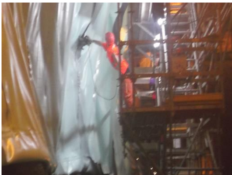
Fig.301-Postura instável para montagem de tela [31]
