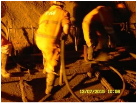
Fig.371-Vibração de betão em sapata de hasteal[31]
