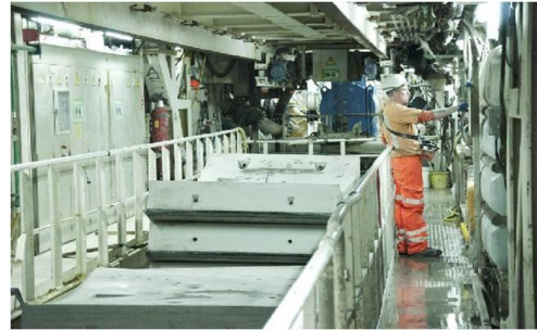
Fig.396-Zona de receção de aduelas [277]
