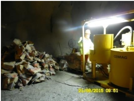
Fig.147-Sacos de cimento para estabilização [31]
