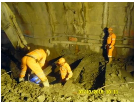
Fig.212-Trabalhos junto a face escavação [31]
