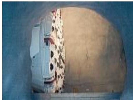
Fig.349-Cabeça de corte [31]
