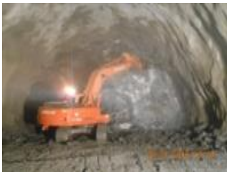
Fig.323-Trabalhos em face de escavação [31]
