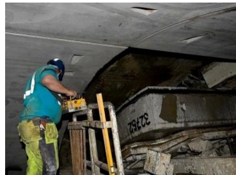
Fig.119-Posicionamento de aduelas[236]
