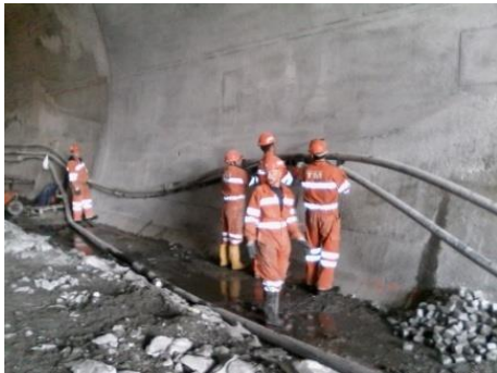
Fig.204-Reposicionamento de tubagens [31]
