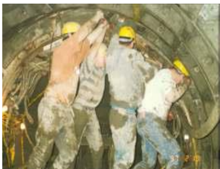
Fig.287-Montagem de cambotas [284]
