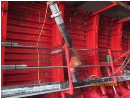
Fig.307-Manuseamento mangueira de betão [31]
