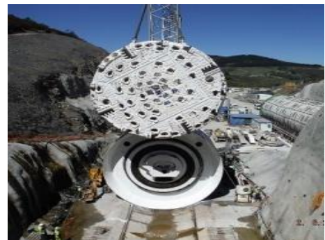
Fig.231-Movimentação cabeça de tuneladora [58]
