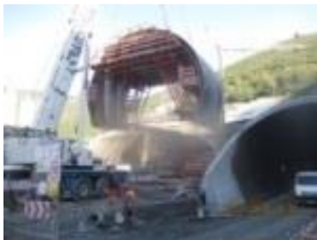
Fig.230-Movimentação de molde de cofragem [31]
