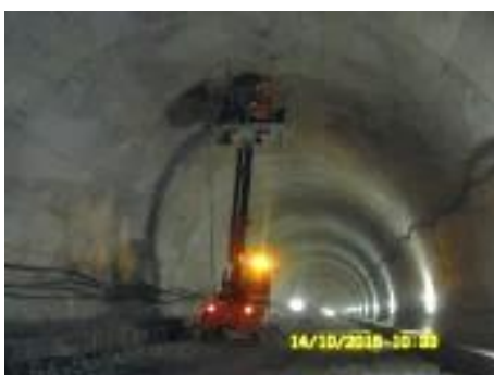
Fig.242-Reparação de betão [31]
