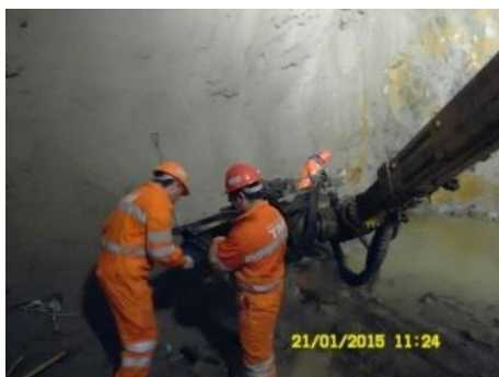
Fig.222-Reparação de varas [31]
