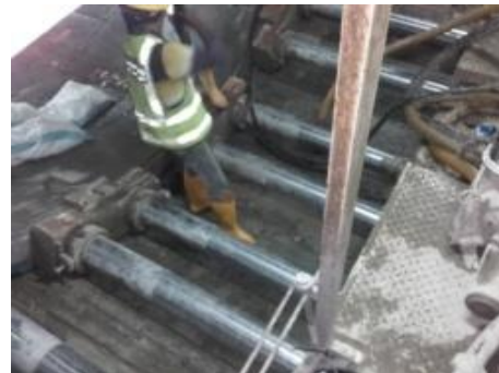
Fig.304-Trabalhos junto a grippers [277]
