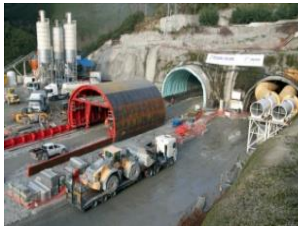
Fig.49-Montagem de equipamento em estaleiro [31]
