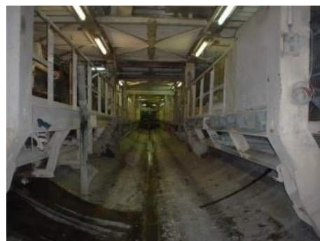
Fig.364-Pavimento com aduela betonada [334]
