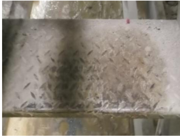
Fig.280-Piso antiderrapante [31]
