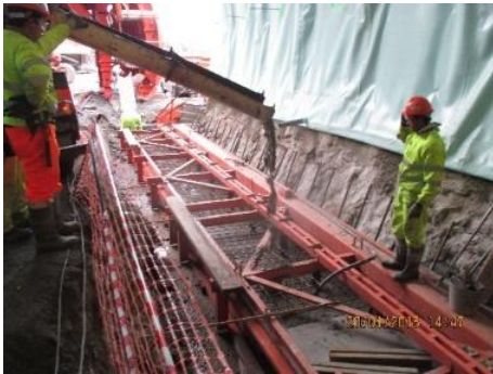
Fig.133-Cofragem de rebaixo[31]
