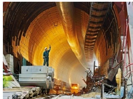
Fig.136-Chegada de aduelas a obra[319]
