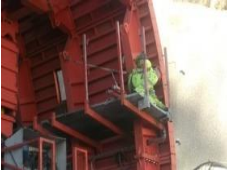
Fig.257-Montagem de molde betonagem [31]
