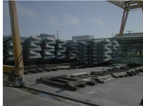
Fig.357-Zona de preparação de aduelas [334]
