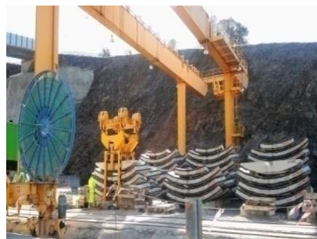
Fig.207-Pórtico de movimentação aduelas [58]
