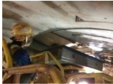
Fig.117-Aplicação de aduela [207]
