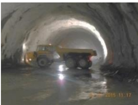
Fig.382-Remoção de escombros [31]
