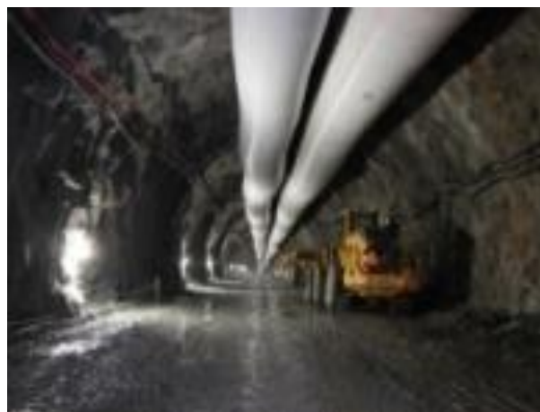
Fig.3-Túnel do Marão–vista geral [31]
