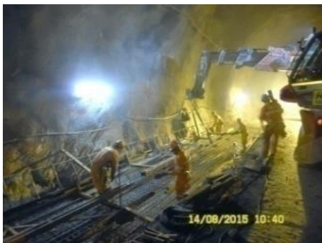
Fig.291-Movimentação de cofragem [31]
