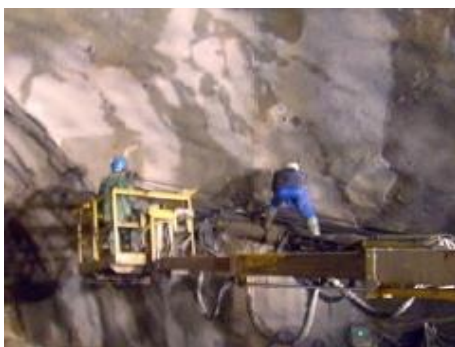
Fig.277-Manutenção de braço de jumbo [234]
