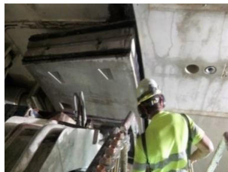
Fig.152-Aplicação de aduela [58]
