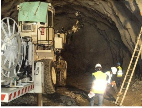
Fig.251-Escada em face escavação [31]
