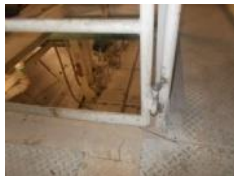
Fig.300-Rodapés junto a pavimento [58]
