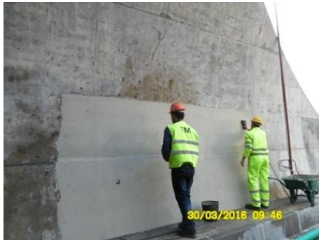
Fig.198-Reparação de revestimento definitivo [31]
