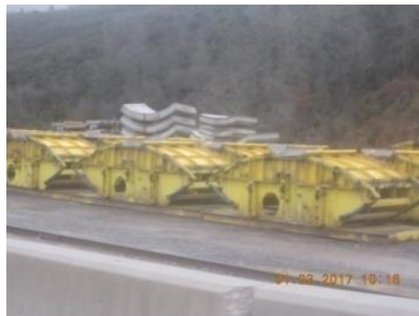
Fig.195-Zona exterior de betonagem [58]
