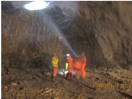
Fig.214-Análise geológica/geotécnica de escavação [31]
