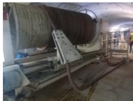
Fig.113-Cabo elétrico retrátil [58]
