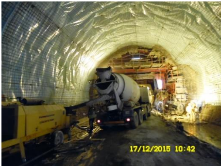
Fig.238-Autobetoneira para betonagem [31]
