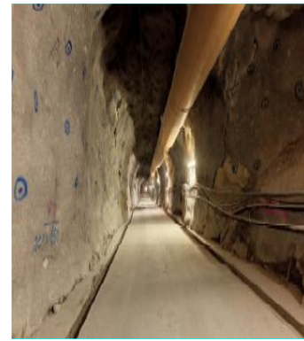
Fig.378-Soleira betonada [277]
