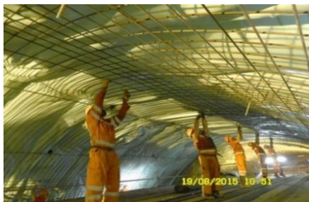
Fig.317-Montagem de armadura de abóbada [31]
