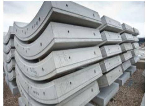
Fig.239-Aduela pré-fabricada [236]
