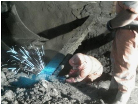
Fig.192-Corte de perfil de pé de cambota [31]
