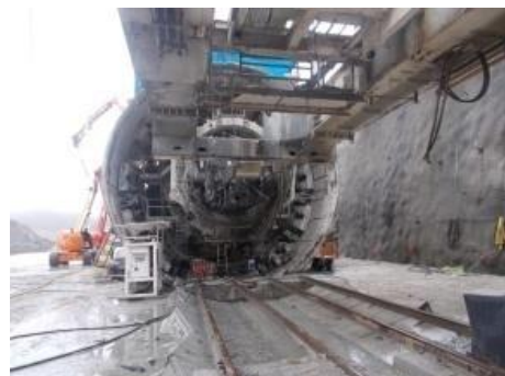
Fig.166-Interior de cabeça de corte[58]
