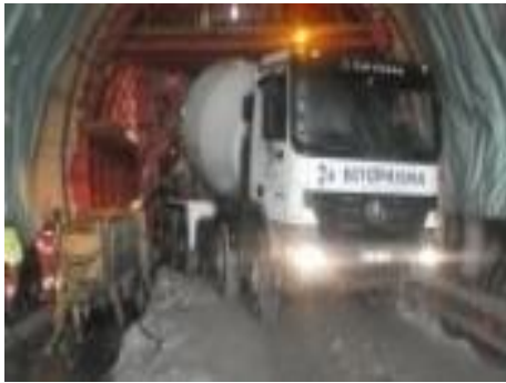
Fig.403-Betonagem de molde [31]
