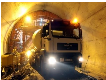
Fig.388-Finalização de betonagem [31]
