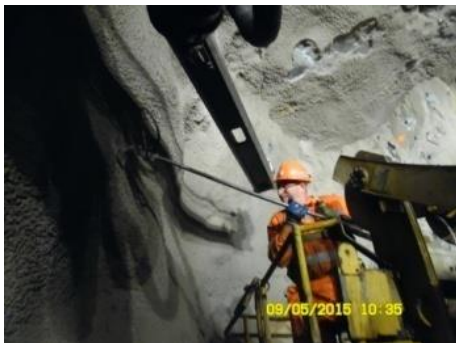
Fig.281-Montagem de dispositivo de estabilização [31]
