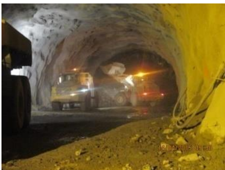
Fig.125-Carregamento de escombros [31]
