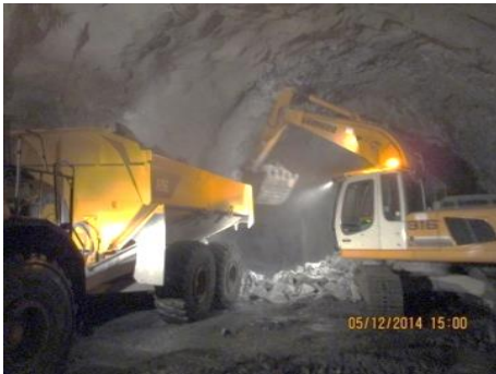
Fig.350-Carregamento de escombro [31]
