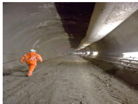
Fig.250-Estado de pavimento após aterro [236]
