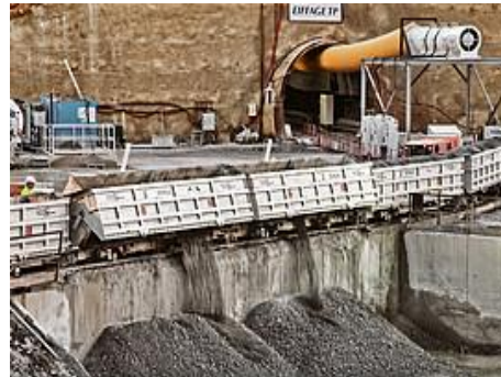
Fig.351-Vagões com escombro [319]
