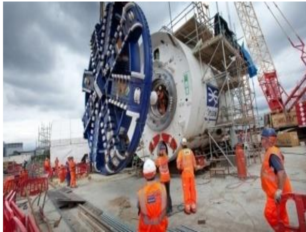
Fig.51-Montagem de cabeça de tuneladora [236]
