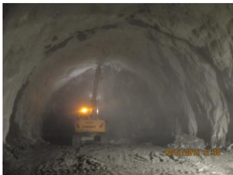
Fig.177-Levantamento de poeiras em picagem [31]
