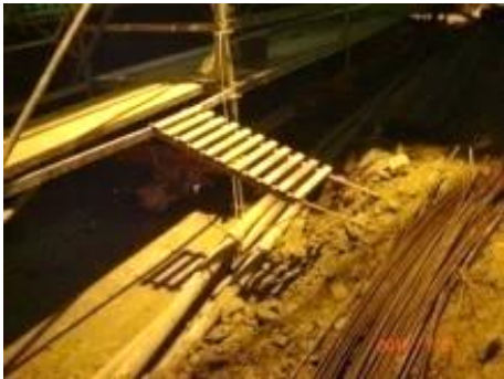
Fig.269-Acesso a estrutura de montagem [31]
