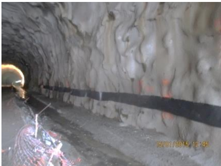
Fig.380-Hasteais ainda não revestidos [31]
