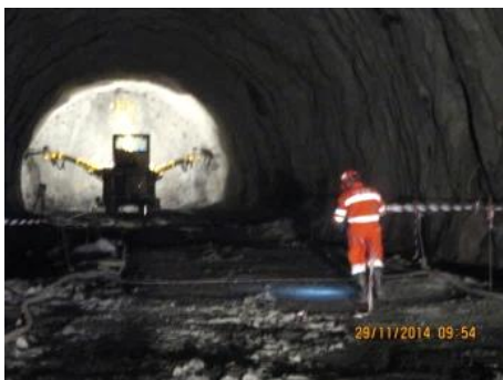
Fig.224-Hasteais e abóbada não revestidos [31]
