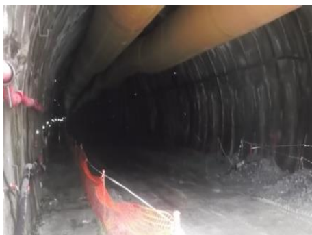
Fig.120-Mangas de ventilação[31]
