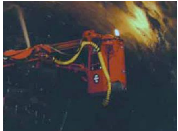
Fig.181-Cabine fechada junto a abóbada [124]
