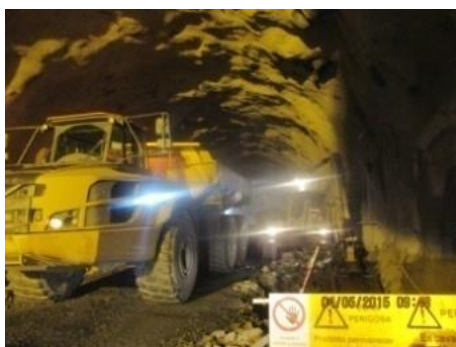
Fig.173-Circulação de dumpers [31]
