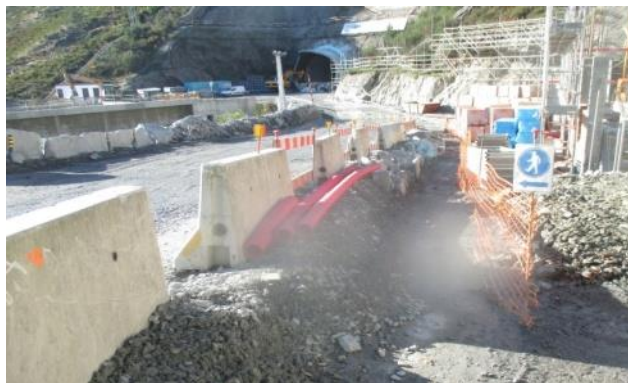
Fig.77-Separação vias de circulação [303]
