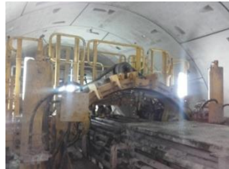
Fig.245-Plataformas de trabalho tuneladora [207]
