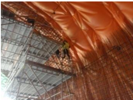
Fig.259-Montagem de armaduras abóbada [31]
