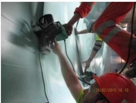
Fig.386-Termosoldadura de telas [31]
