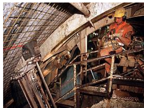
Fig.132-Plataforma aplicação de pregagens [319]
