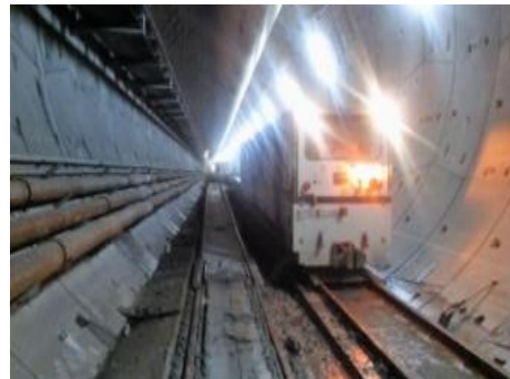
Fig.381-Paredes revestidas em tuneladora [58]
