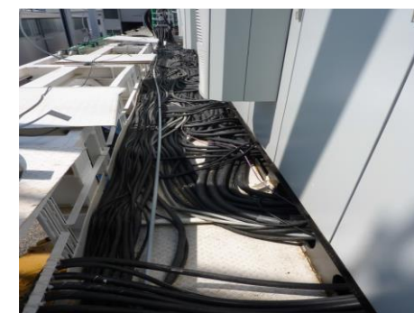
Fig.115-Cabos de iluminação [127]
