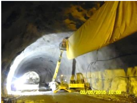
Fig.244-Manutenção de manga ventilação [31]
