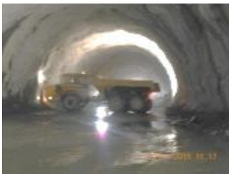
Fig.399-Retirada de escombro [31]
