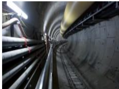
Fig.150-Revestimento final [236]
