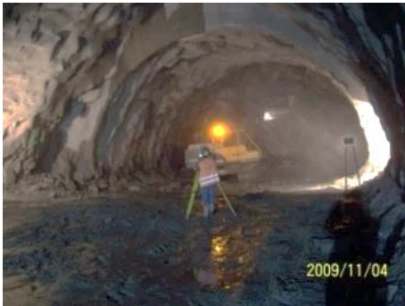
Fig.390-Mapeamento de frente de escavação[31]
