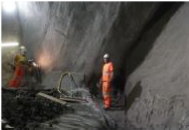
Fig.226-Escavação com face inclinada [38]
