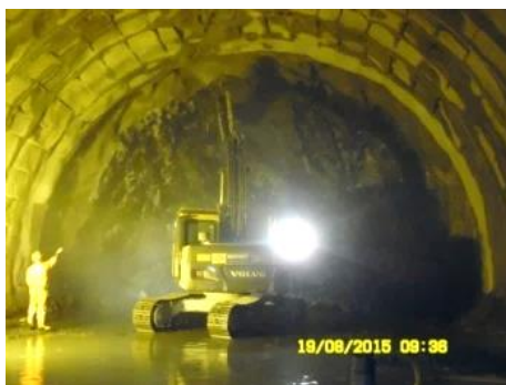
Fig.216-Saneamento mecânico [31]
