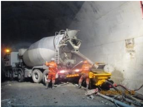
Fig.139-Distribuição de betão [31]
