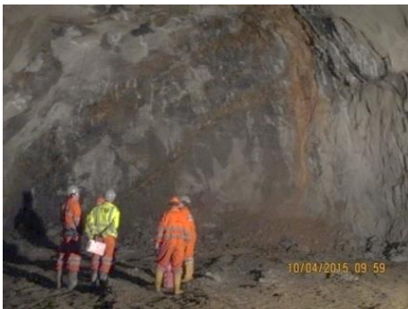
Fig.392-Trabalhadores próximos do maciço [31] ,
