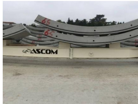
Fig.199-Aduelas já betonadas no exterior [277]
