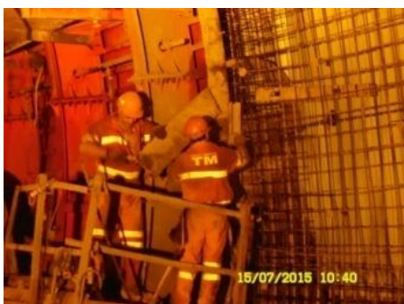
Fig.305-Montagem de cofragem [31]
