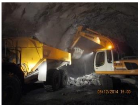
Fig.167-Carga e remoção de escombros [31]
