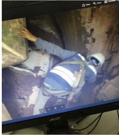
Fig.43-Intervenção em discos de corte [207]
