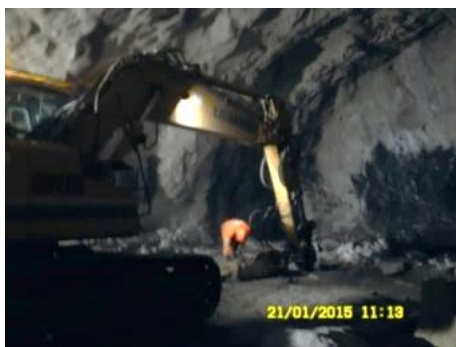
Fig.171-Manobrador fora de cabine [31]
