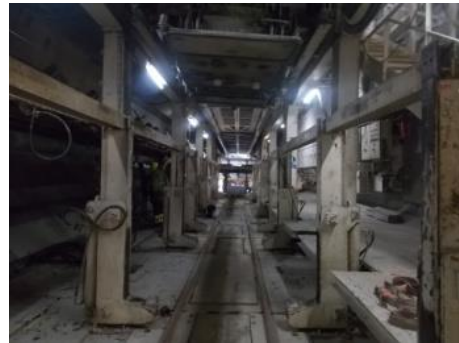
Fig.276-Zona de descarga de materiais [58]
