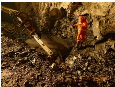
Fig.249-Pavimento com blocos soltos [31]
