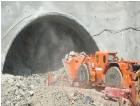
Fig.169-Carregamento de escombro [31]
