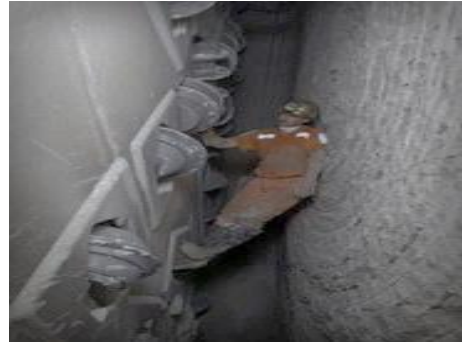
Fig.252-Substituição de discos de corte [206]
