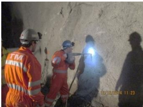
Fig.367-Furação para provete [31]
