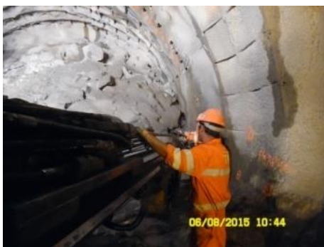
Fig.285-Substituição de varas de furação[31]
