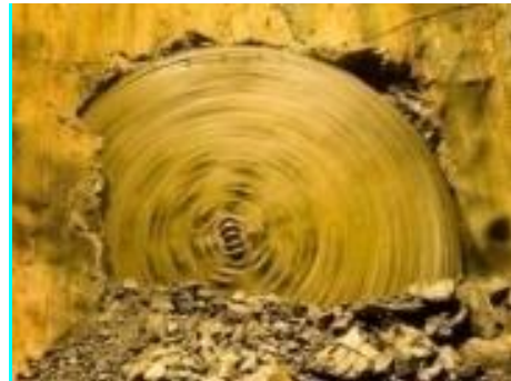
Fig.193-Cabeça de corte [236]
