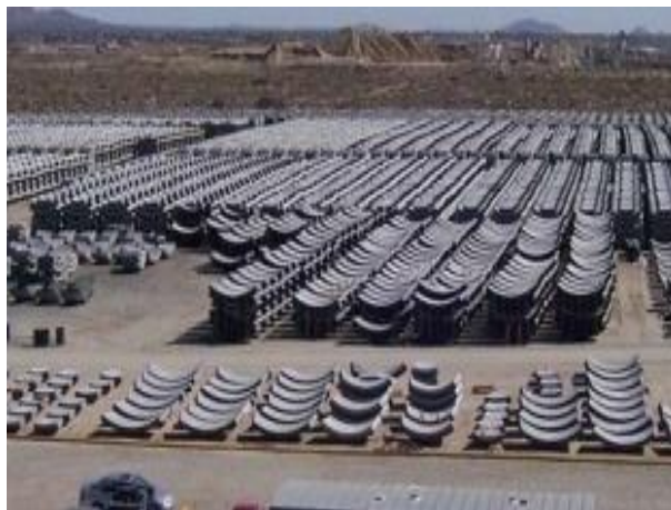
Fig.52-Espaço necessário para armazenamento de aduelas pré-fabricadas [15]
