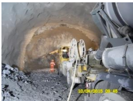
Fig.333-Revestimento primário [31]
