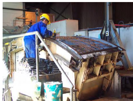
Fig.191-Montagem de cofragem aduela [277]
