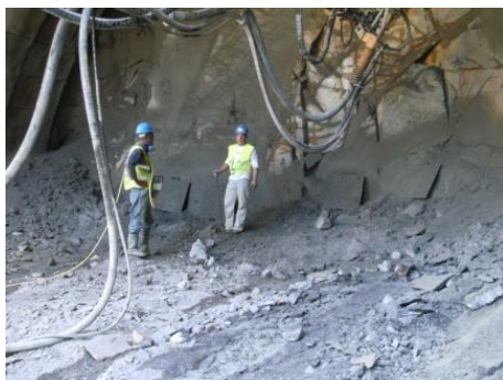
Fig.218-Projeção de betão [31]
