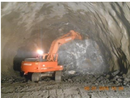
Fig.129-Saneamento mecânico [31]
