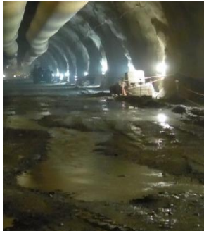
Fig.365-Pavimento com irregularidades [31]
