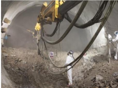
Fig.175-Projeção de betão [236]
