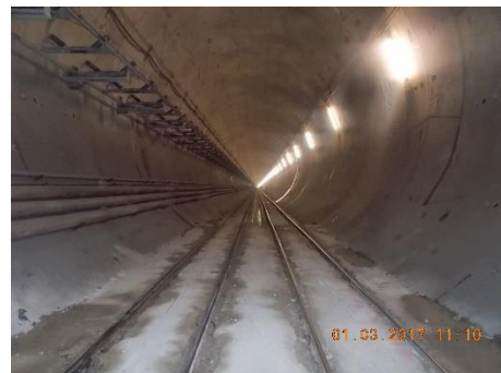
Fig.330-Alinhamento de carris tuneladora[58]
