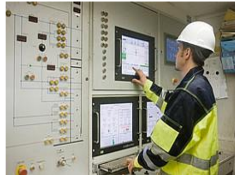
Fig.215-Cabina de controlo de tuneladora [319]
