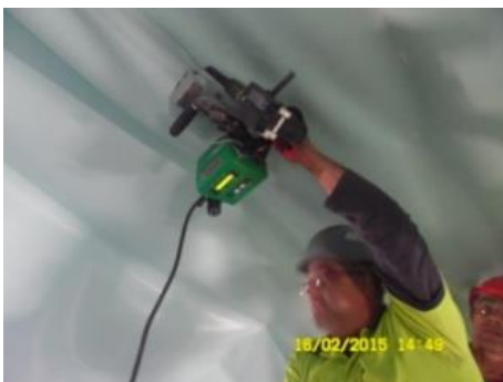
Fig.151-Termossoldadura [31]
