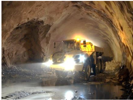
Fig.325-Remoção de escombros com dumper [31]
