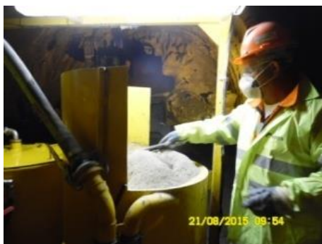
Fig.184-Caldas de cimento para grouting [31]
