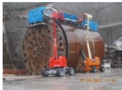
Fig.237-Desmontagem tuneladora [58]
