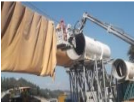
Fig.297-Manutenção de mangas ventilação [31]
