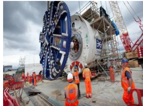
Fig.284-Cabeça de corte [236]
