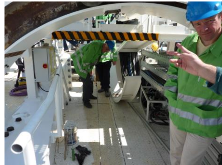
Fig.385-Panorama zona de trabalhos [127]
