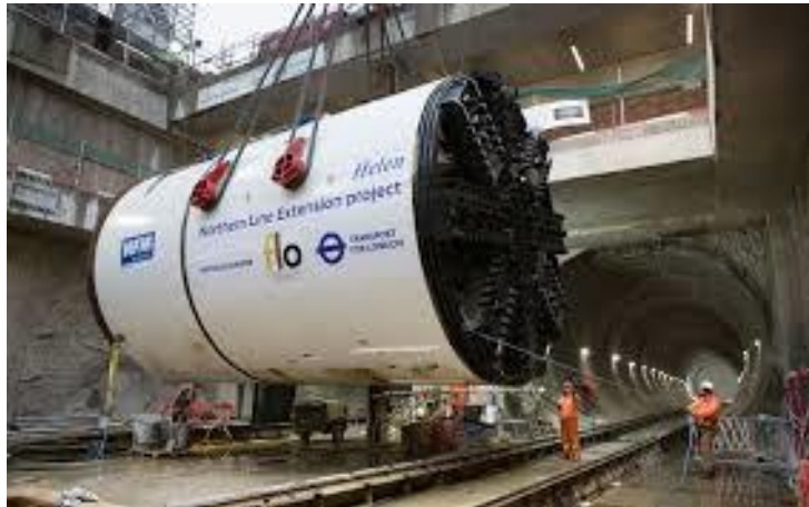
Fig.7-Estaleiro da Northern Line Extension [34]
