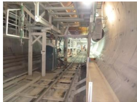
Fig.282-Automatização de tuneladora [58]
