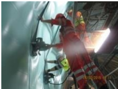
Fig.118-Montagem de telas [31]
