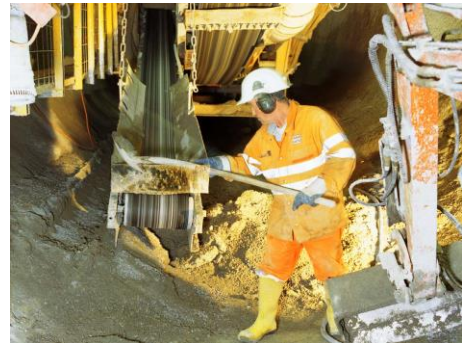
Fig.290-Manutenção no tapete [347]
