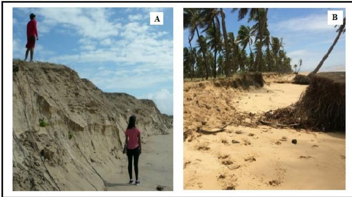
Figura 02 - Geoindicadores de erosão severa, (A) ponto 02 e (B) ponto 12
