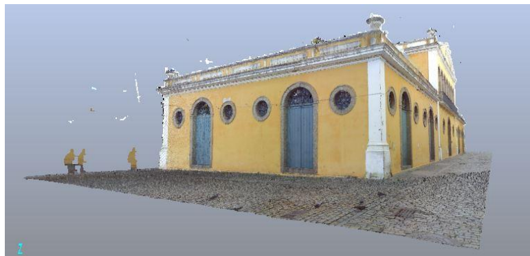
Figura 1 – Nuvem de pontos da fachada leste do prédio da Alfândega em Florianópolis-SC, Brasil.
