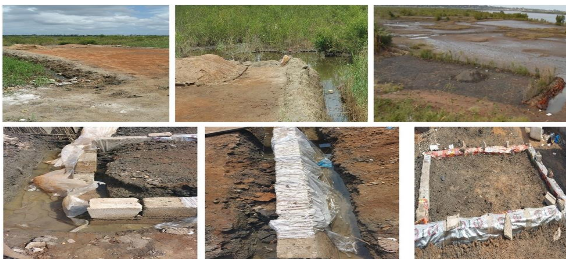
Figura 5 - Exemplo de fundação na zona baixa. Fonte: Autora, 2016.
