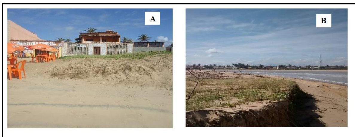
Figura 03 - Geoindicadores de erosão, (A) ponto 4 e (B) ponto 32
