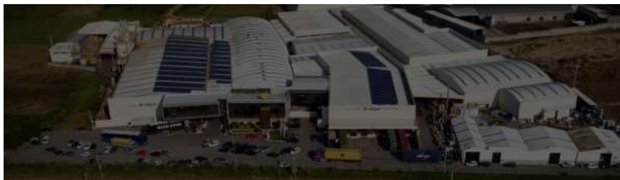
Figura 6 - Imagem área da empresa Bi-Silque - Produtos de Comunicação Visual, S.A.
