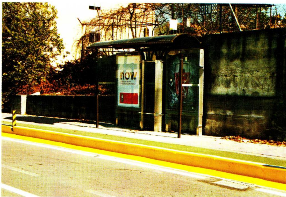
Figura 3 – Parcela da ciclovia recentemente construída em Lamações
