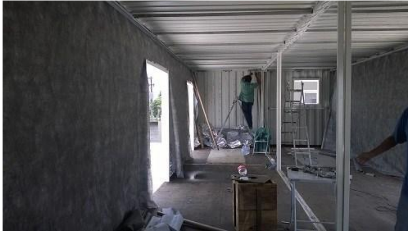
Figura 100: Aplicação de parede drywall em container
