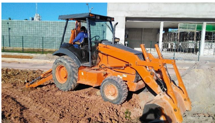
Figura 19 – Serviços de escavação (reproduzido da base de imagens do NSHT, 2017).
