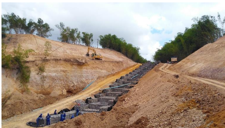
Figura 18 – Obra de talvegue (reproduzido da base de imagens do NSHT, 2017).
