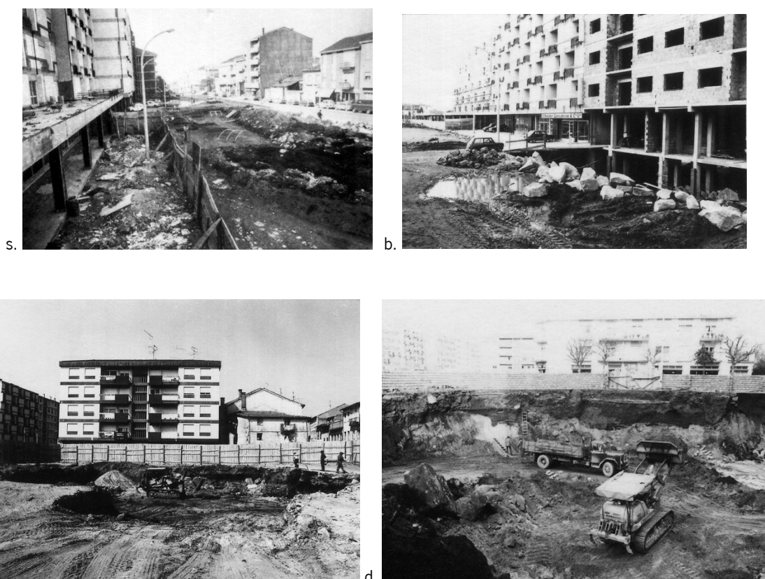
Figura 235 – Aspeto das distintas áreas intervencionadas em 1979-1980 na rua do Caires: a. zona 79C e 80C; b. zona 80B; c. zona 80/81C; d, zona 80E (©UAUM).
