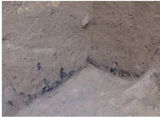
Figura 181 – Pormenor da estrutura U003 em corte (©UAUM).
