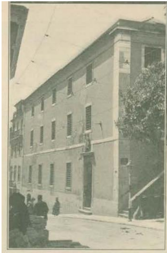
Fig.5 : O edifício do Aljube, início séc. XX.
