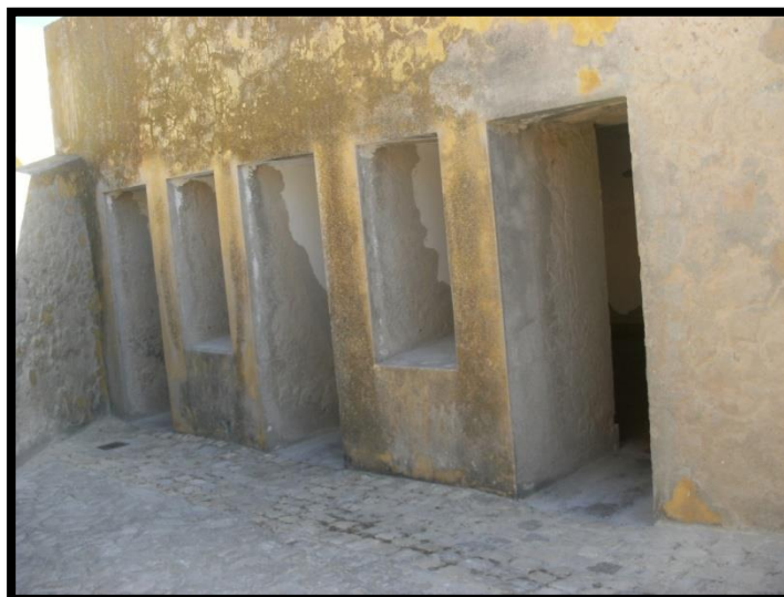
Fig.11: Entradas para as celas de isolamento, o «segredo».
