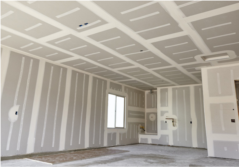
Figura 3.12. Utilização de placas de gesso cartonado, para revestimento de paredes, criação de tetos falsos ou paredes, desconhecido.
