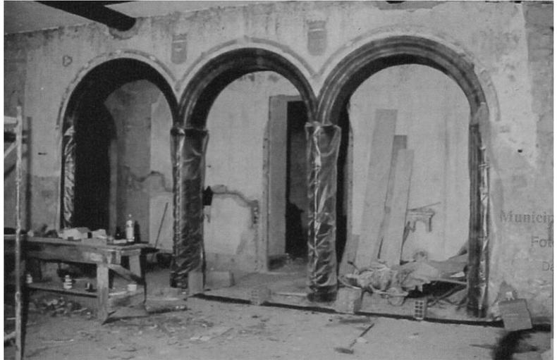
Figura 60. Fotografia anterior à intervenção de 1990 onde é evidente as paredes rebocadas e pintura decorativa
