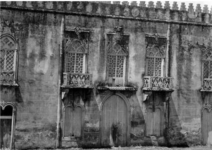
Figura 61. Fotografia da fachada principal do Castelo de Portuzelo onde é observável a pintura de um aparelho fingido
