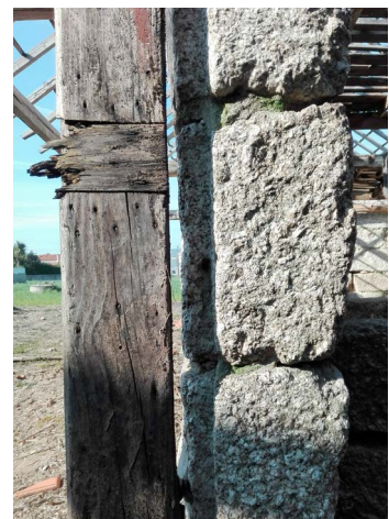
Fig.52_Parede pedra, com 30cm.
