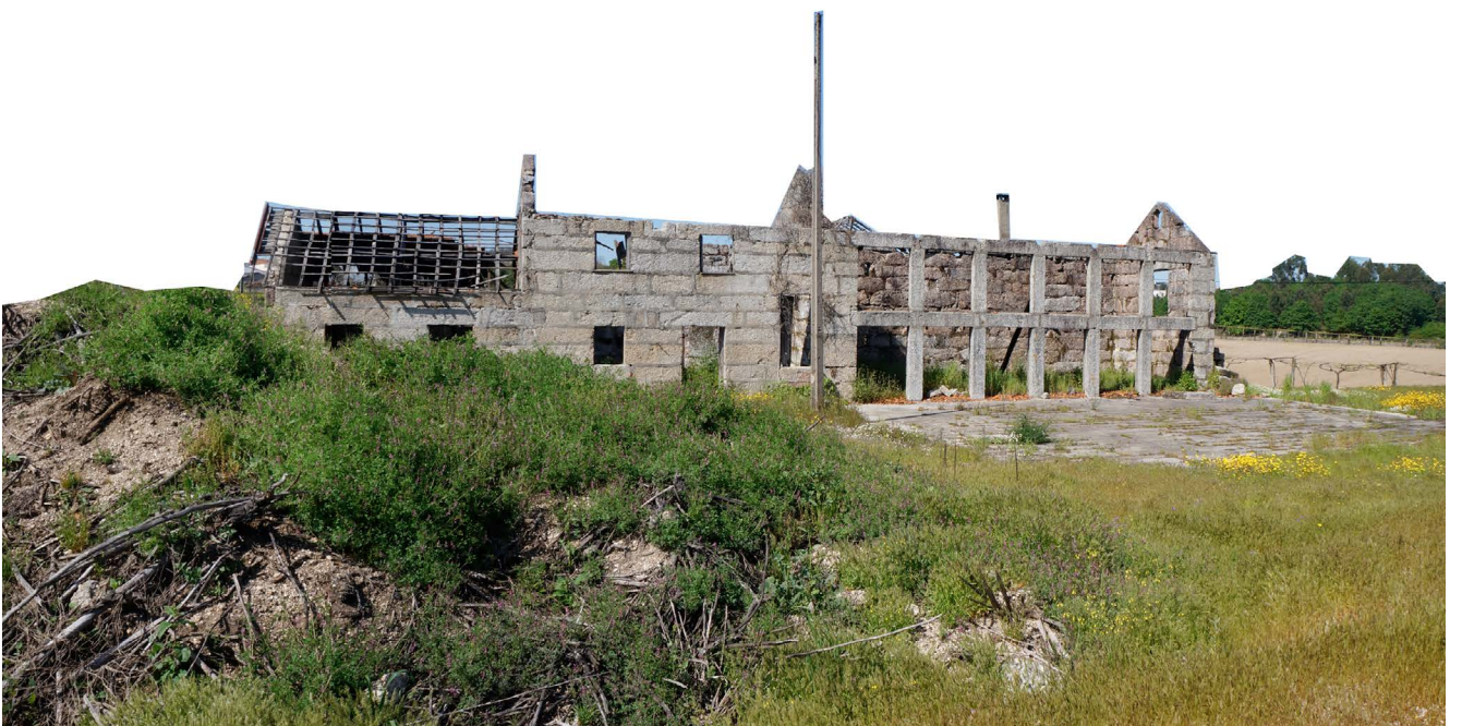
Fig.67_Alçado sul da ruína
