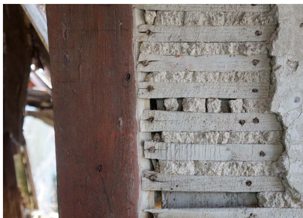
Fig.58_Sistema de tabique, Quinta de Cabanelas
