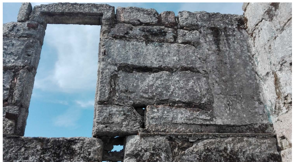
Fig.57_Parede em pedra de granito
