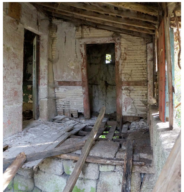
Fig.65_Varanda alpendrada, sistema tabique
