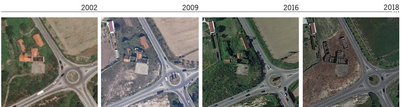
Fig.73_Cronologia de degradação das casas
