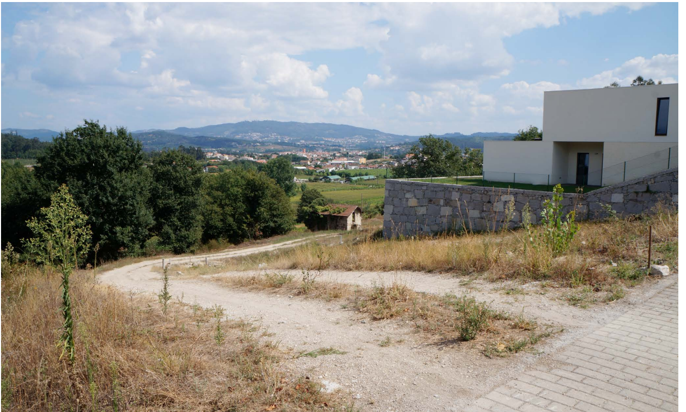
Fig.3_A Quinta de Vila Meã ao abandono, avizinhada pelo recente loteamento
