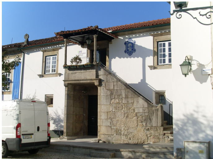
Figura 119 - Casa na Praça Conde de Agrolongo, n.º 116 (n.º 26)
