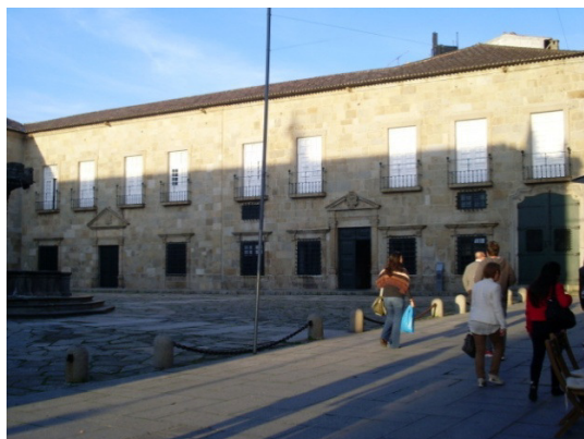
Figura 206 - Fachada da ala nascente do corpo sul (Foto da autora)
