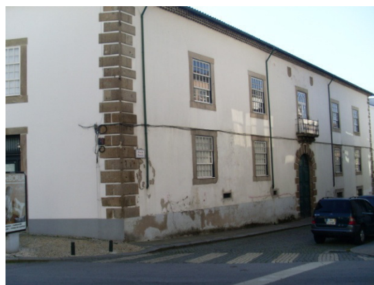
Figura 126 - Casa dos Sotomayor, fachada para a Rua da Boavista (nº 29)
