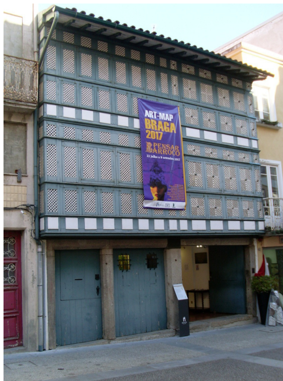
Figura 215 - Fachada principal da Casa dos Crivos
