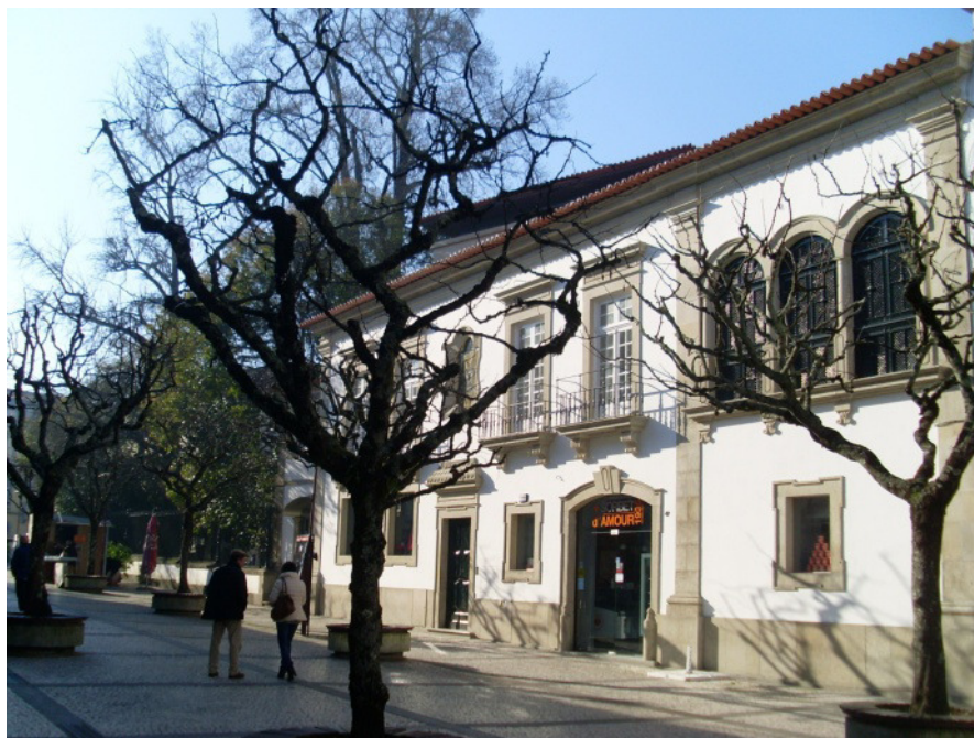
Figura 185 - Edificado anexo à Casa do Passadiço (Foto da autora)
