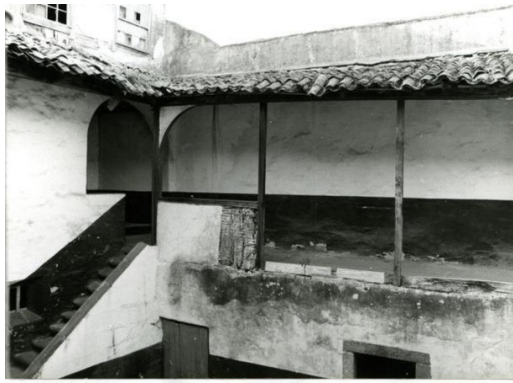
Figura 169 - Varanda do piso superior, vista do pátio interno (DGPC)
