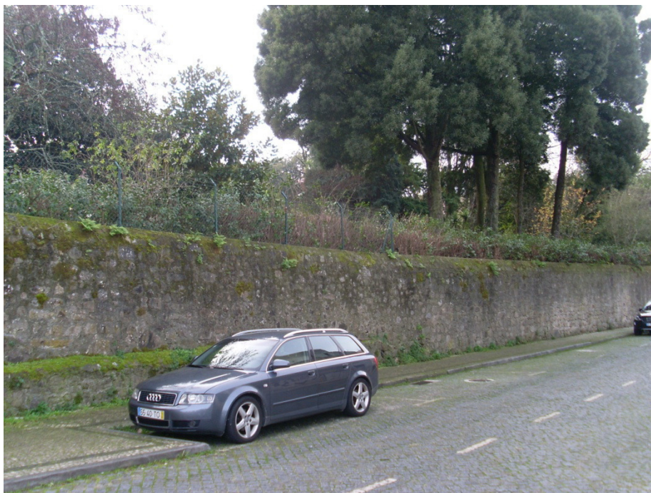
Figura 232 - Muro de cantaria que delimita o jardim (Foto da autora)
