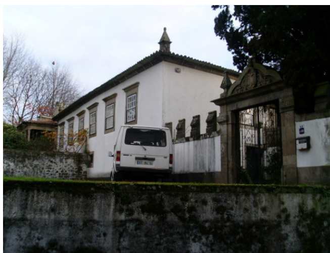
Figura 92 - Casa do Avelar, fachada norte (n°17)
