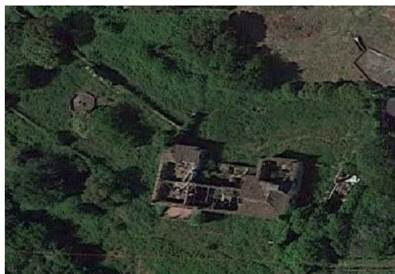
Figura 38 - Foto aérea da Casa da Naia em estado de degradação 128
