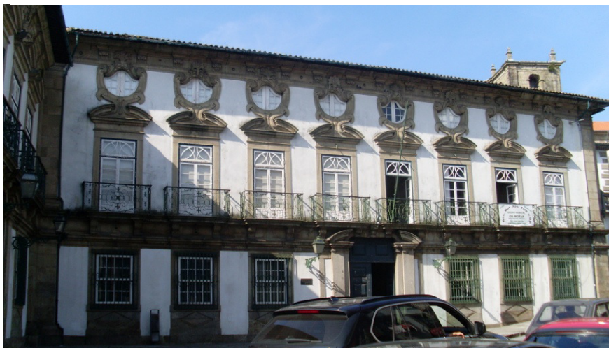
Figura 246 - Segunda perspetiva da fachada principal do Museu dos Biscainhos (Foto da autora)
