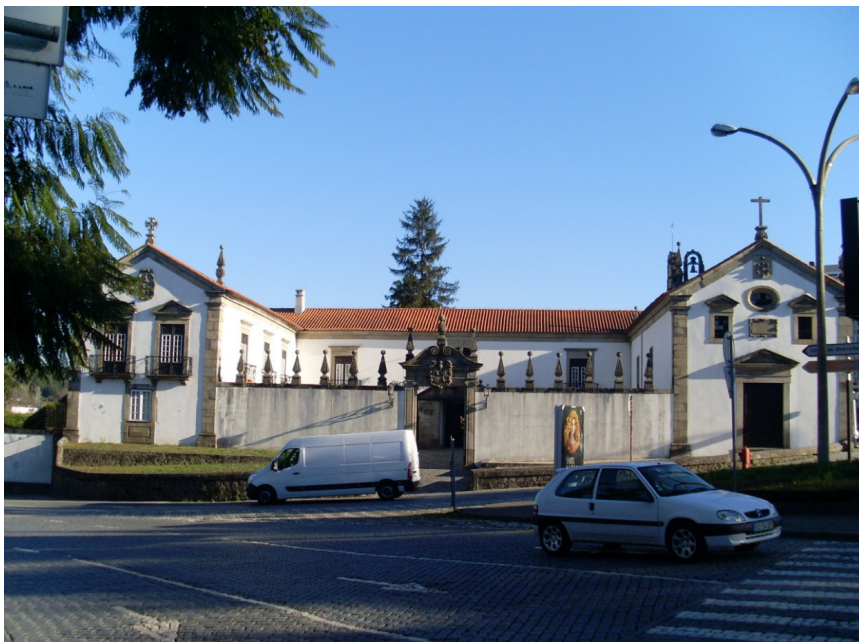
Figura 303 - Fachada principal da Casa de Vale de Flores (Foto da autora)
