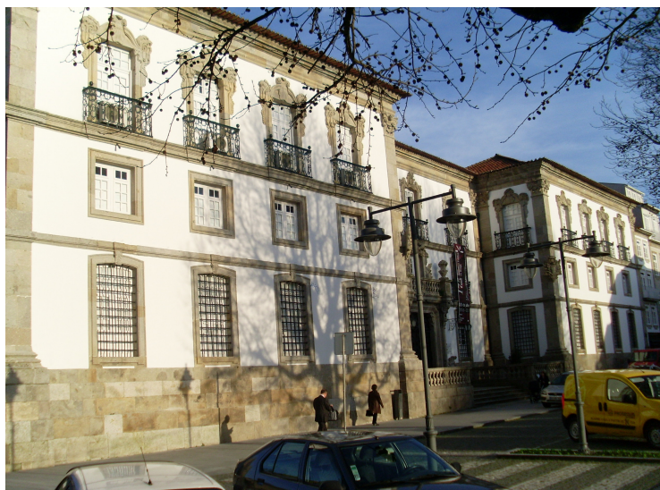
Figura 70 - Fachada poente do corpo barroco (nº 7)
