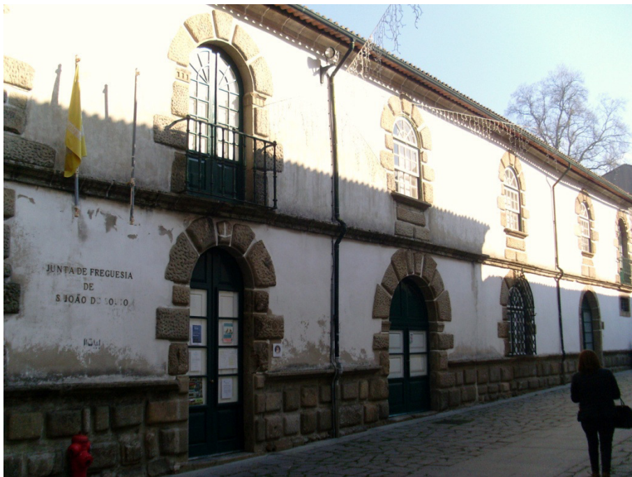
Figura 175 - Fachada virada para a Rua de S. João do Souto (Foto da autora)
