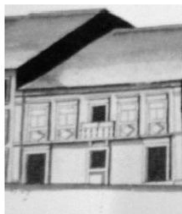
Figura 88 - Casa Setecentista da Rua dos Pelames no MRB
