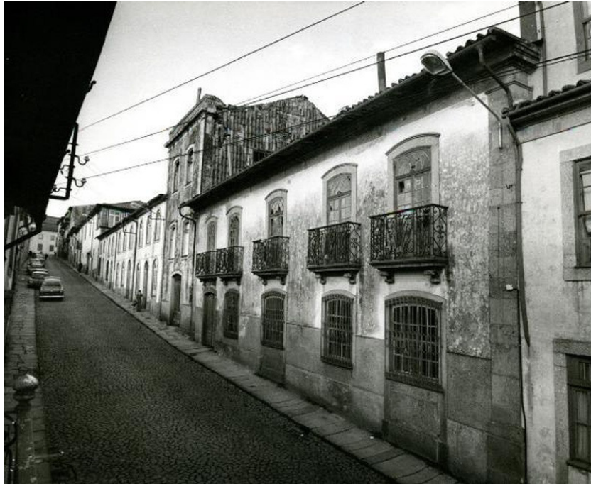
Figura 221 - Fachada principal da Casa na Rua de S. Geraldo, N° 51, antes da intervenção (DGPC)
