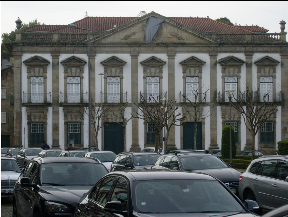
Figura 228 - Fachada principal da Casa Grande (Foto da autora)
