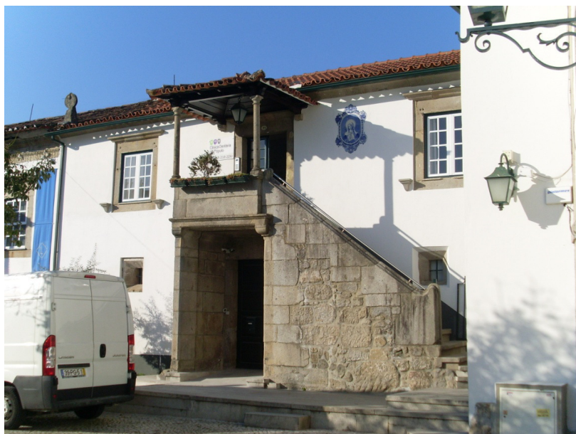
Figura 276 - Casa na Praça Conde de Agrolongo, n.º 116 (Foto da autora)
