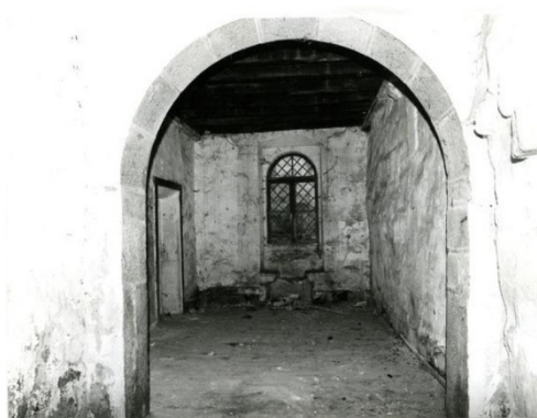
Figura 167 - Interior de divisão no piso térreo (DGPC)
