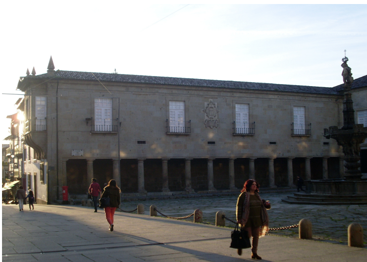
Figura 67 - Fachada da ala poente do corpo sul (nº 7)
