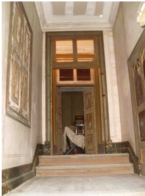
Figura 297 - Degraus para o acesso a divisões do terceiro piso (Foto da autora)
