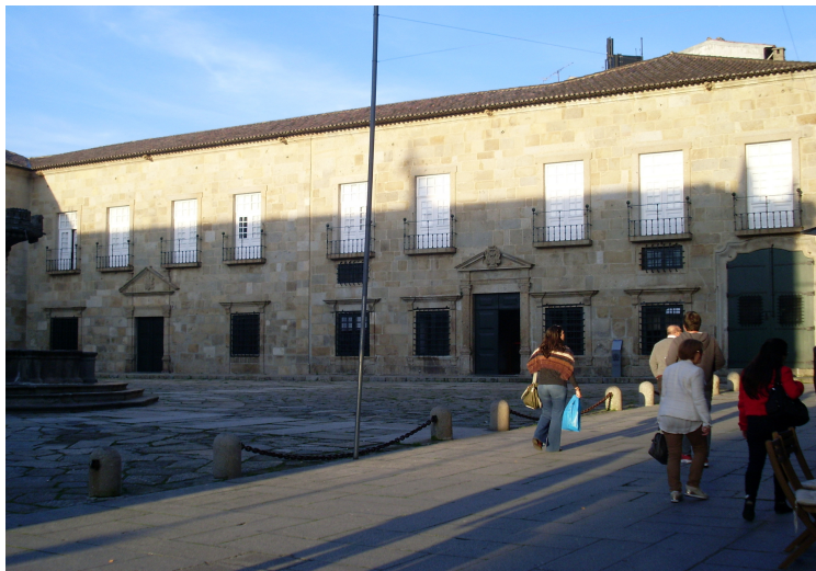
Figura 69 - Fachada da ala nascente do corpo sul (nº 7)
