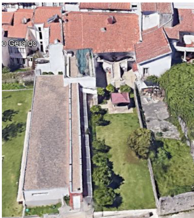
Figura 223 - Fachada posterior (Foto da autora)
