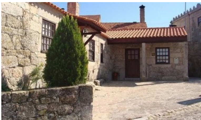
Figura 26 - Casa da Lagariça, inspiração para “A Ilustre Casa de Ramires” 103
