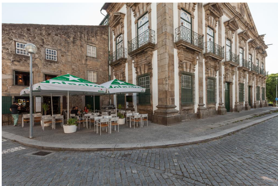
Figura 229 - Fachada lateral esquerda com construção adossada (Fonte: https://www.booking.com/hotel/pt/casa-grande-minho-39-s-guest.pt-pt.html , consultado em outubro 1, 2018)
