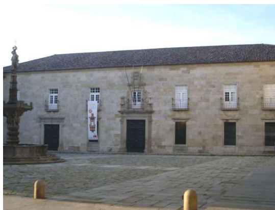
Figura 205 - Fachada da ala central do corpo sul (Foto da autora)
