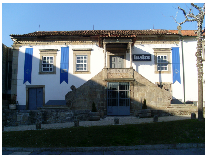
Figura 120 - Casa na Praça Conde de Agrolongo, n.º 115 (n.º 27)
