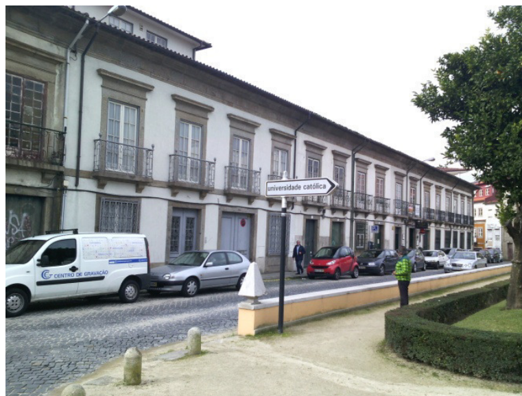
Figura 146 - Edifício representativo da Praça de Mouzinho de Albuquerque (nº 42)
