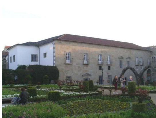
Figura 202 - Fachada norte da ala central da estrutura sul (Foto da autora)
