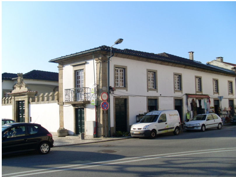
Figura 270 - Fachada lateral direita (Foto da autora)
