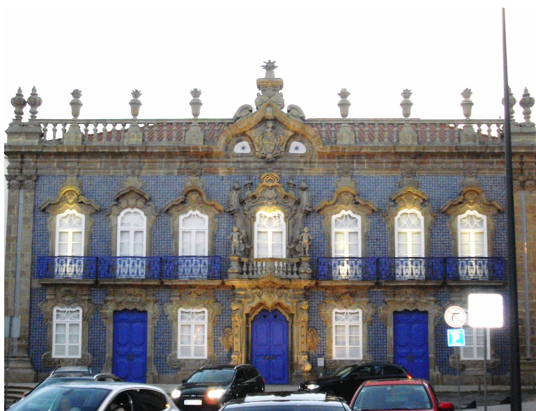
Figura 158 - Palácio do Raio (nº 46)
