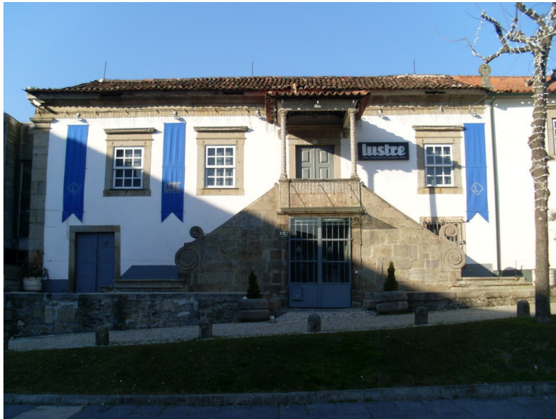
Figura 284 - Casa na Praça Conde de Agrolongo, n.º 115 (Foto da autora)
