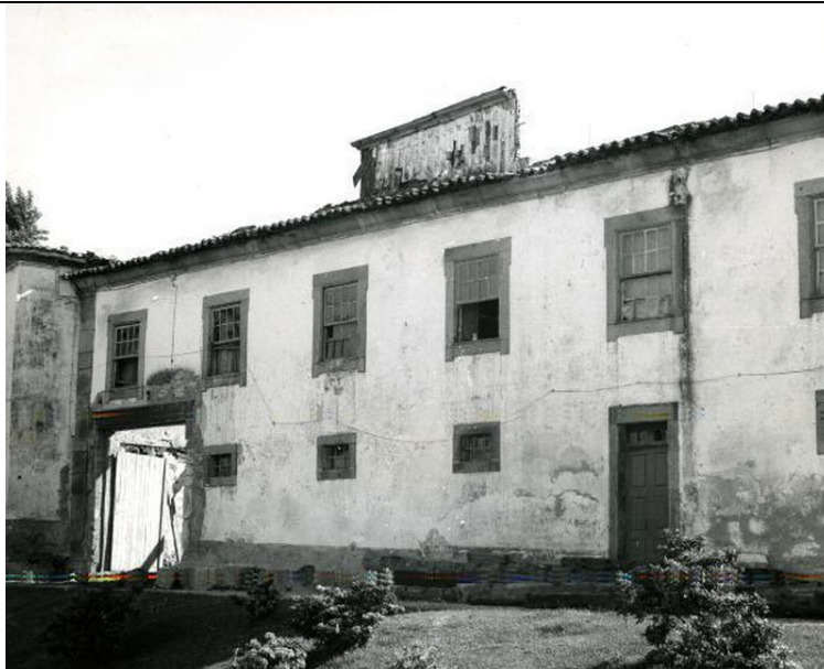
Figura 268 - Fachada lateral esquerda, em 1970 (DGPC)
