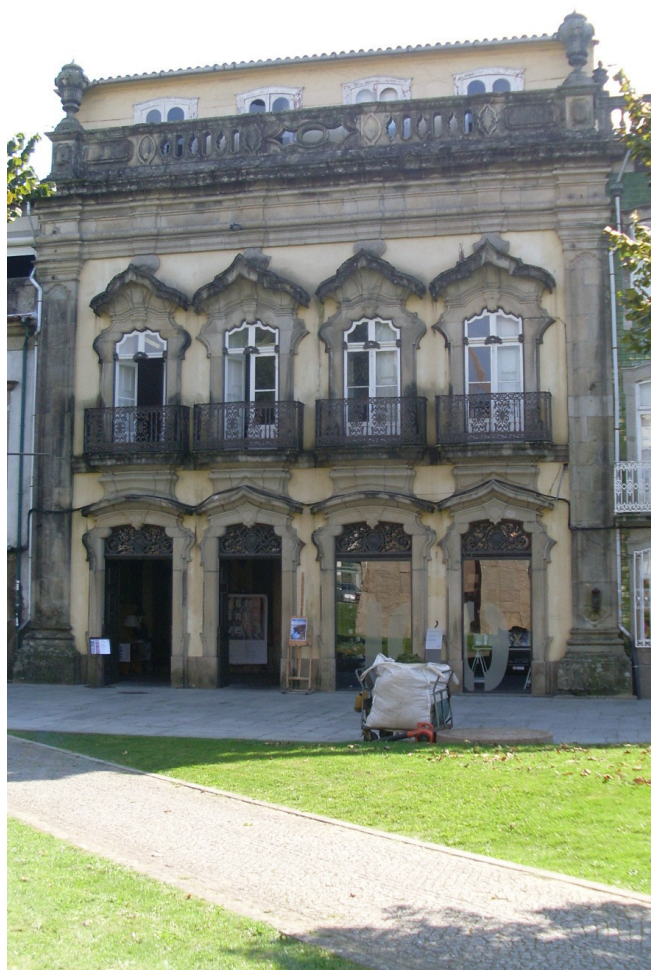
Figura 291 - Fachada principal da Casa Rolão (Fota da autora)
