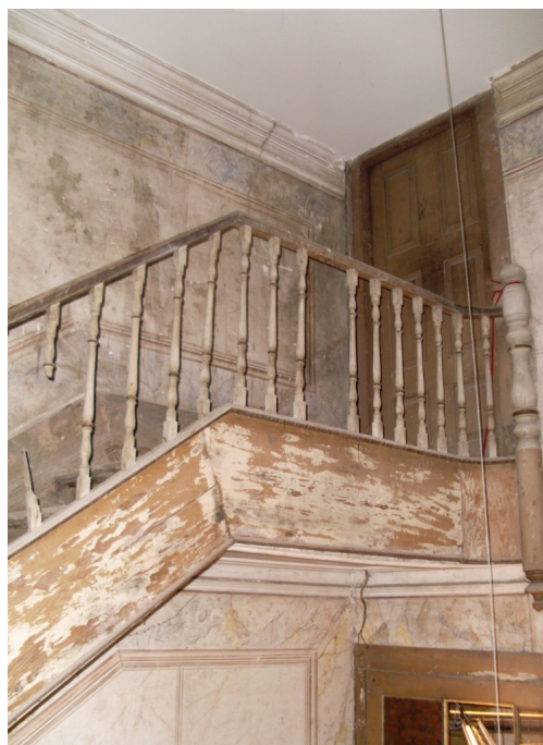
Figura 299 - Acesso ao último piso (Fota da autora)
