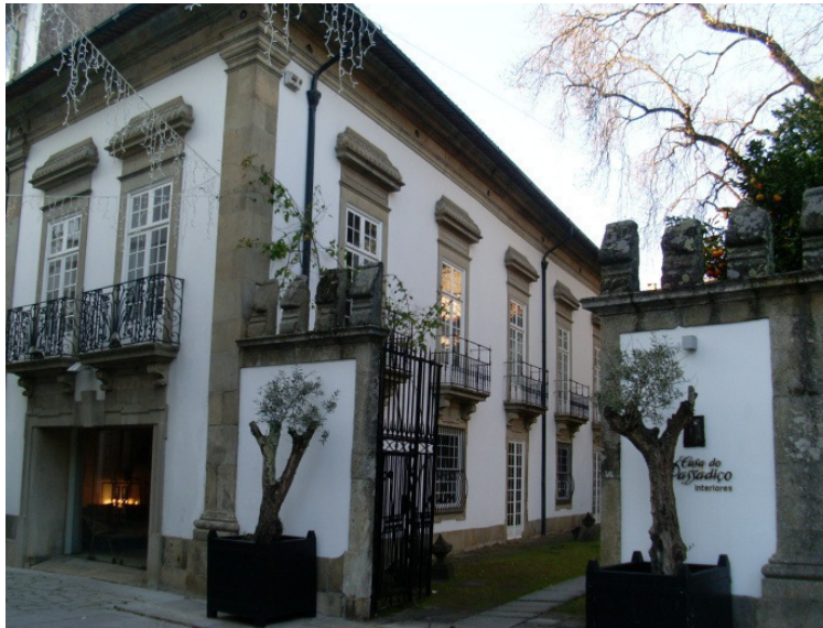
Figura 182 - Fachadas sul e este da Casa do Passadiço (Foto da autora)
