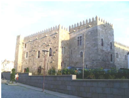
Figura 200 - Fachada norte da ala norte do conjunto gótico (Foto da autora)
