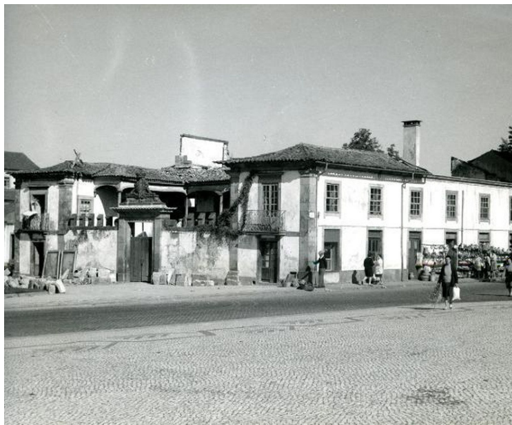
Figura 267 - fachada principal e lateral direita, em 1970 (DGPC)
