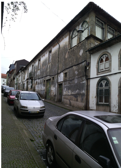
Figura 89 - Casa Grande da Rua dos Pelames (nº15)
