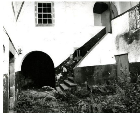
Figura 168 - Pátio interno, escada de acesso ao piso superior (DGPC)
