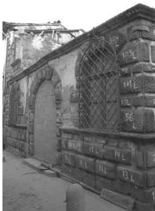
Figura 165 - Fachada da Rua de Nossa Senhora do Leite, em 1992 (UAUM)
