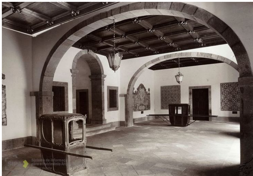
Figura 197 - Entrada da ala central do corpo sul, ano 1936 (SIPA)
