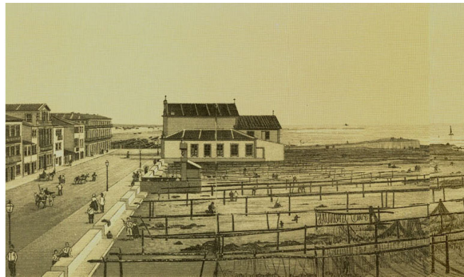
Figura 18 - Escola de Camões, Póvoa de Varzim (edifício branco) (cedido por Câmara Municipal da Póvoa de Varzim).
