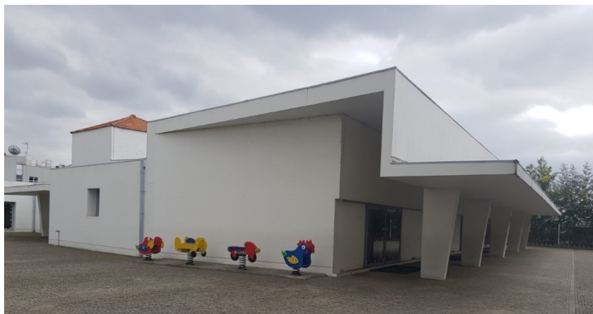
Figura 15 – Espaço exterior e pormenor de sombreamento das salas da Jardim-Escola João de Deus em Penafiel.
