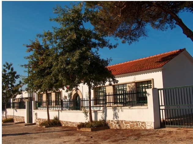
Figura 28 - Escola N.º 1 "Quinta", em Balazar (cedido por Câmara Municipal da Póvoa de Varzim).
