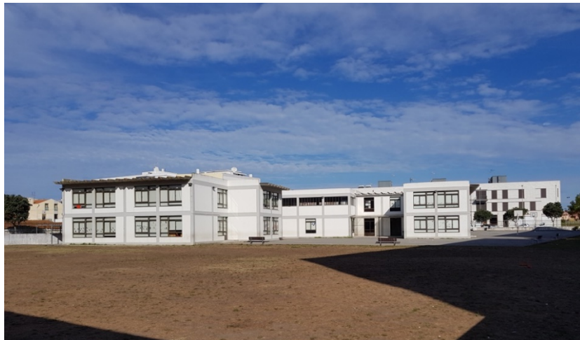
Figura 40 – Fachada sul da Escola de “Agro Velho”.
