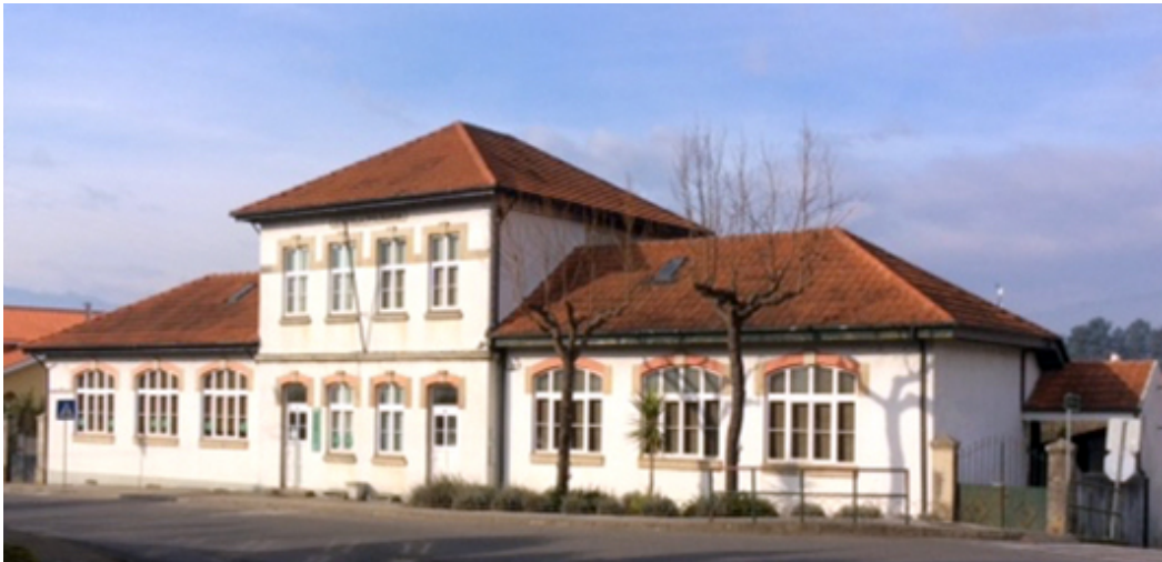
Figura 3 - Escola do Barrio, Mondim de Bastos (reproduzido de https://municipio.mondimdebasto.pt/index.php/1432-edificios-escolares-de-mondim-de-basto.html )
