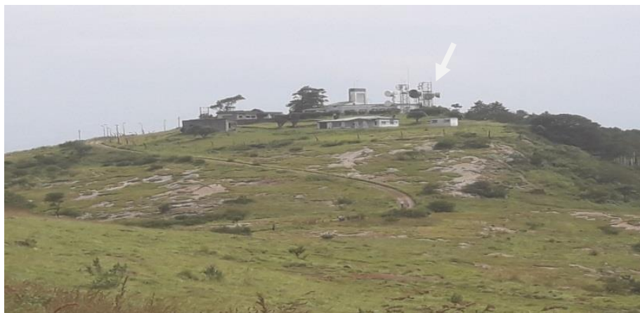
Figura 4: Vista do ponto mais alto do Monte M'ponduine com instalação de infraestrutura moçambicana de suporte de comunicação (extraída pelo grupo 2019)
