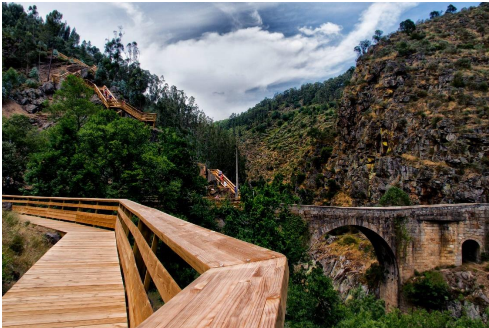
Figura 11. Passadiços do Paiva junto do geossítio “Garganta do Paiva”. © AGA.
