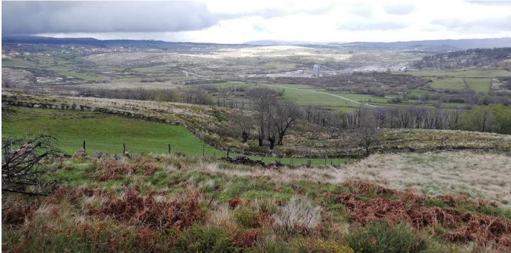
Figura 29. panorâmica da zona de construção do aproveitamento hidroelétrico de Gouvães da Serra (Vila Pouca de Aguiar).
