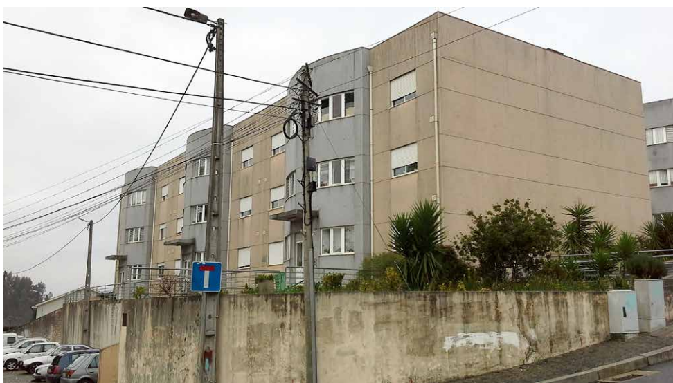
Figura 2 - O edifício caso de estudo em Vila Nova de Gaia, Porto, Portugal.
