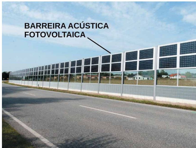
Figura 1 – Painel fotovoltaico em barreira sonora.
