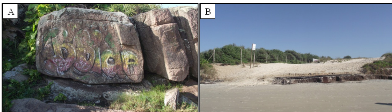
Figura 3. Depredações observadas nos geossítios. A) Pichação no Granito Ilha na ponta do Retiro; B) Rampa de areia que encobre parte do afloramento de Turfa da praia do Campeche.
