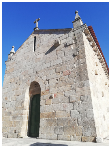
Fachada principal da igreja (Este).
