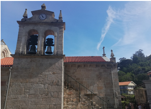
Fotografia da torre do relógio (fachada Sul).
