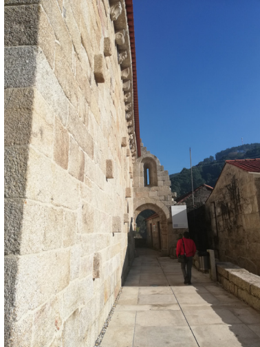
Vestígios da nave demolida.
