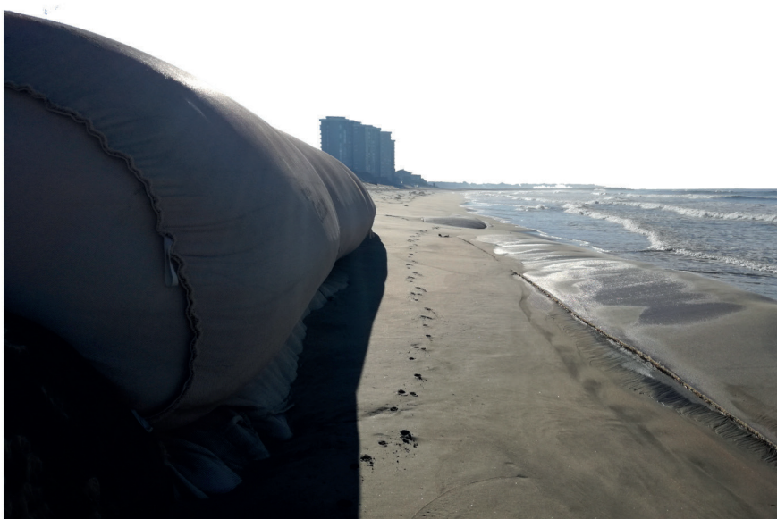
Figura 41 - Redução do areal da praia de Ofir, salientando os sacos de areia de Geotêxtil de combate à erosão e migração das praias.
