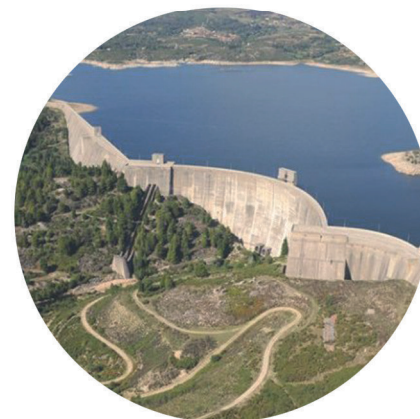
Barragem do Alto Rabagão
