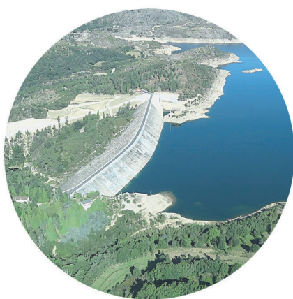
Barragem da Paradela
