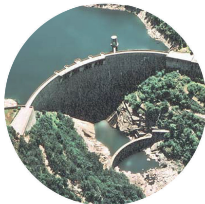
Barragem de Salamonde
