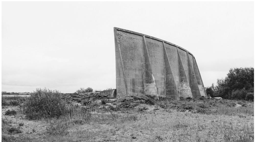
metros de altura, e uma parede estática, que mede 60 metros de comprimento com altura de cerca 15 metros. A parede conseguia detectar o ruído dos aviões a cerca de quase 5 quilómetros de distância.<sup>35</sup>
