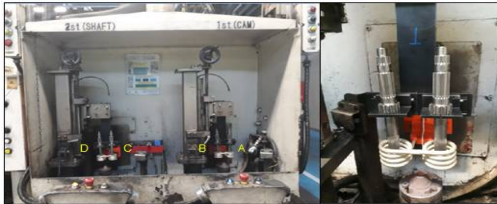
Figura 42 - indutora de eixos com as bobinas duplas e dispositivos de fixação de eixos instalados.
