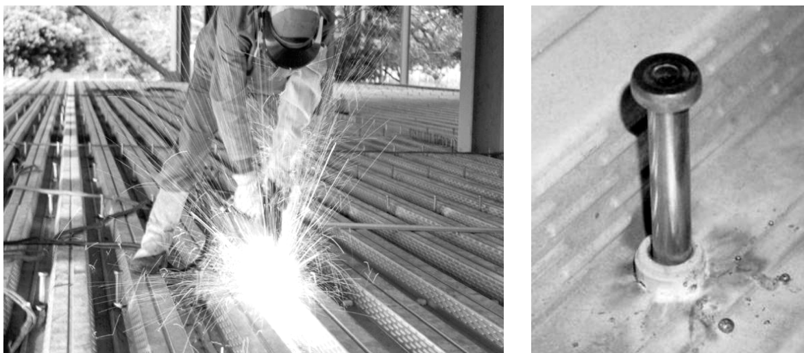
Figura 2 - O conector stud – aplicação sobre deck metálico
