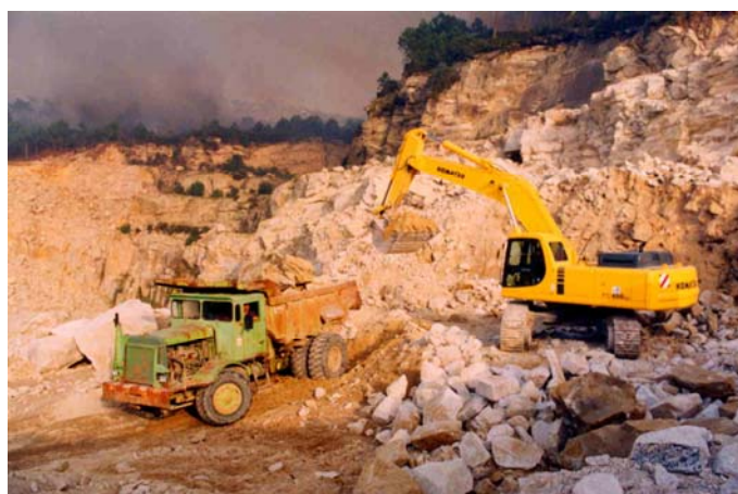
Fig. 9 - Estaleiro de Vila Praia de Âncora
