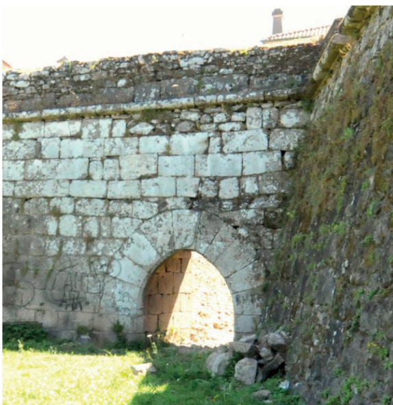
Figura 6. Puerta situada en una de las cortinas del recinto medieval de Valençã. Los restos de la fábrica medieval son de sillería irregular dispuesta en hiladas horizontales. Está rematada al exterior por un arco apuntado con clave decorada con escudo, mientras que la interior está rematada por un arco escarzano dovelado. La muralla medieval está alterada tanto por la construcción del parapeto que remata la cortina, como por el flanco del baluarte de São José, de perfil ataludado, ambos realizados en un aparejo de mampostería irregular.
