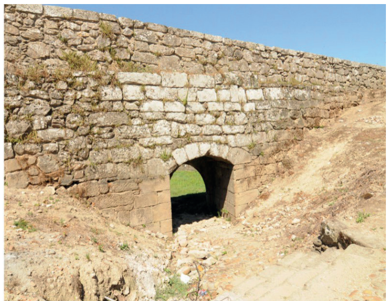
Figura 6. Puerta situada en una de las cortinas del recinto medieval de Valençã. Los restos de la fábrica medieval son de sillería irregular dispuesta en hiladas horizontales. Está rematada al exterior por un arco apuntado con clave decorada con escudo, mientras que la interior está rematada por un arco escarzano dovelado. La muralla medieval está alterada tanto por la construcción del parapeto que remata la cortina, como por el flanco del baluarte de São José, de perfil ataludado, ambos realizados en un aparejo de mampostería irregular.
