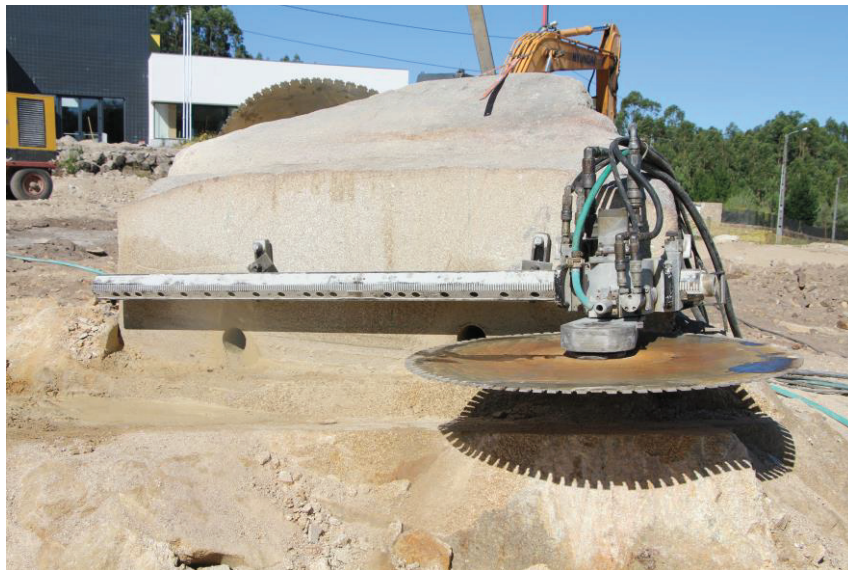
Figura 12. Trabalhos de corte do bloco 1. Fonte: Fotografia de Paulo A. Pinho Lemos.
