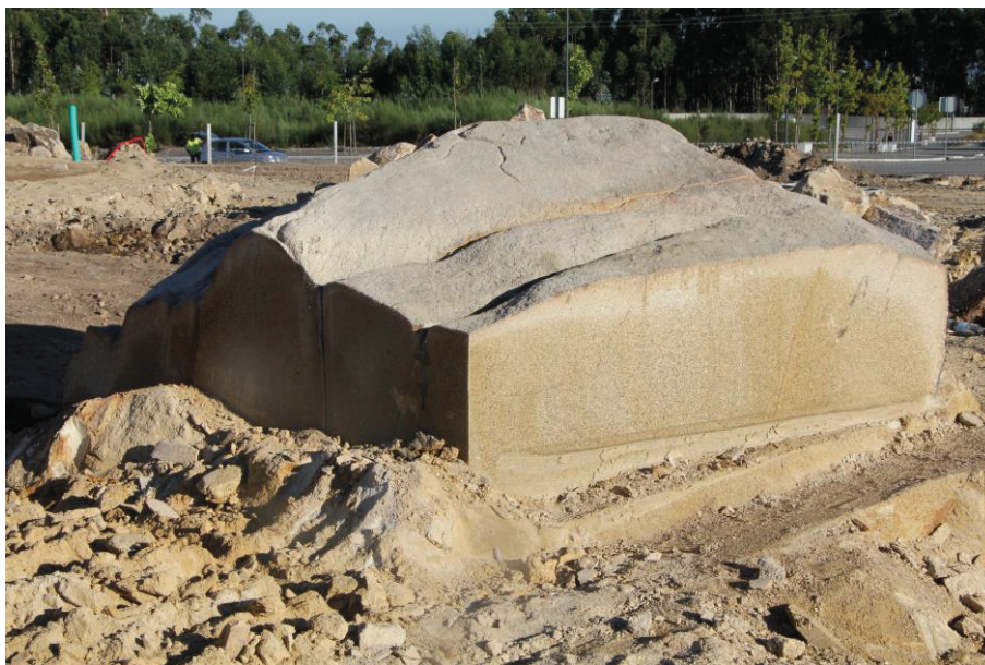
Figura 11. Pormenor dos blocos após os primeiros trabalhos de corte. Fonte: Fotografia de Paulo A. Pinho Lemos.
