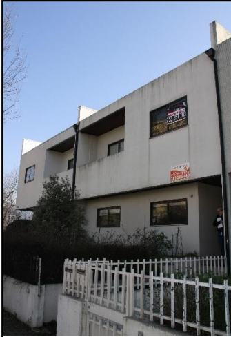
Fachada principal antes da reabilitação
