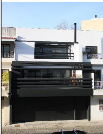
Fachada das Traseiras
