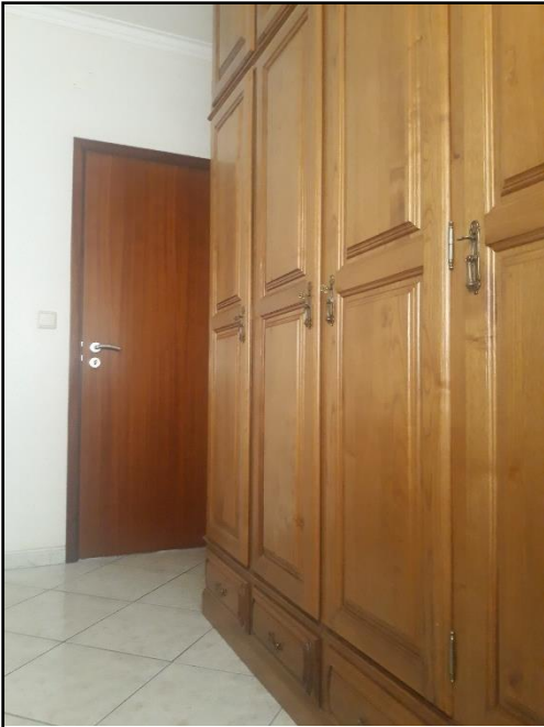
Móvel de arrumação inadequado
