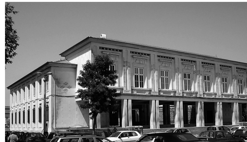
[Fig 11] Tribunal de Tomar, fachada principal, estado atual. Fotografia de Eduardo Fernandes, 2005.
