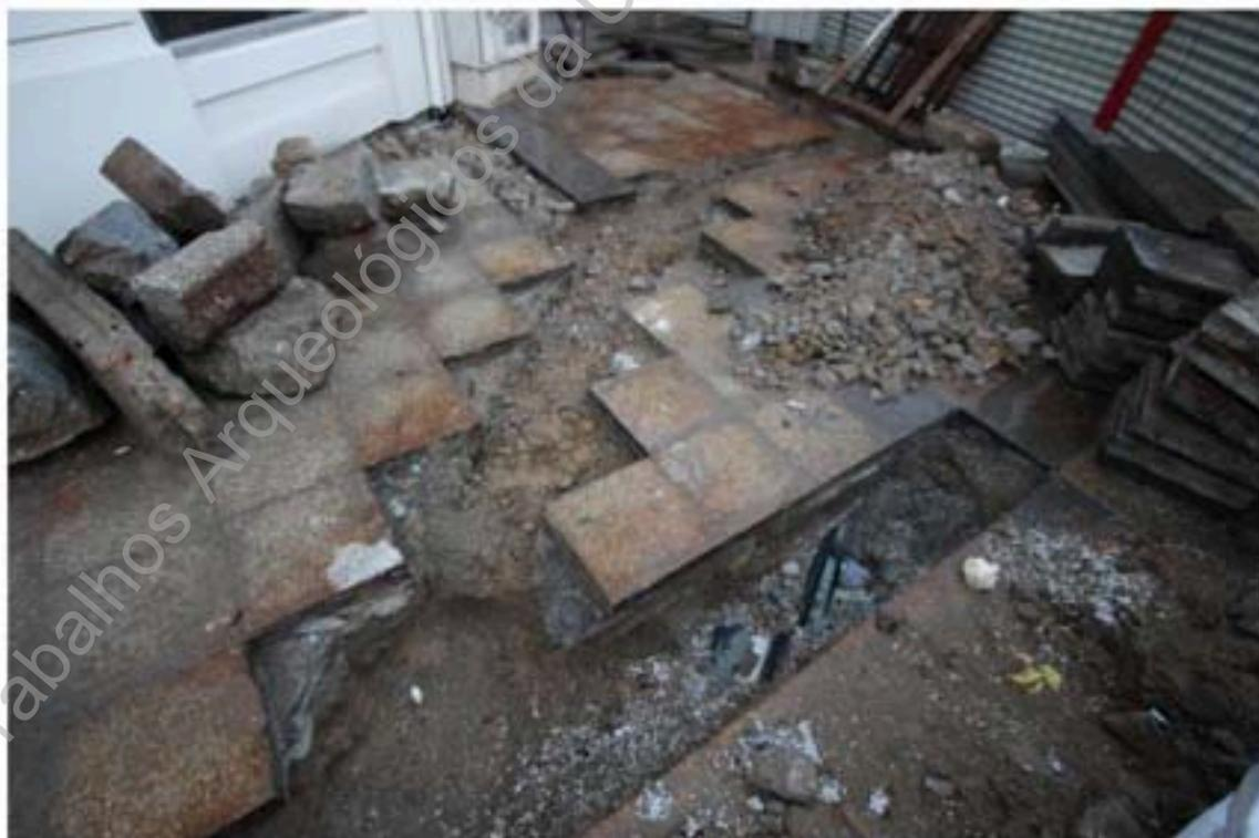
**Foto 158** – Acompanhamento dos trabalhos de abertura das valas para implantação das infraestruturas elétricas e de drenagem.
