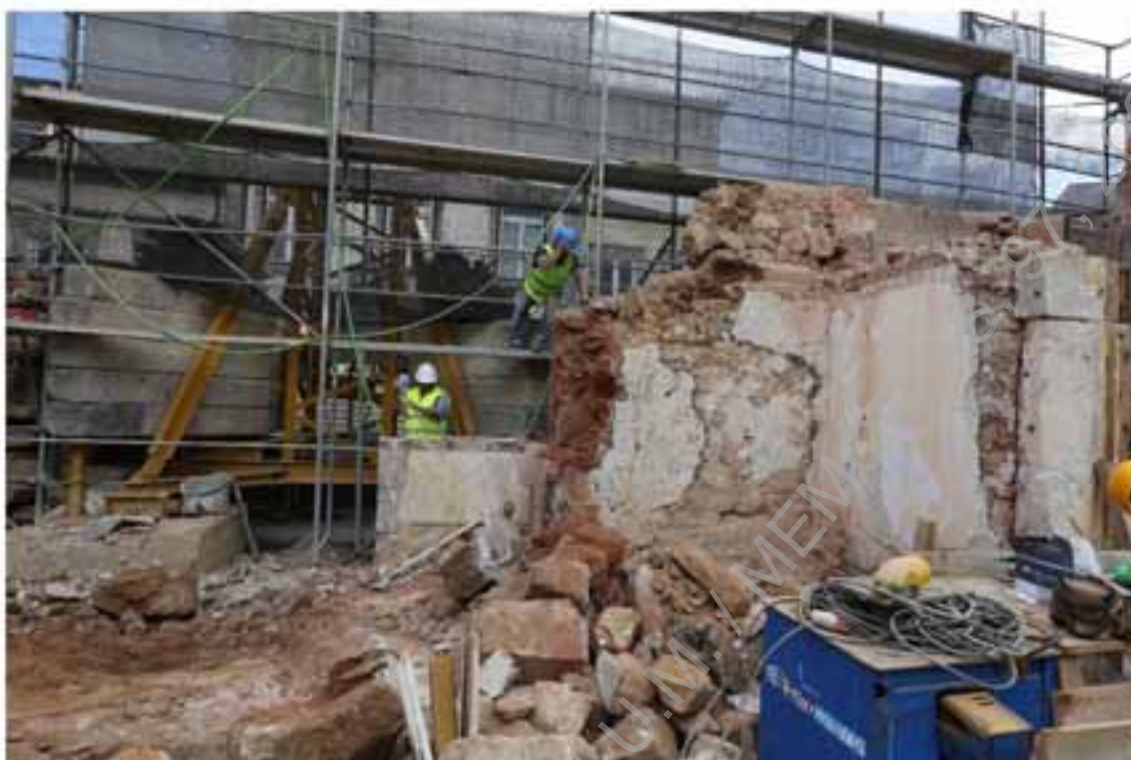
Foto 14 – Trabalhos de demolição da fachada da casa.
