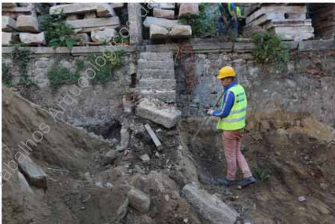
Foto 13 – Demolição das escadas de acesso ao antigo jardim da casa.
