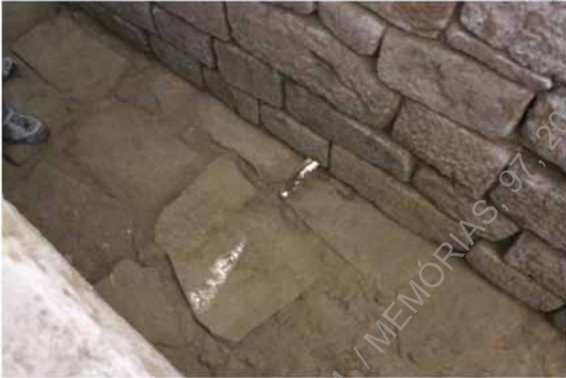
Foto 80 - Pormenor da abertura do acesso aos tubos de drenagem.
