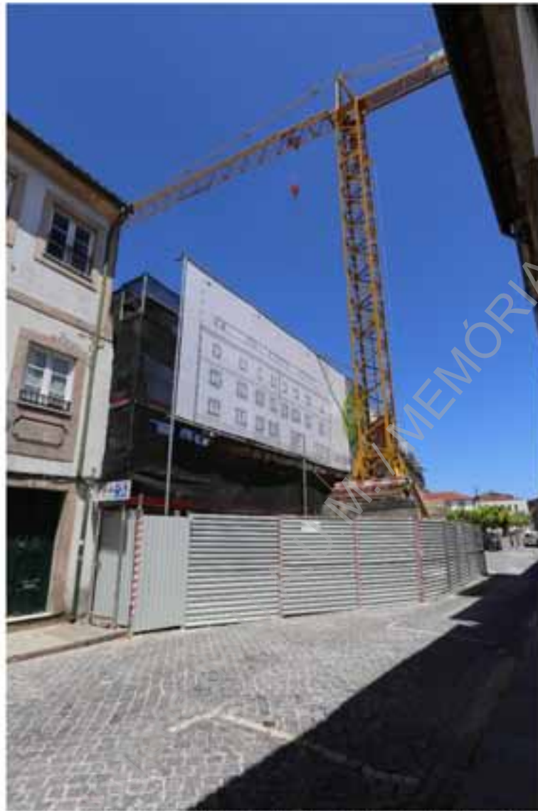
Foto 1 – Fachada do edifício localizado na Rua do Alcaide n°18-20.
