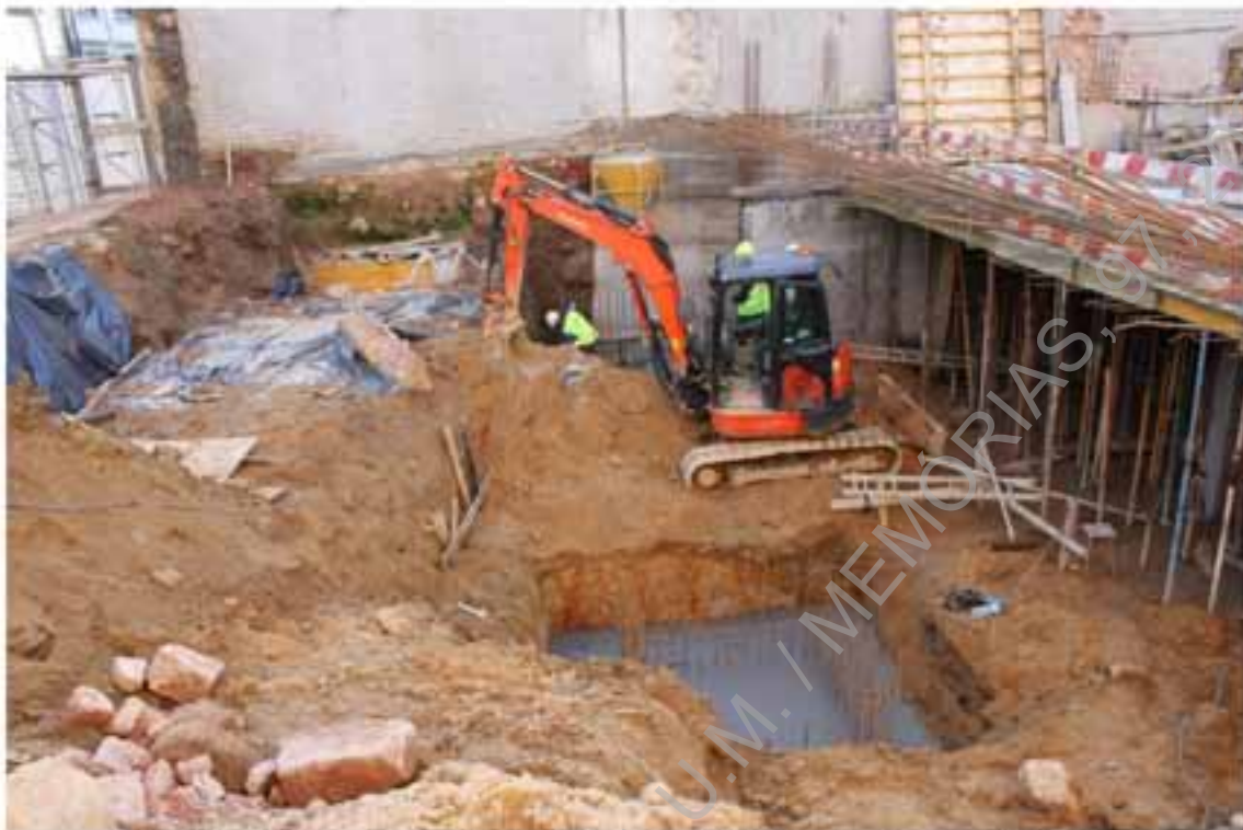
Foto 32 – Acompanhamento dos trabalhos de betonagem da caixa do elevador.
