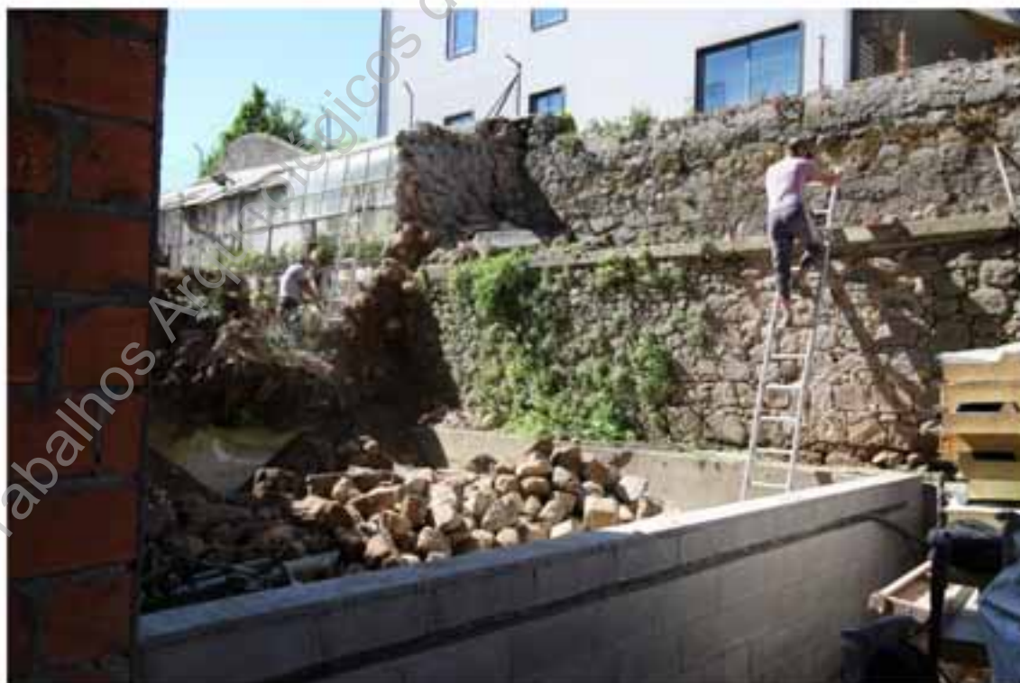
Foto 66 – Limpeza e consolidação dos muros da área de jardim.
