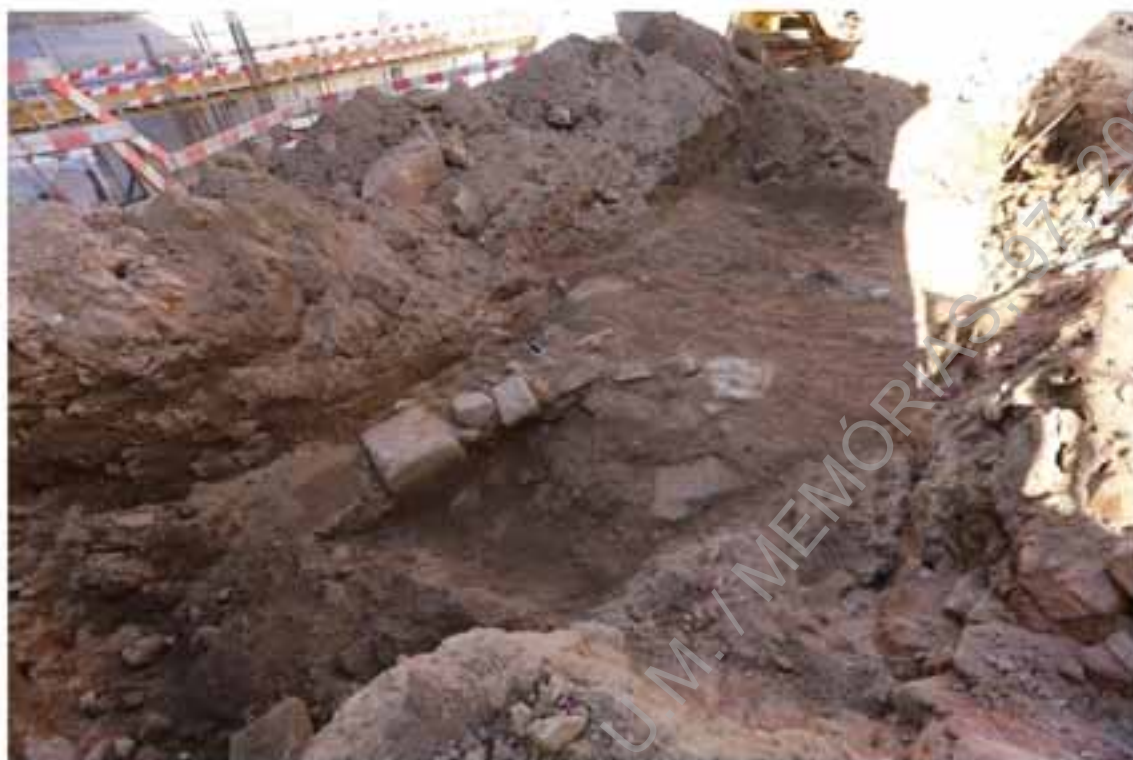
Foto 18 – Registo do plano 1 da cloaca romana junto à fachada do edifício.
