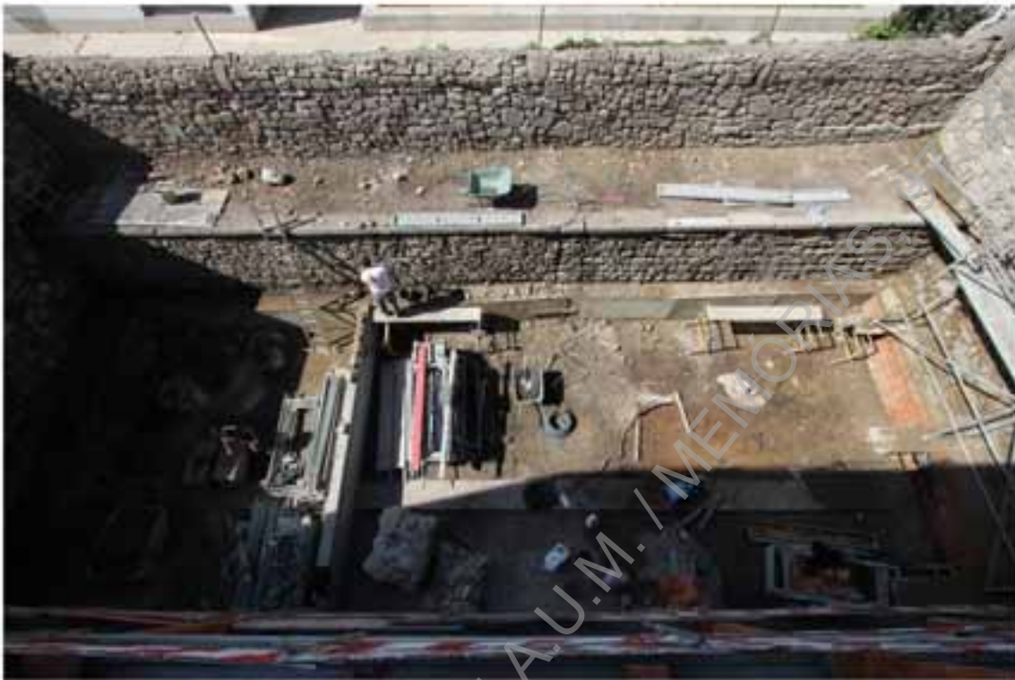
Foto 67 – Aspeto geral dos trabalhos na área de jardim.
