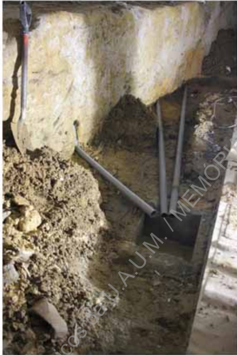
Foto 81 – Instalação dos tubos com ligação à caixa de drenagem.
