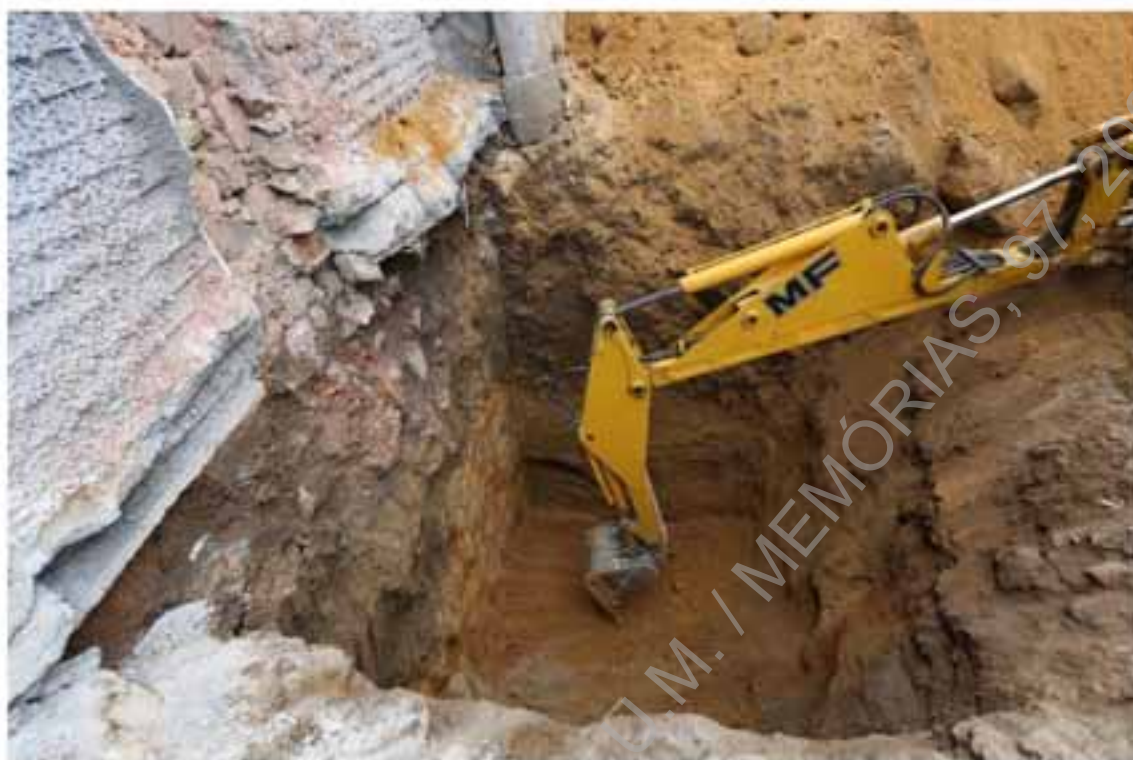
Foto 10 – Acompanhamento da abertura da sapata 3 (UE0176).
