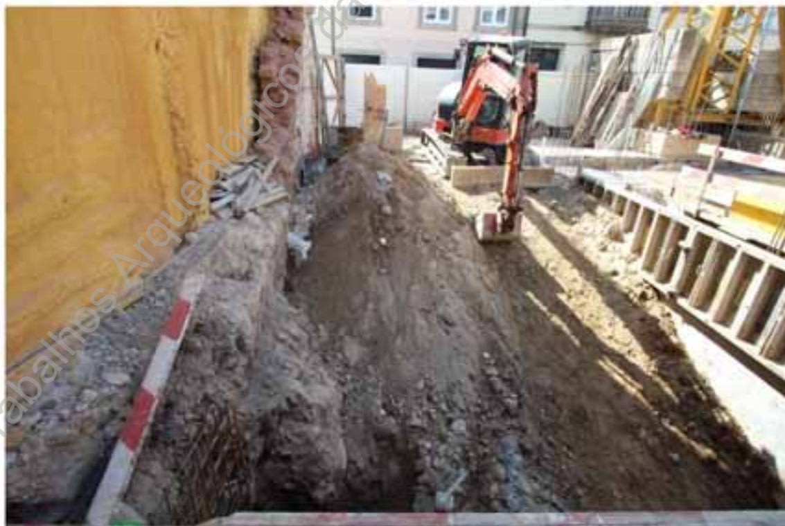
Foto 35 – Acompanhamento dos trabalhos de construção da rampa de acesso à garagem.
