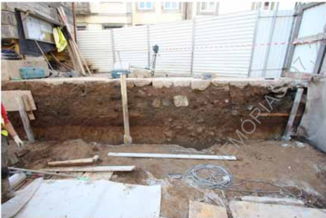
Foto 34 – Perfil sul do lote, junto à fachada do edifício.
