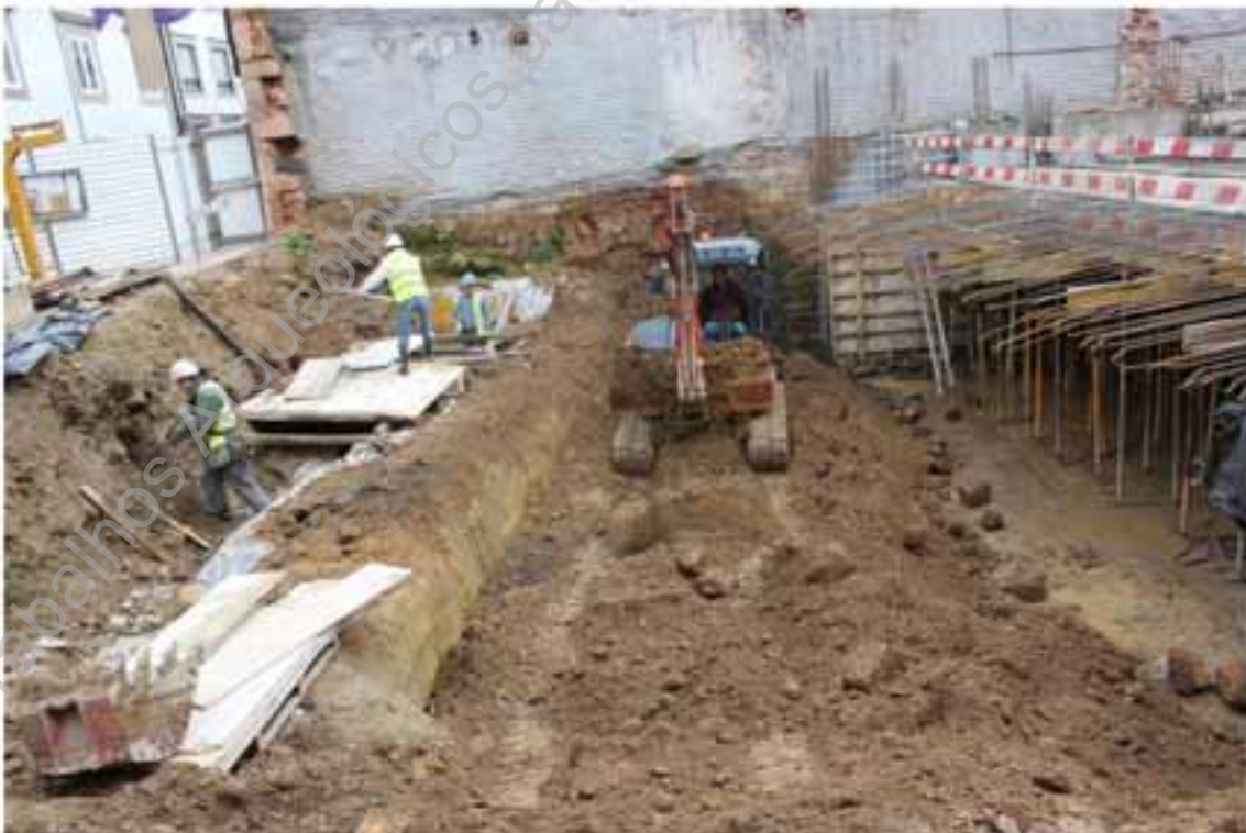
Foto 31 – Proteção das ruínas com uma estrutura em madeira.
