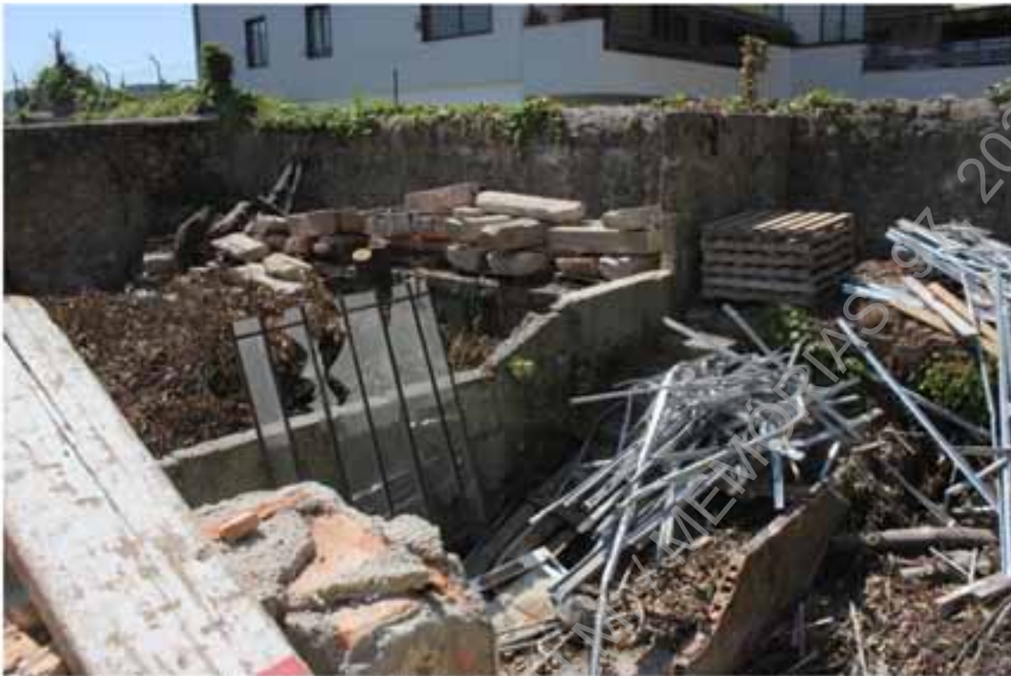
Foto 2 – Acompanhamento dos trabalhos de limpeza na área do quintal dos edifícios nº18 e 20.
