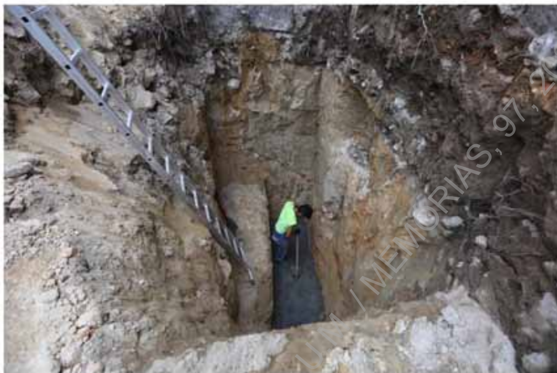
Foto 8 – Acompanhamento dos trabalhos de betonagem da sapata 2.
