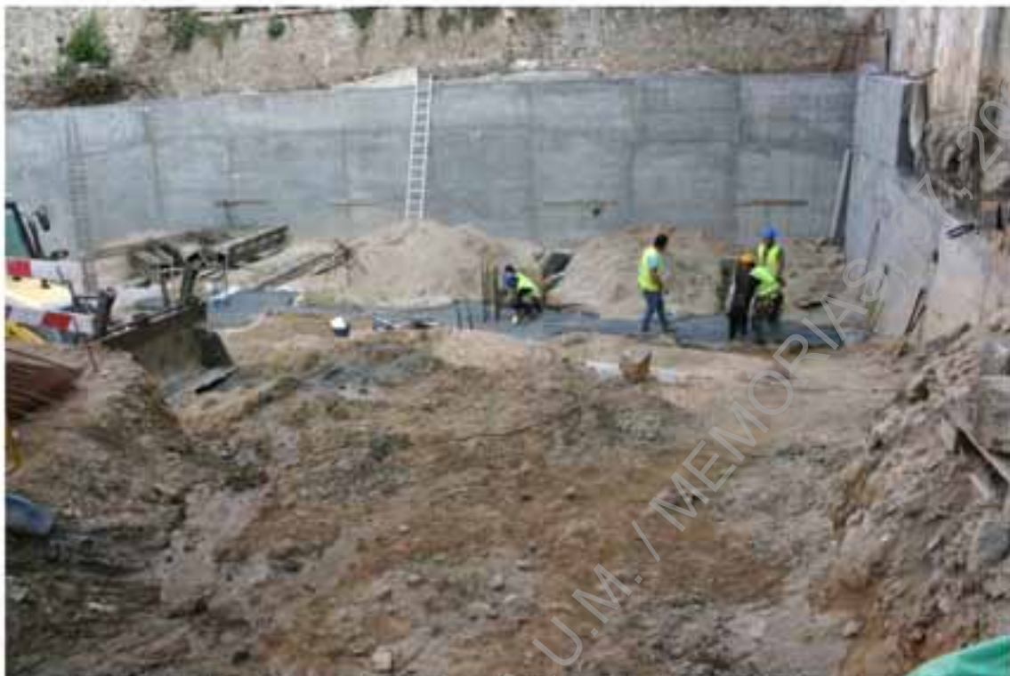
Foto 12 – Acompanhamento dos trabalhos de betonagem das sapatas.
