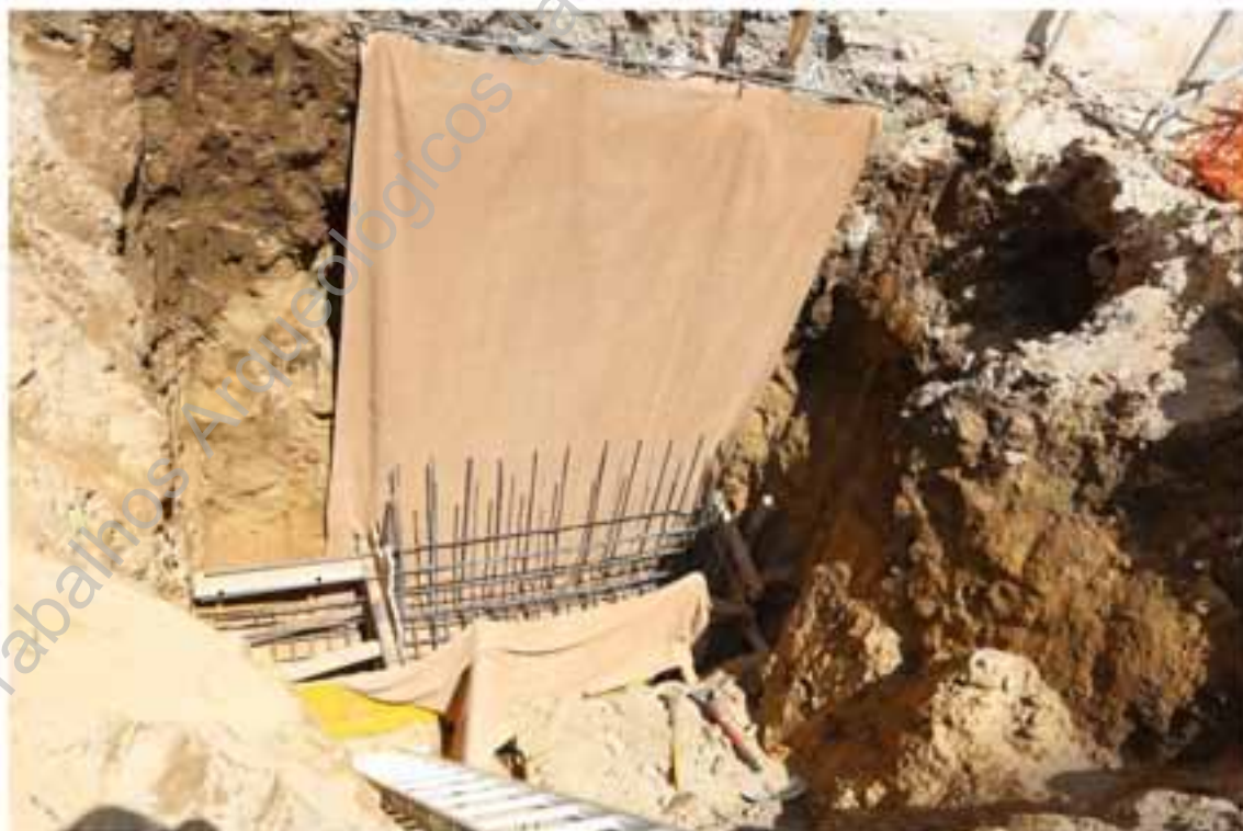
Foto 9 – Acompanhamento dos trabalhos de proteção de vestígios para a betonagem.
