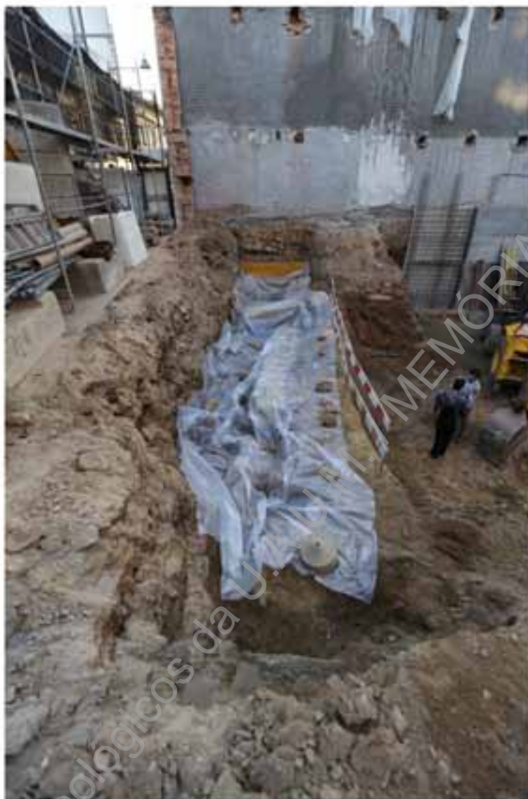
Foto 29 – Cobertura dos vestígios da cloaca romana com plástico para proteção durante a realização da obra.
