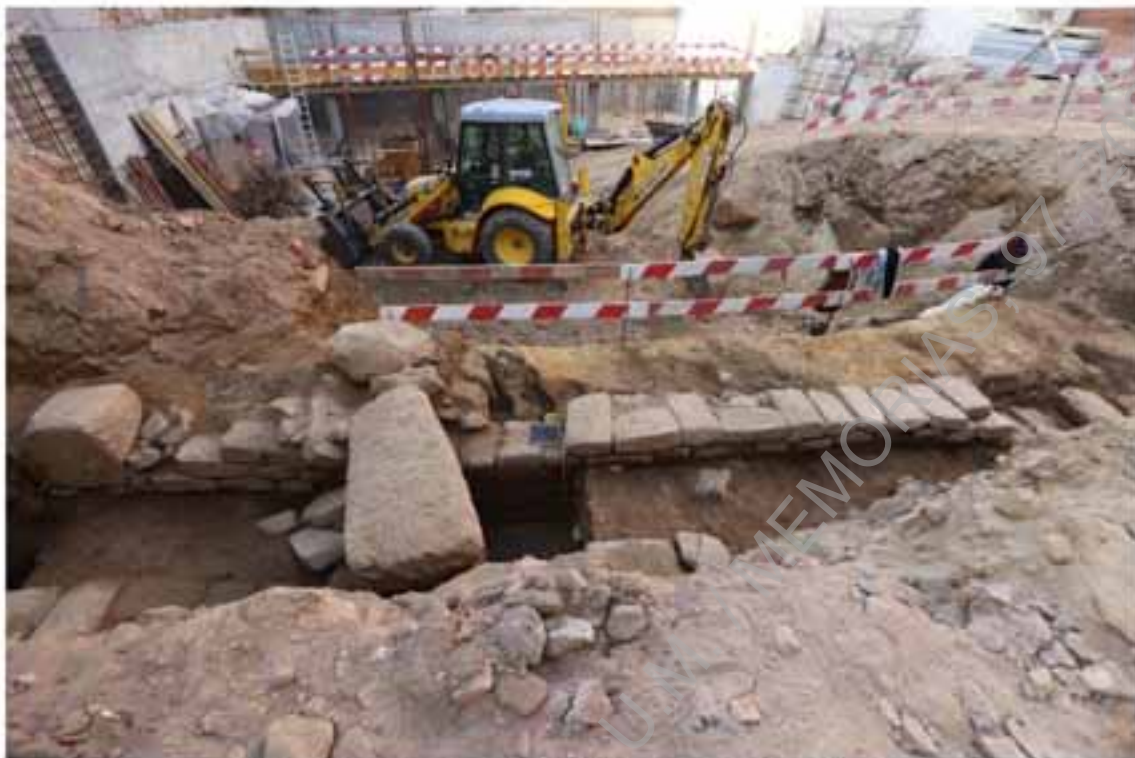
Foto 24 – Alçado sul UE0093 após as secções 1 e 2.
