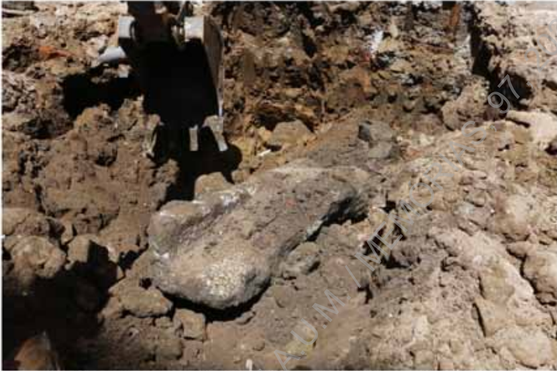
Foto 58 – Elemento de conduta em granito recolhido durante o acompanhamento.
