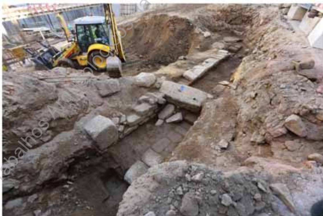
Foto 19 – Plano 3 da cloaca romana, no limite sul do lote.
