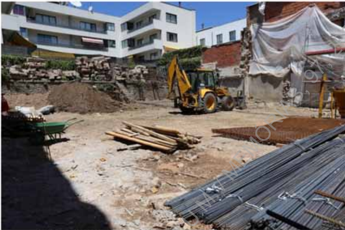
Foto 6 – Vista geral da área intervencionada após a demolição do edifício.
