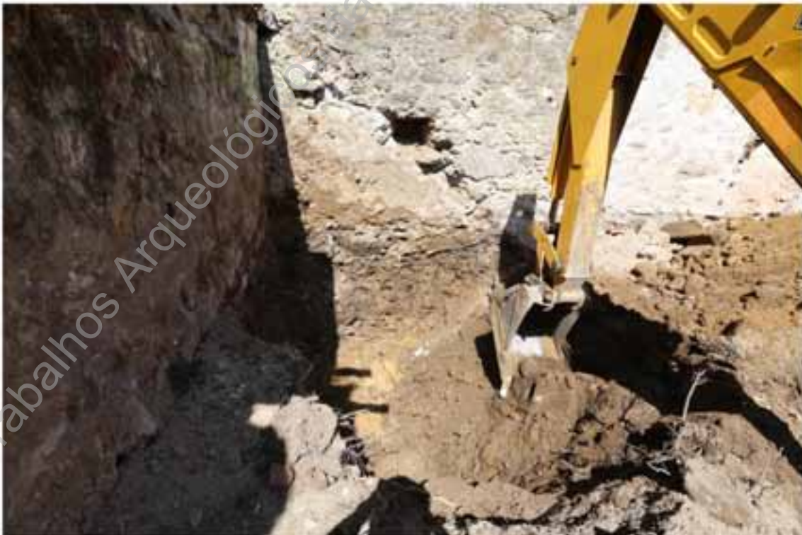
Foto 7 – Acompanhamento da abertura sapata 2.
