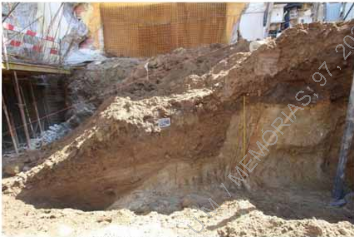
Foto 36 – Corte 1, junto à rampa de acesso às garagens.
