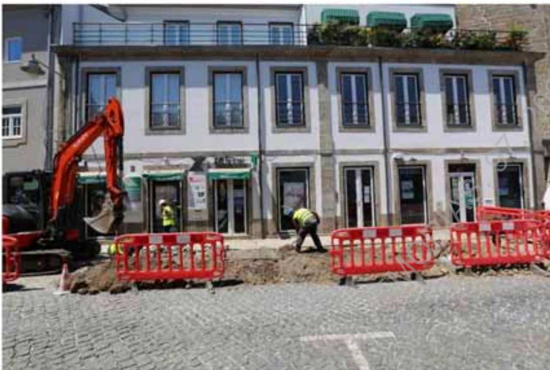
Foto 116 – Abertura da vala para implantação dos tubos de abastecimento de água pela AGERE e de energia elétrica pela EDP.
