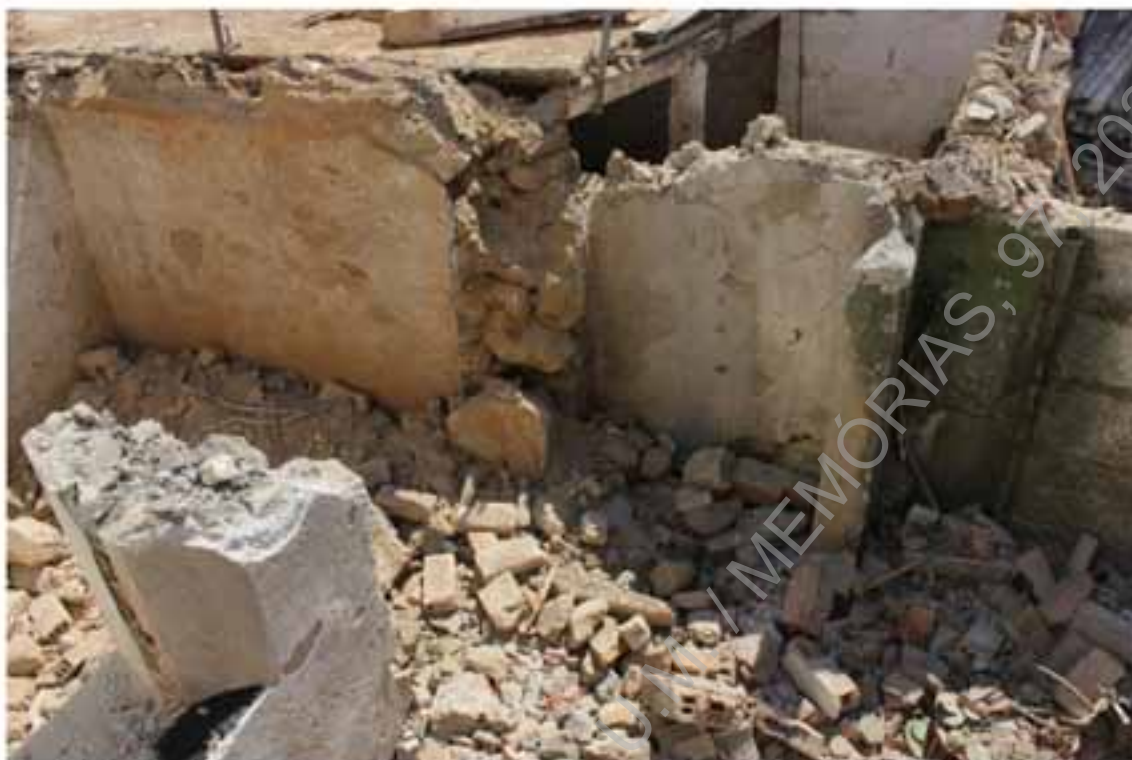
Foto 4 – Acompanhamento dos trabalhos de demolição do piso inferior da habitação.
