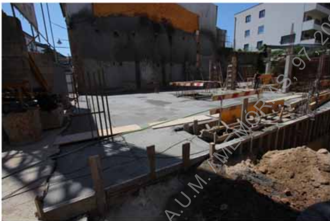
Foto 65 – Registo dos trabalhos de cimentação do rés do chão da habitação.
