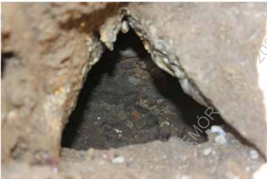
Foto 118 – Registo de uma conduta durante a abertura da vala para implantação dos tubos de abastecimento de água pela AGERE e de energia elétrica pela EDP.
