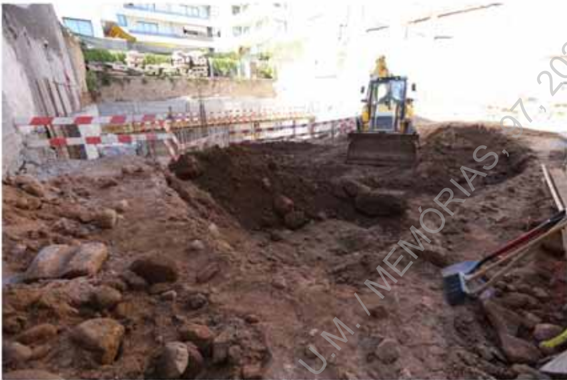
Foto 16 – Acompanhamento do desaterro na área sul.
