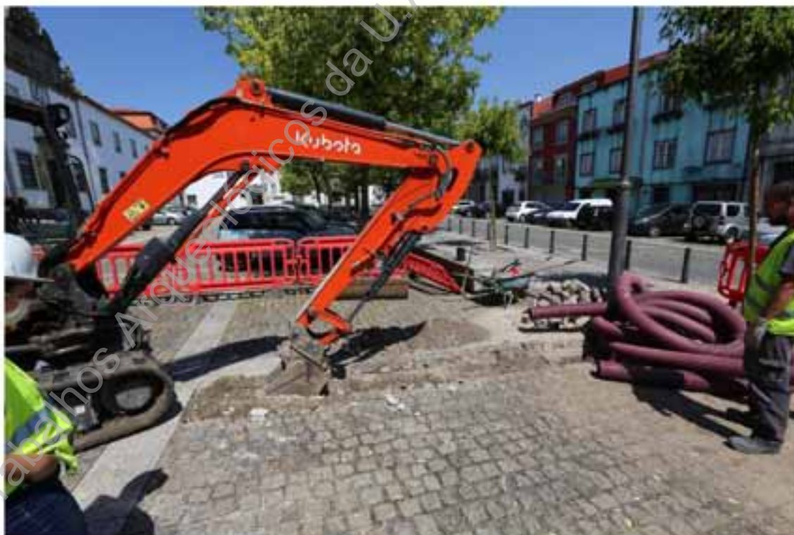
Foto 115 – Abertura da vala para implantação dos tubos de abastecimento de água pela AGERE e de energia elétrica pela EDP.
