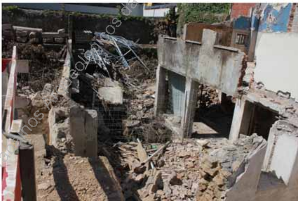
Foto 5 – Trabalhos de demolição do interior da habitação.
