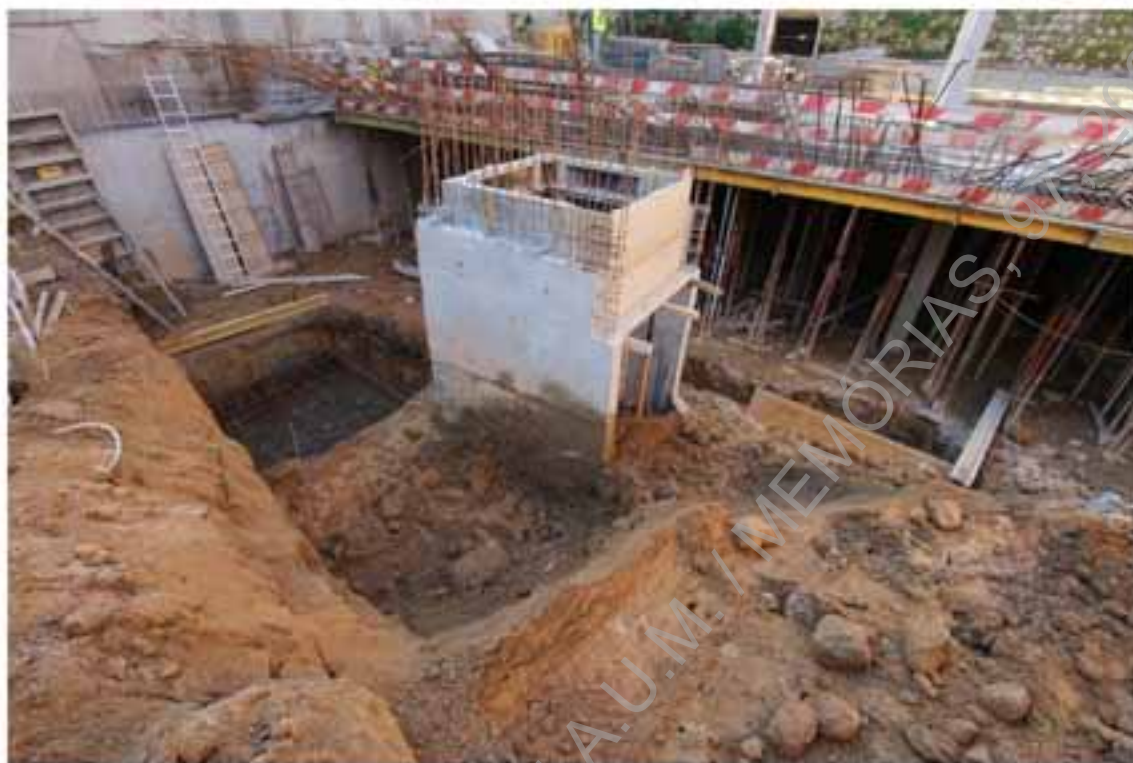
Foto 63 – Implantação da caixa do elevador.
