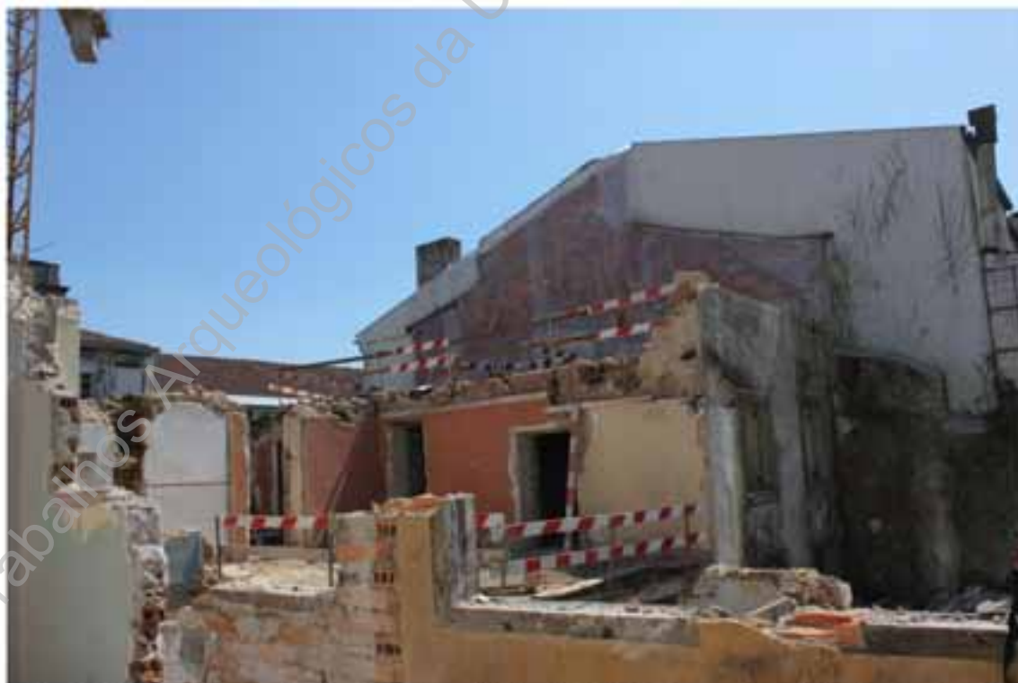
Foto 3 – Acompanhamento dos trabalhos de demolição do piso superior da habitação do nº18 e 20.
