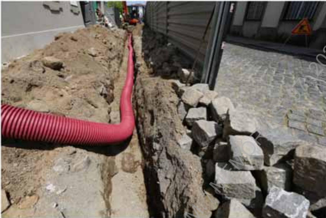
Foto 120 – Implantação do tubo de abastecimento de energia elétrica (EDP) sobre as estruturas identificadas.
