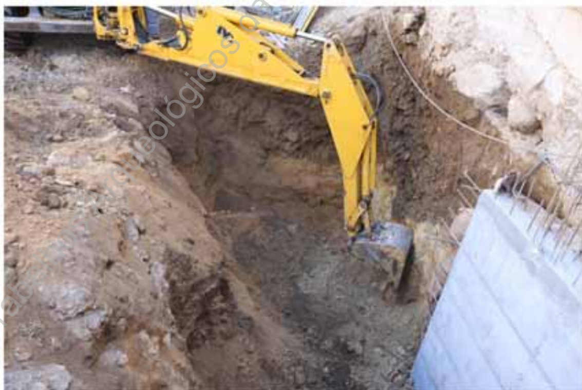
Foto 11 – Acompanhamento da remoção de terras para implantação da sapata 1.
