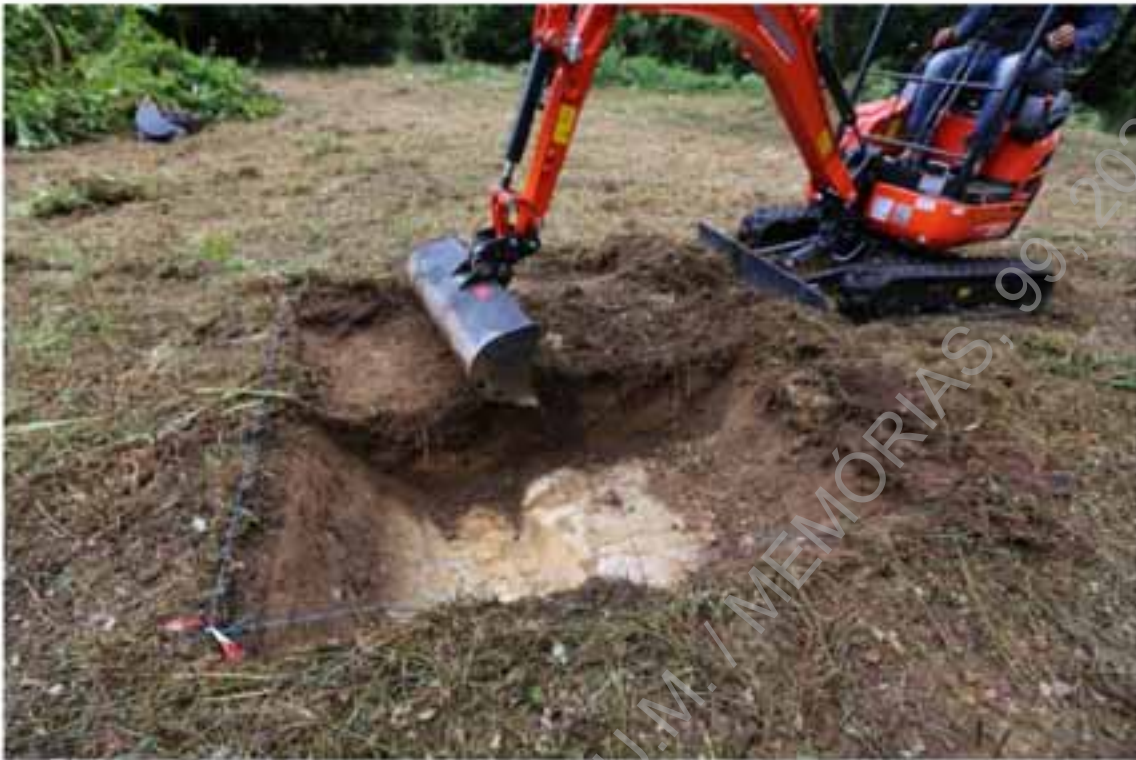
Foto 11 (Z45A5949) – Decapagem da sondagem 1.
