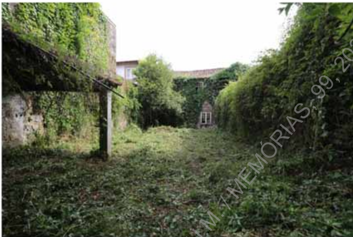
Foto 7 (Z45A5876) - Reconhecimento dos terrenos associados ao edifício.
