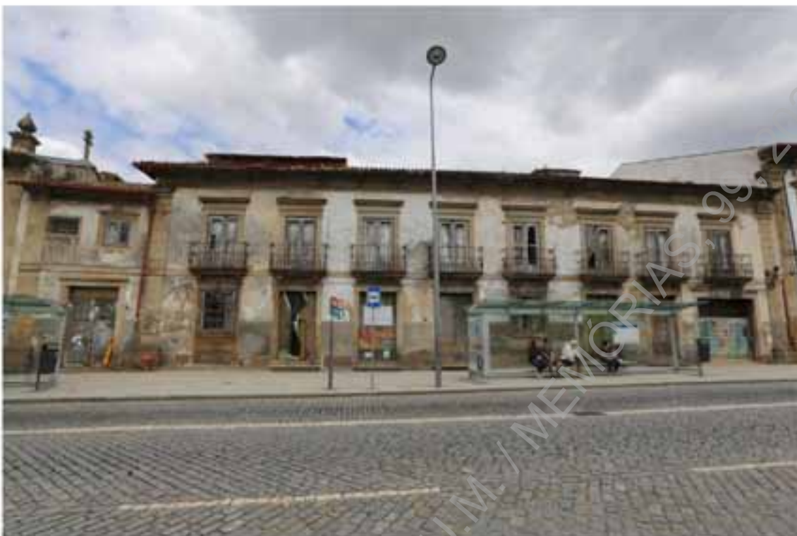
Foto 1 (Z45A6178) – Fachada do edifício localizado na Avenida Central, n° 107-117.
