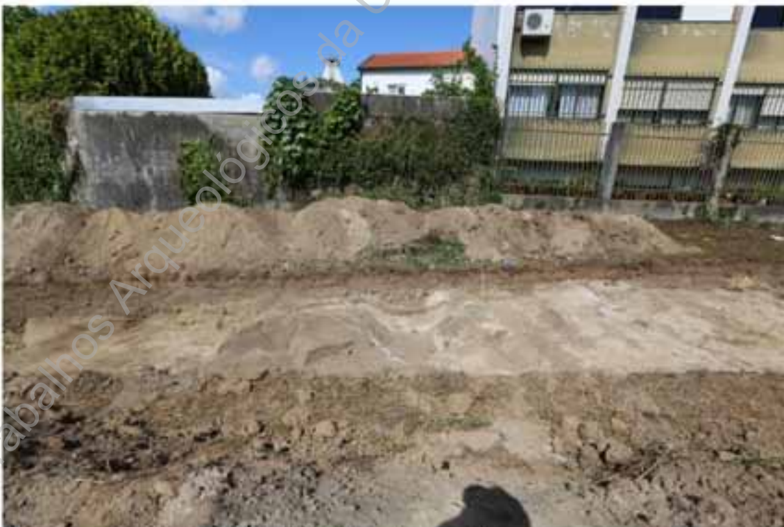
Foto 14 (Z45A6114) – Perfil oeste da sondagem 1.
