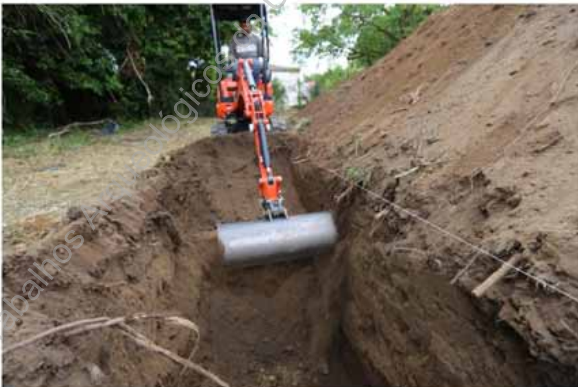
Foto 22 (Z45A6186) – Decapagem da sondagem 2.
