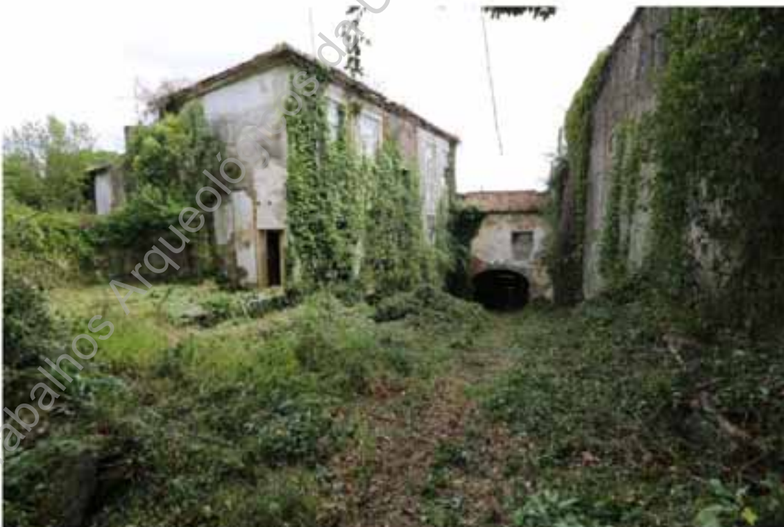
Foto 2 (Z45A5843) – Parte traseira do edifício n° 107-117 na Avenida Central.
