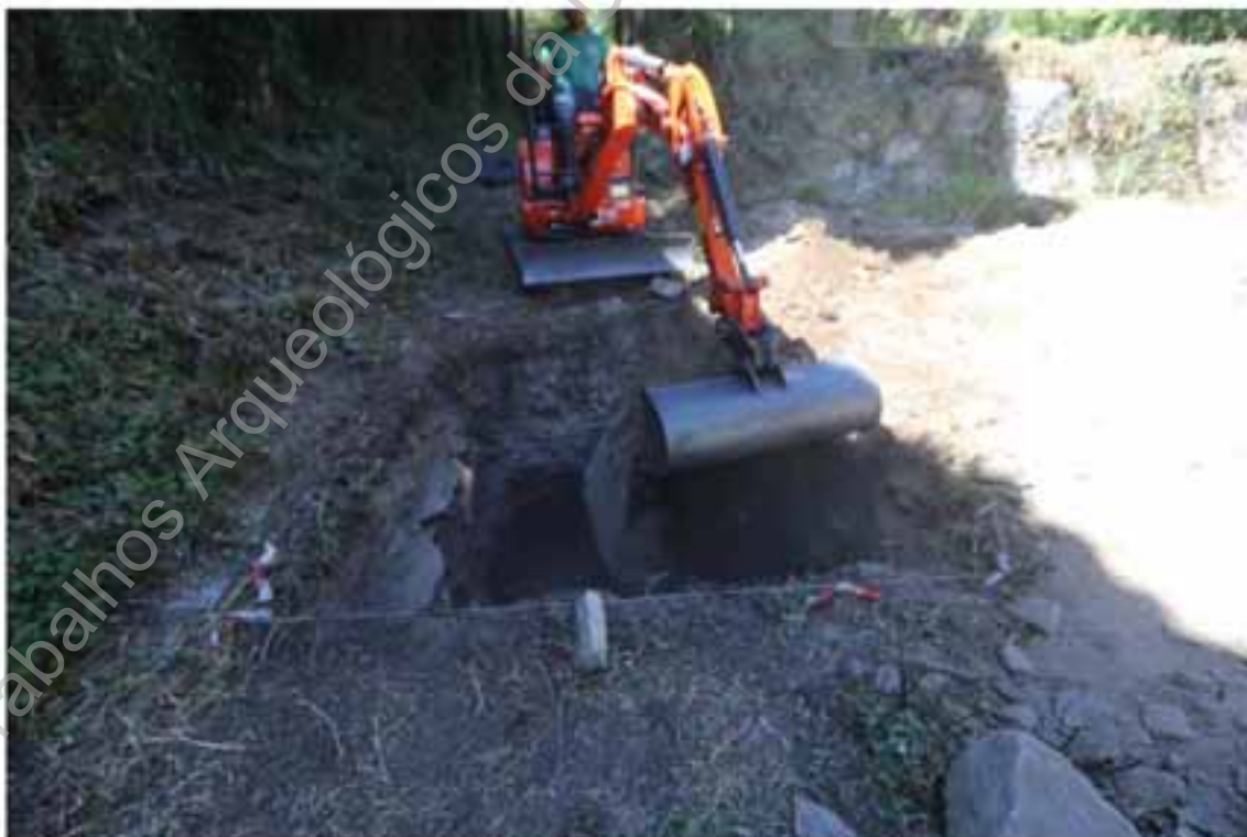
Foto 68 (IMG_9320) – Aterro da sondagem 5.
