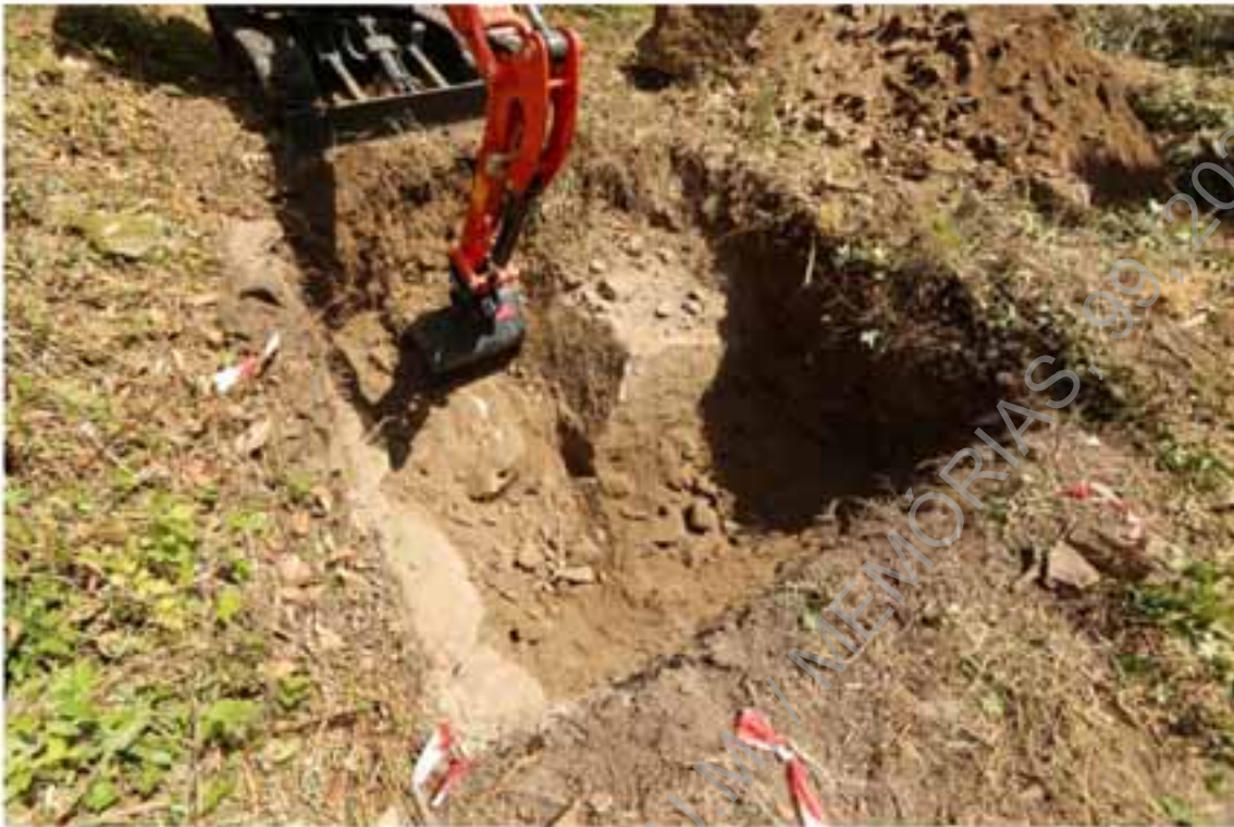
Foto 61 (Z45A6288) – Decapagem da sondagem 5.
