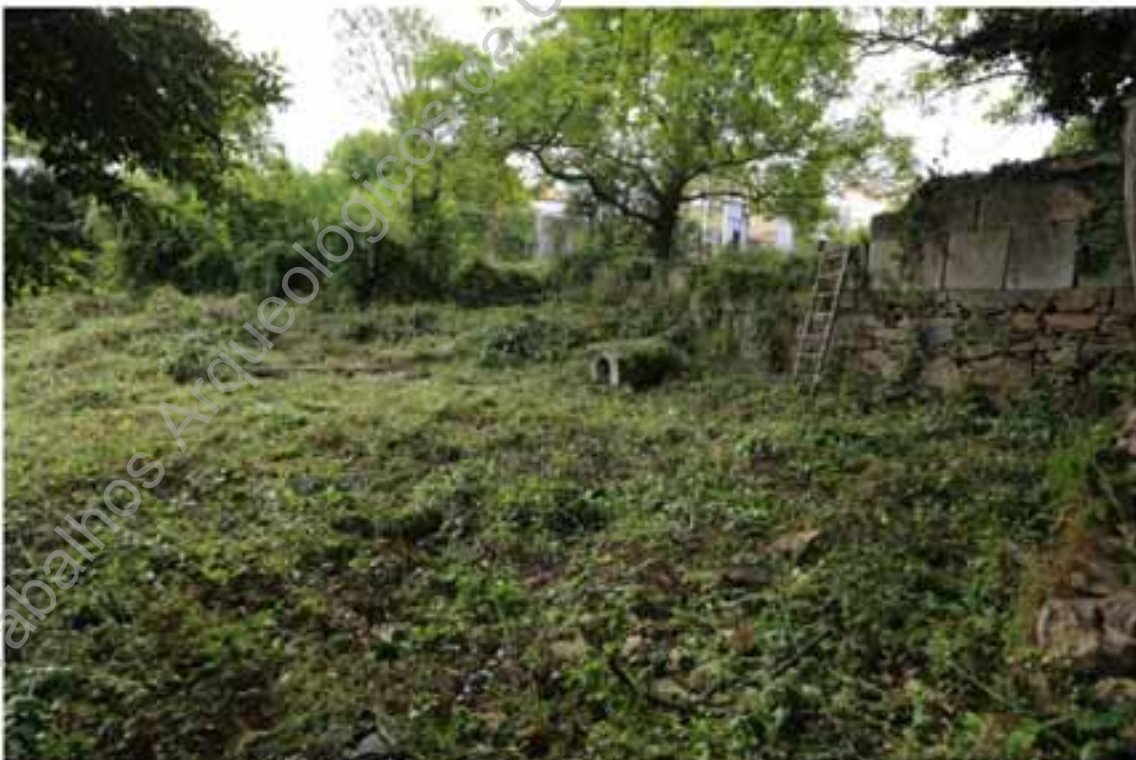
Foto 6 (Z45A5874) – Muro que define o limite da área construída.
