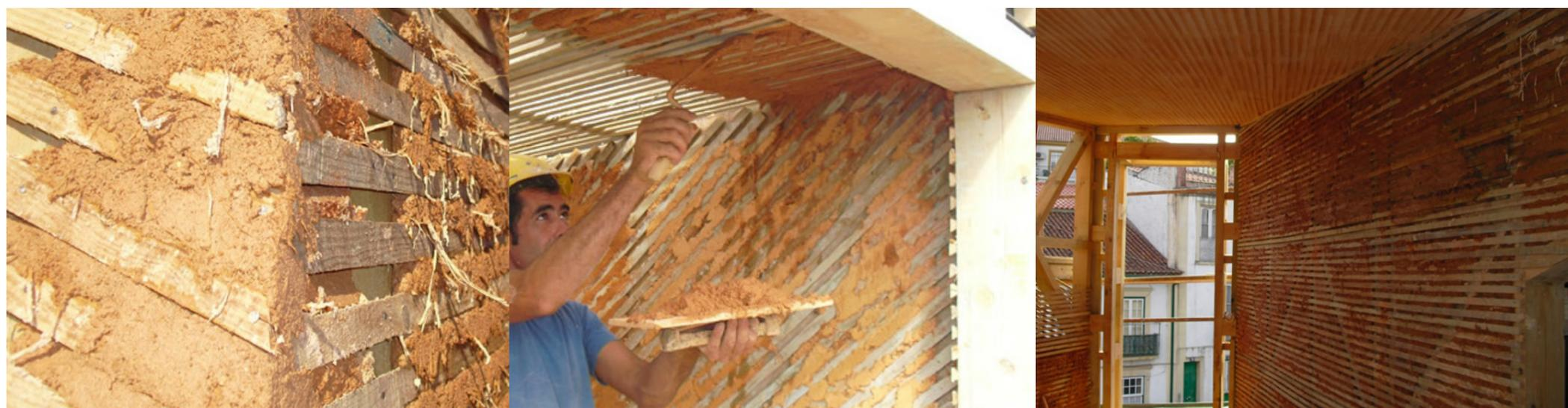
Fig.31 - Compilação de fotografias de construção em terra: tabique.
