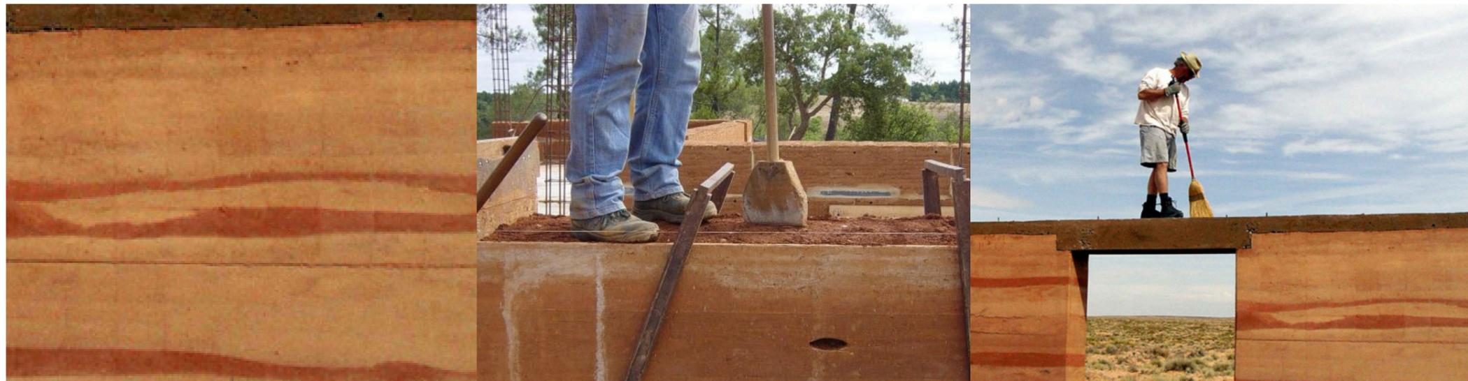
Fig.27 - Compilação de fotografias de construção em terra: taipa.
