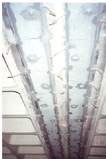
Figura 3.8 – Colocação e colagem das chapas metálicas [15]
