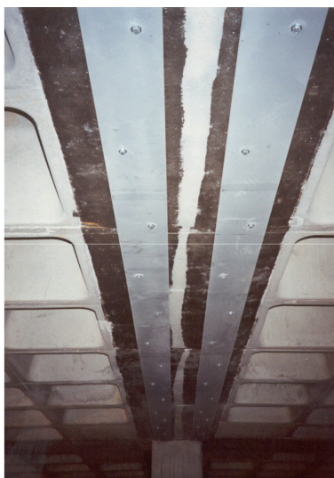
Figura 3.8 – Colocação e colagem das chapas metálicas [15]
