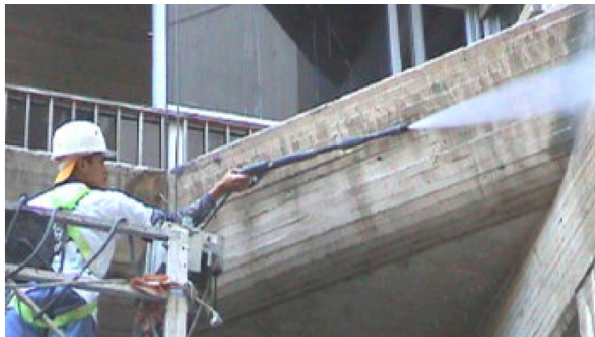
Figura 3.7 – Limpeza utilizando jato de água de alta pressão [15]
