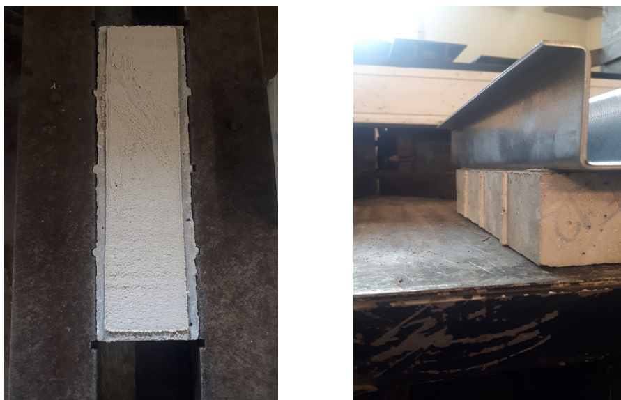
Figura 4.9 – Realização da colagem entre os elementos de aço e betão
