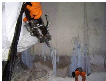
Figura 8 - Injeção de espuma de poliuretano na caixa de ar de uma parede dupla (Mundipol, n.d.)
