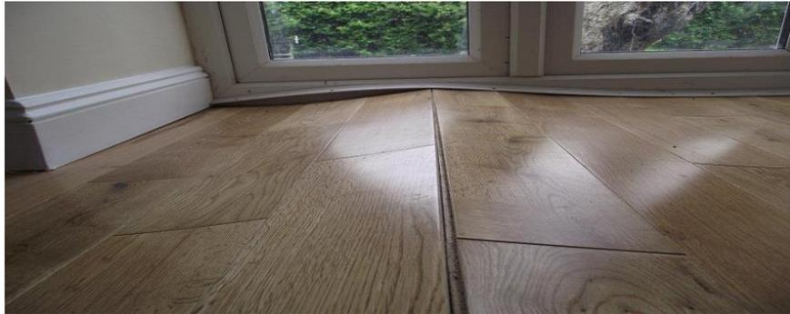
Figura 6 - Abertura de juntas entre os elementos de madeira (NFCA, n.d.)
