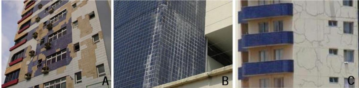
Figura 5 - Patologias mais frequentes no revestimento exterior dos edifícios (descolagem do material (A), manchas de eflorescências (B) e fissuração (C)) (Aecweb, n.d.; Oitomeio, 2017; Antunes G.,2010)
