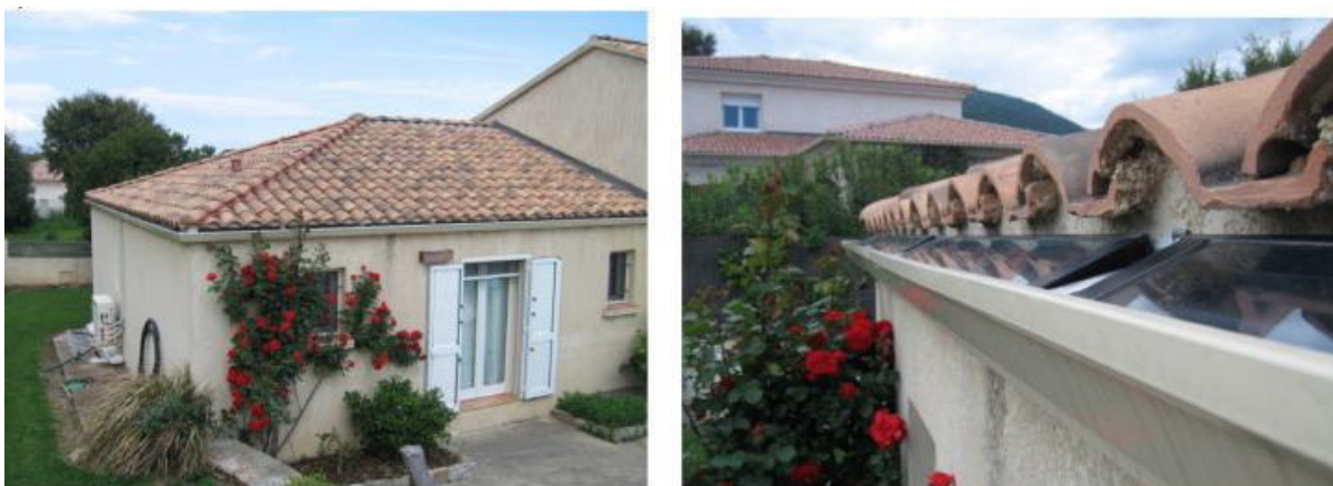
Figura 2 – Exemplo do efeito final após colocação do sistema H2OSS (Lamnatou et al., 2014)
