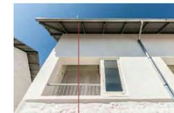
Cobertura contínua deslocada para a cota do beiral e recuo da porta de entrada deixando de estar à face da fachada. Permite assim a utilização de todos os bancos e uma maior protecção à porta. Cobertura pontual permite acesso ao banco e tanque em dia de chuva, também permite aguardar a abertura da porta protegido.
