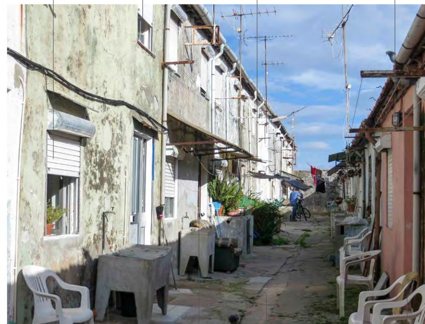
Tanque no exterior. Muitas vezes com o tubo de queda das águas pluviais a descarregar no interior. Todos os tanques da proposta incluem descarga das águas pluviais.
