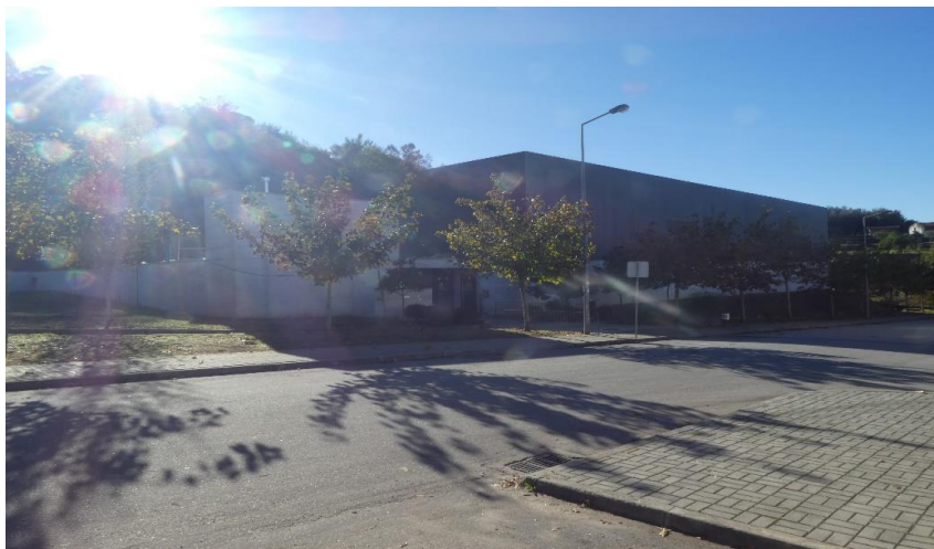
Figura 4.2.4.4.2 Pavilhão Desportivo (vista Rua da Igreja Velha)
