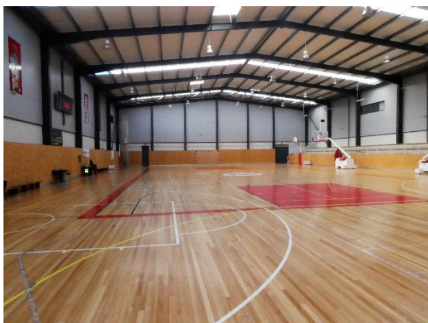
Figura 4.2.5.3. Pavilhão desportivo vista interior
