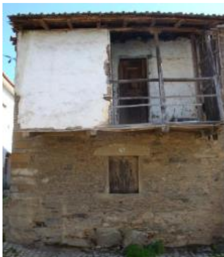
Figura 3 – Habitação com parede exterior do 1º piso em tabique (Martinho, 2010)
