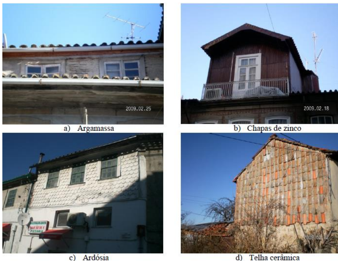
Figura 10 - Exemplos de construções de tabique que apresentam diferentes tipos de revestimento exterior (Cepeda, 2009)
