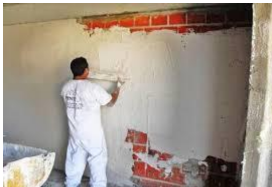
Figura 2.3-Revestimento com argamassa de gesso (Habitissimo, 2018)
