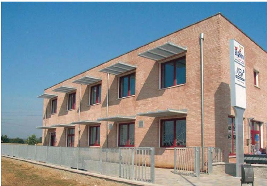
Figura 12. Protecciones solares fijas para ventanas orientadas al sur. Fuente: [alhaurindelatorre.es](http://alhaurindelatorre.es)
