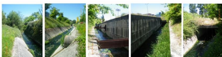
Rio Este atualmente. As linhas de água são perceptíveis através dos tubos de cimento que pontuam o rio.
