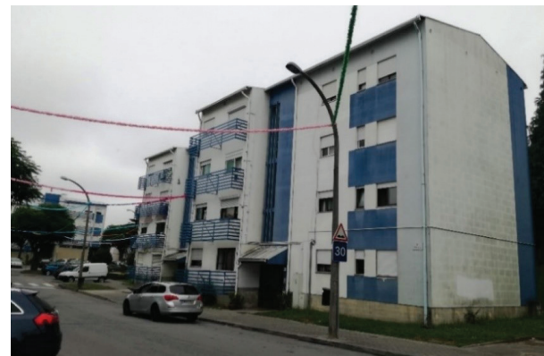
Figura 3 - Vista do edifício onde se situa a habitação analisada.
